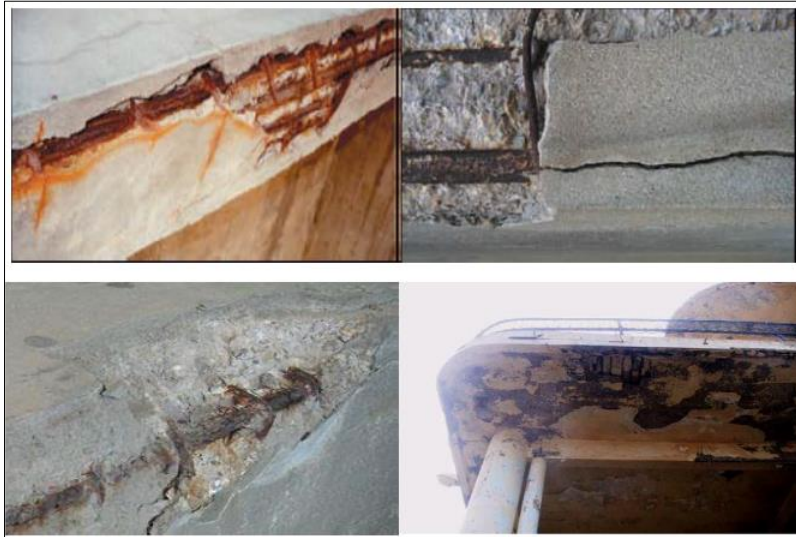
Figure 1-31 : Exemples d'éléments corrodés par carbonatation (Chaussadent, 1999)
