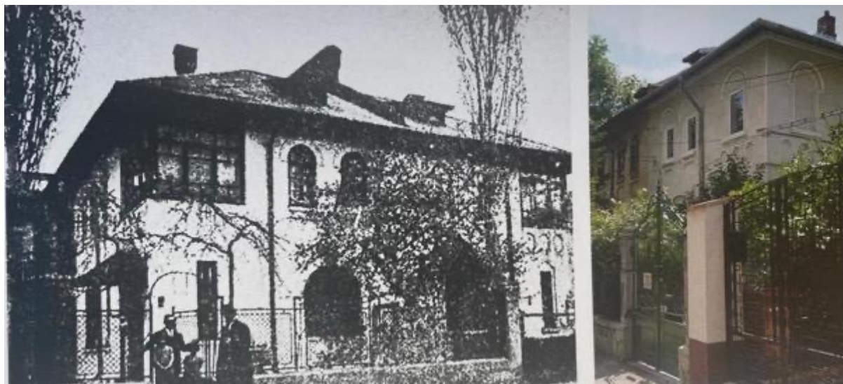
Figure 3. 2. Logement type C, rue Clucerului, Bucarest, faisant partie de la première parcelle de la Société 87
