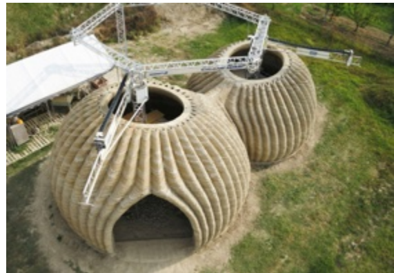
Figure 7. 4. Des structure en terre imprimée 383
