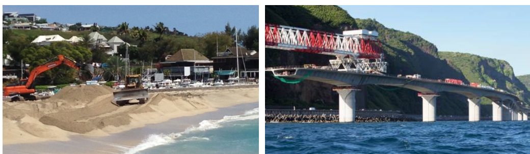
Photos 30 et 31 : Travaux sur la plage de St Gilles les bains (à droite) et construction de la Nouvelle Route du Littoral (NRL) dans le nord de l'île (à gauche)
