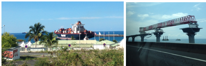
Photos 54 et 55 : Infrastructures au Port et travaux de la NRL
