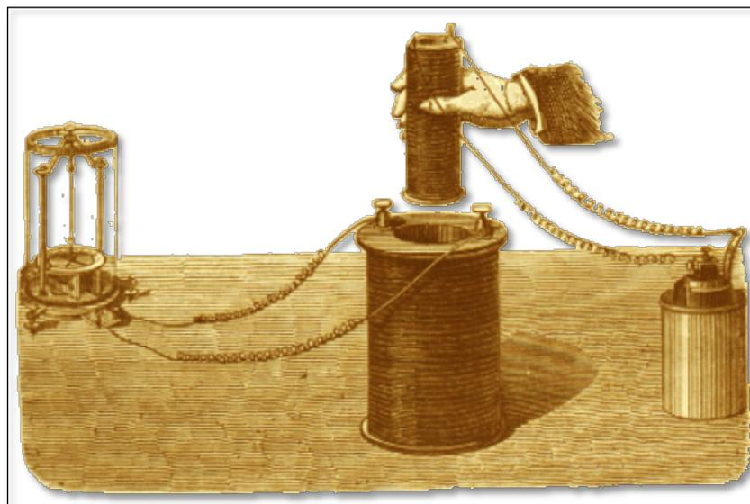
**Figure 5:** Expérience originale de Faraday ayant mené à la découverte de la loi sur l'induction magnétique. (D'après [www.cinq.ulaval.ca](http://www.cinq.ulaval.ca)).
