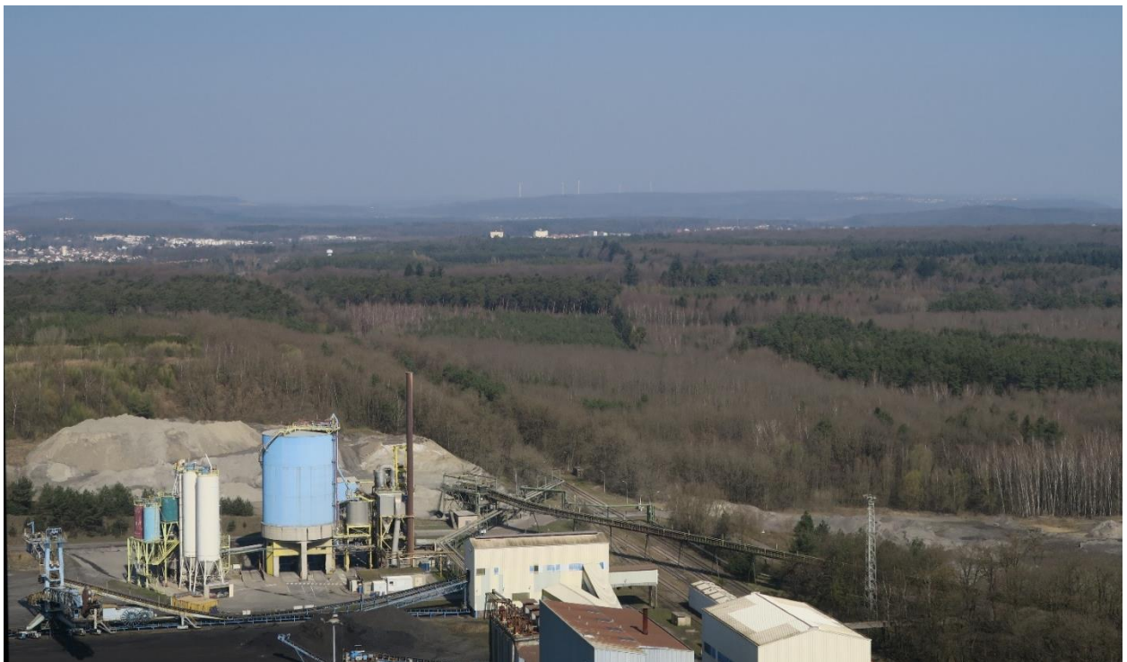
Photo 11. Vue depuis la centrale thermique de Saint-Avold. En premier plan, le parc à charbon et à cendres et les forêts protégées. En arrière-plan, les parcs éoliens allemands, juin 2023.
