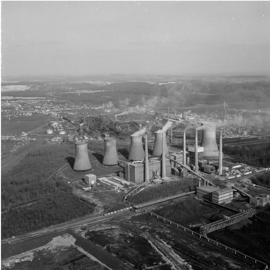
Photo 9. Vue aérienne de la centrale Emile Huchet, avec en arrière-plan la plateforme de Carling. Photo de G. Friedrich prise en octobre 1971. Source : Fonds photo Lorrain.
