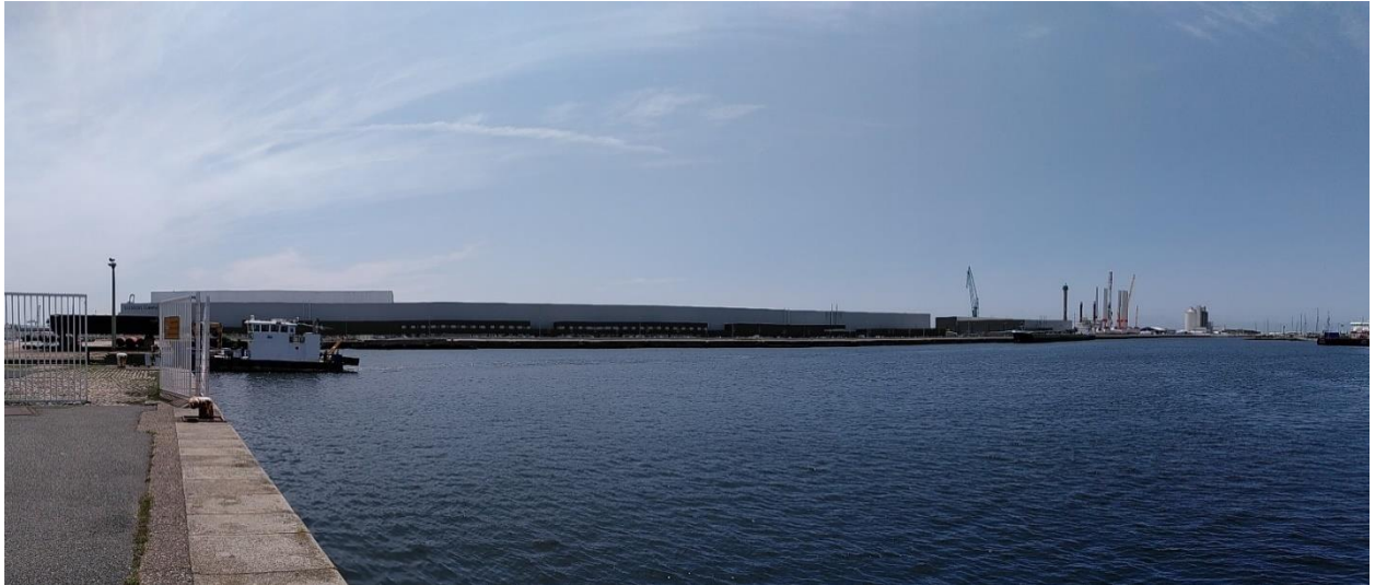
Photo 3. L'usine de construction des pales et des nacelles d'éoliennes de Siemens Gamesa, à proximité de la centrale thermique, juin 2023.
