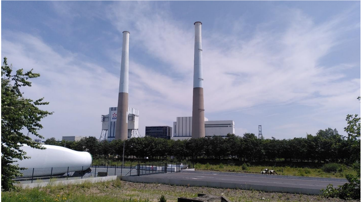
Photo 1. La centrale thermique du Havre avec, à gauche, l'espace de stockage des pales d'éoliennes en construction, juin 2023.
