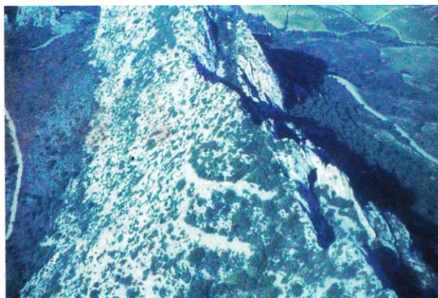
Figure 35 : Vue aérienne de l'oppidum du Roc Treucat (Lesquerde). Cliché : F. Claustre (CAG.66, fig. 385, p. 401).
