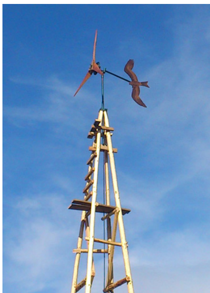
(a) Mât treillis réalisé en bois.
