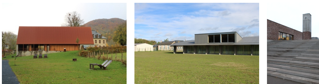
Station de pleine nature de Mandailles-Saint-Julien, Atelier du Rouget, 2019 Salle polyvalente de Saint-Jean-du-Bois, Atelier Julien Boidot & Emilien Robin architectes, 2017 École primaire de Pontailier-sur-Saône, BQ+A, 2014 Photographies (E.C.)
