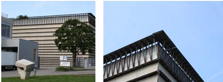
Entrepôt Ricola à Laufen, Herzog et de Meuron, 1986-1987 Photographies (E.C.)
