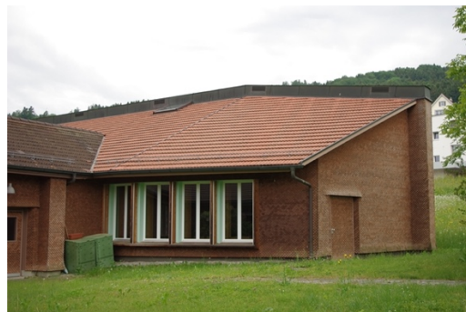
Extrémité de l'édifice
