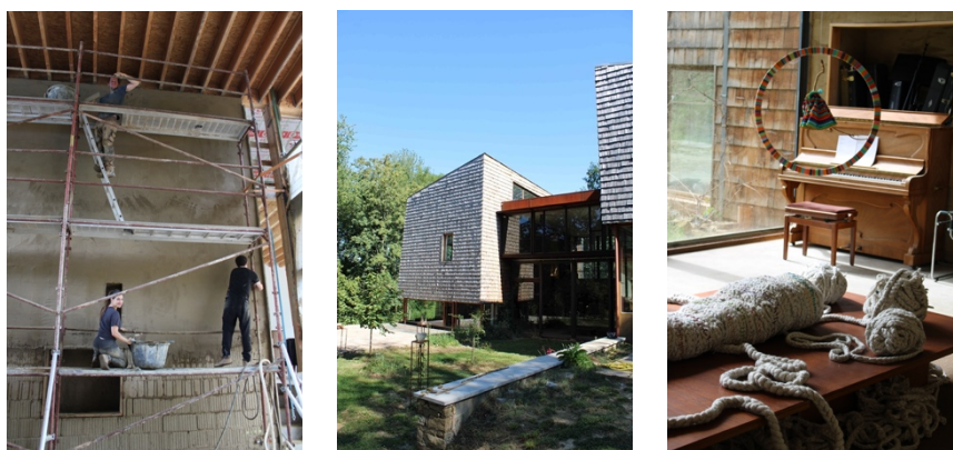
Habitat solidaire à Montagnet, Atelier Éric Furnémont, 2017-2024 Photographie chantier participatif, constructions, exposition Pauline Bourguignon (E.C.)
