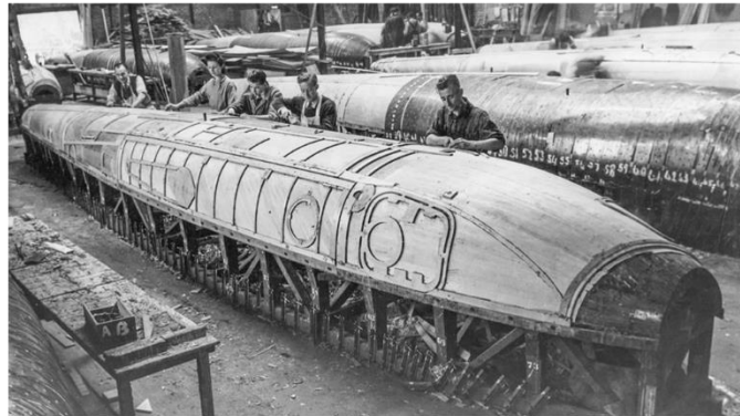
(b) Fuselage moulé en structure sandwich du « Mosquito ».
