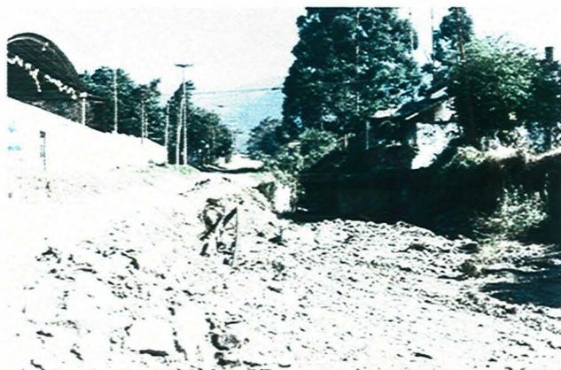
c - La rue Uttinger à Tafi Viejo, réduite à un chemin de terre par l'élargissement du fossé qui la borde, dégageant à l'air libre des tuyauteries. Le tracé rectiligne de la rue dans le sens de la pente facilite sa transformation en torrent lors des orages.
