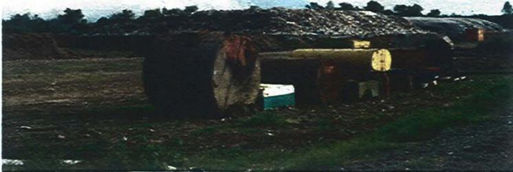
b - Les différents stades de l'évolution des cellules de stockage : au fond, elle est entièrement fermée, au centre en cours de remplissage, au premier plan, la fosse vient d'être creusées.
