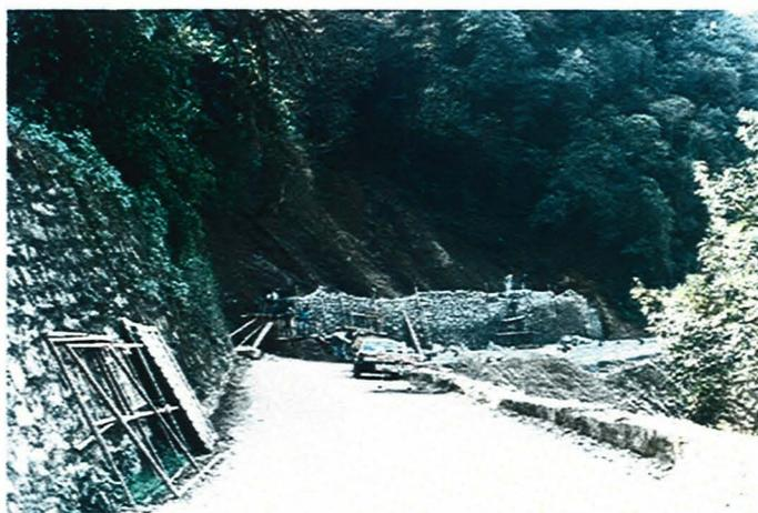
b - Construction d'un mur de protection contre les éboulements sur la route qui mène au sommet de la Sierra de San Javier. La protection de la végétation est insuffisante pour empêcher les phénomènes de solifluxion en raison des caractéristiques de la lithologie, du matériel superficiel de versant, du climat et de la forte pente. Ceci est d'autant plus vrai lorsque la rupture de l'équilibre est provoquée, comme ici par la route.
