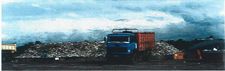
a - Les camions déposent les déchets solides dans une cellule protégée du sol par une épaisse membrane.
