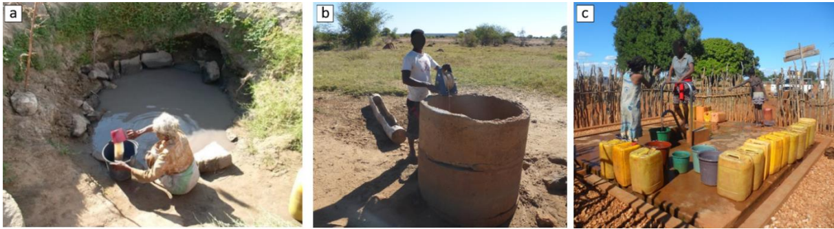
Figure 26 : Illustrations des trois types de puits dans le bassin d'Ankazomanga (district Betioky-Atsimo). a) puits traditionnel ; b) puits cimenté ; c) forage moderne créé avec Action Contre la Faim (Carrière et al. 2023).
