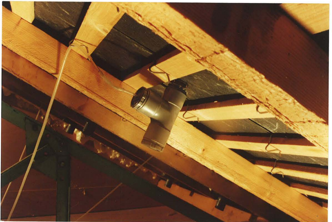
Figure 5.12. : Prise de pression avec pot de rétention.
