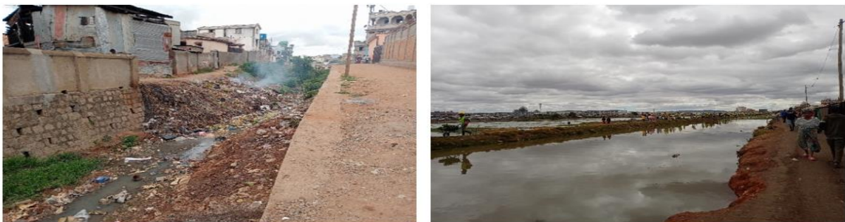
Photo 2 : Canal de drainage en zone II (à droite) et canal d'irrigation en zone III (à droite) - © A. V. Andriamanga
