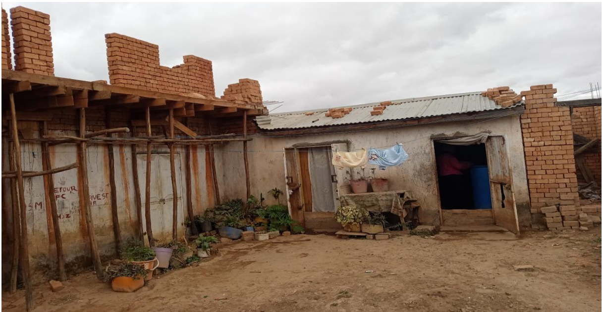
Photo 10 : La parcelle de Niry bâtie, avec des extensions
