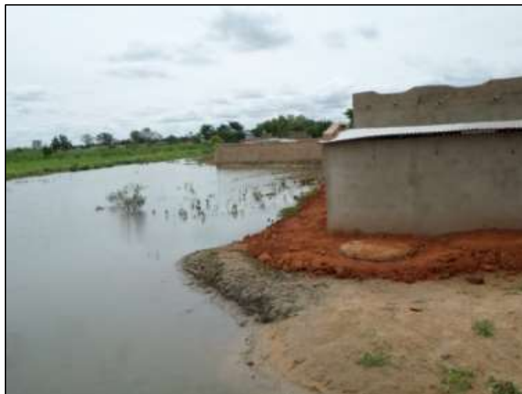
Photo 9 : Construction d'habitations dans le périmètre de Konni
