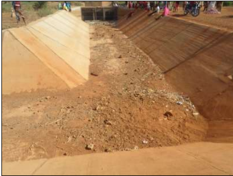
Photo 17 : Canal d'écoulement d'eau réhabilité
