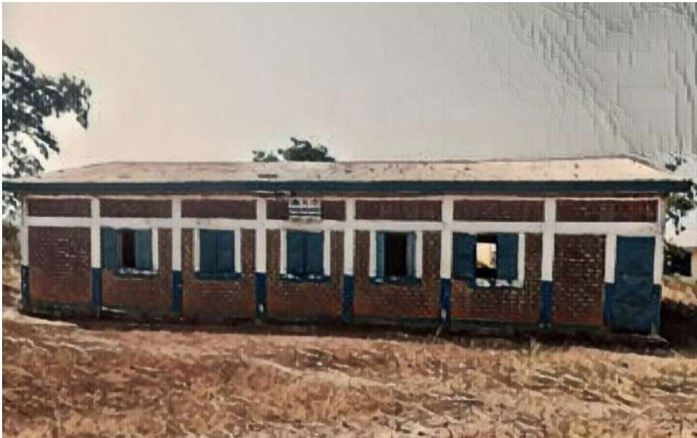
Figure 31. Bâtiment initialement pressenti pour accueillir le centre de formation
