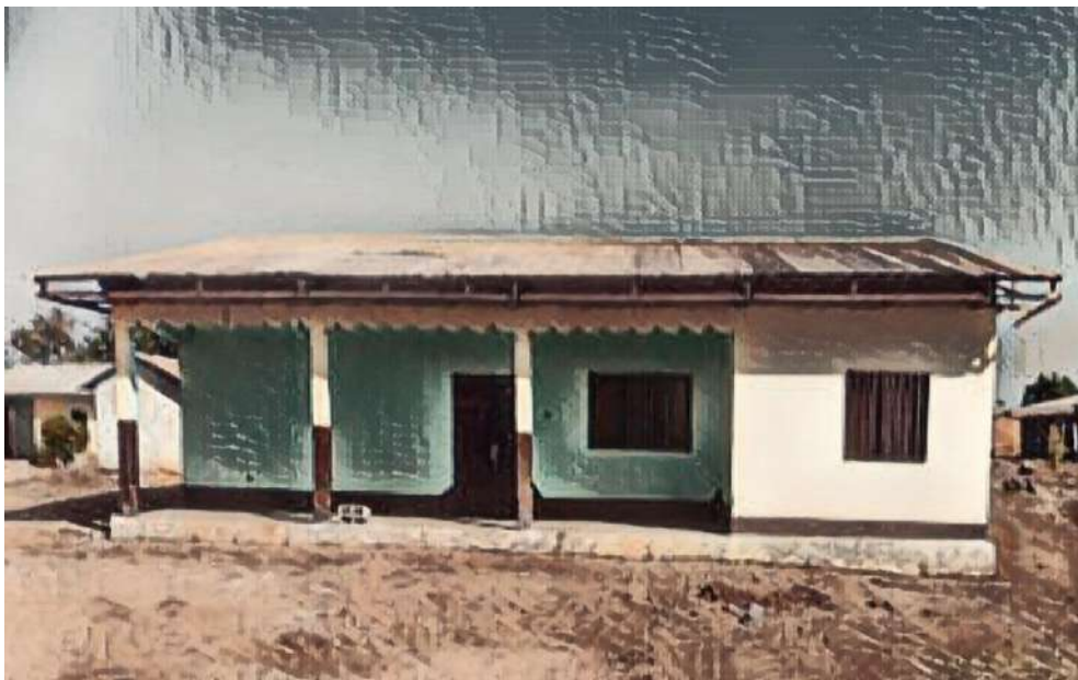
Figure 32. Bâtiment finalement mis à disposition de l'ONGI par le chef de Gado-Badzere
