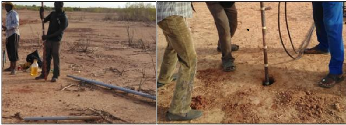
Figure 38. L'installation des tubes d'accès à la sonde à neutrons. À gauche, les tubes en PVC utilisés, à droite (b), la mise en exécution de l'installation des tubes avec une tarière motorisée.
