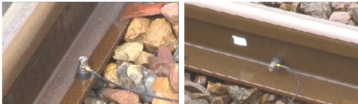
Figure 89 - Mesures accélérométriques sur le rail (verticale à gauche, latérale à droite)
