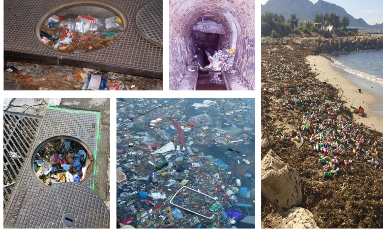
FIGURE 1.2 – Exemples d'engorgement subi des avaloirs et des nuisances qui en résultent.
