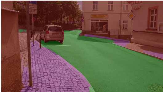
A. Trottoir pavé
