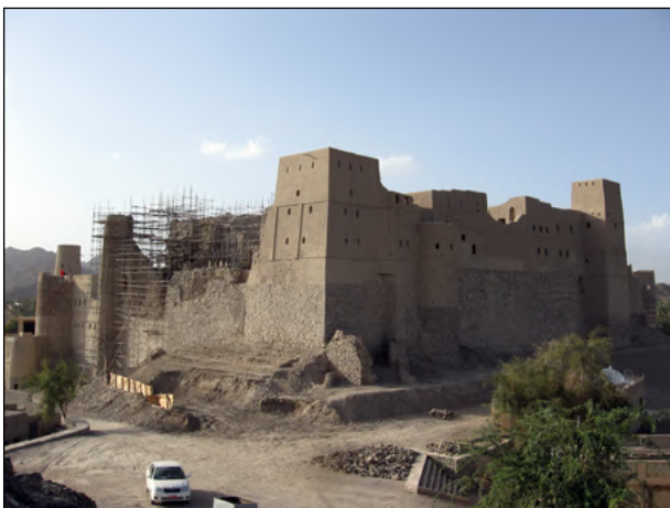
Figure A6.64 : Bahla. Le fort en cours de restauration. [Anonyme, 2009]
