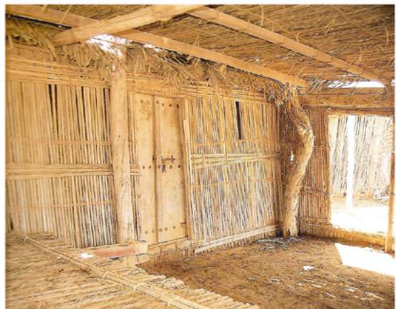
Parois et toiture d'une maison en rachis de palmes (Richardson & Door 2003)
