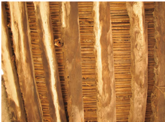
Toiture en tronc et rachis de palmes, Nizwa (O. Munoz)
