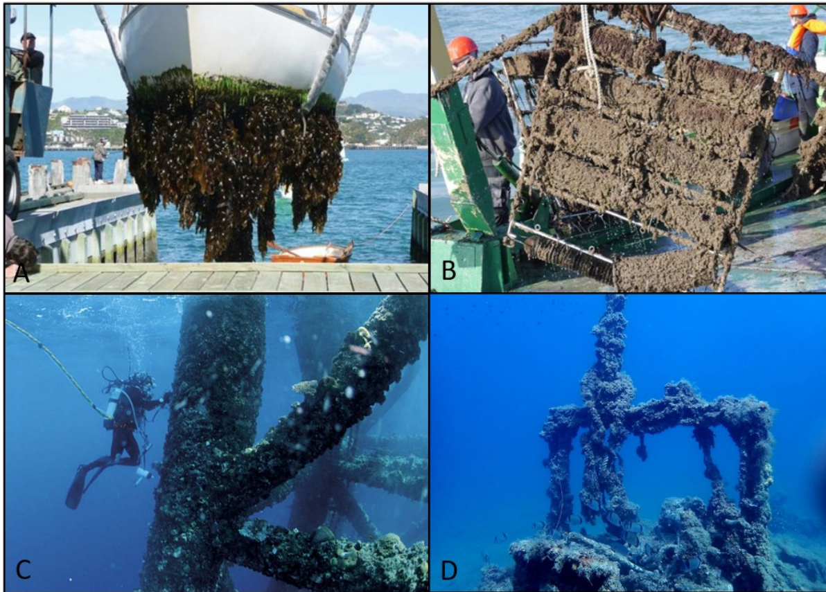
Figure 1.9 : Biofouling présent sur diverses structures immergées en mer. (A) Coque d'un bateau. (New Biofouling Regulations © Ministry for Primary Industries) (B) Structure aquacole Kiel Marine Farm (KMF) ( https://www.h2020united.eu/ ) (C) Structure offshore en cours de nettoyage. (Seatrade Maritime News, https://mfame.guru/bio-fouling-ballast-water-barnacle-bill/ ) (D) Epave d'un tractopelle immergé dans la baie de Banyuls-sur-Mer depuis 1983. Fanny Clergeaud, 2022
