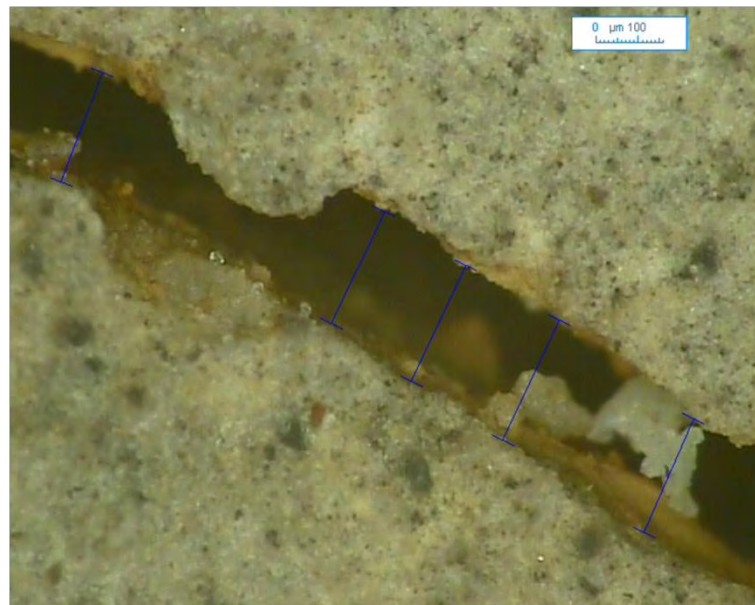
Figure III-62 : Image de la fissure sur l'éprouvette P-2 après déconfinement ( w' = 250 \mu\text{m} )
