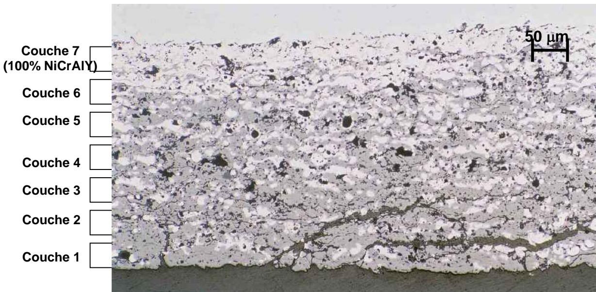
Figure 4.26. Illustration de la fissuration dans l'épaisseur de la céramique [184]
