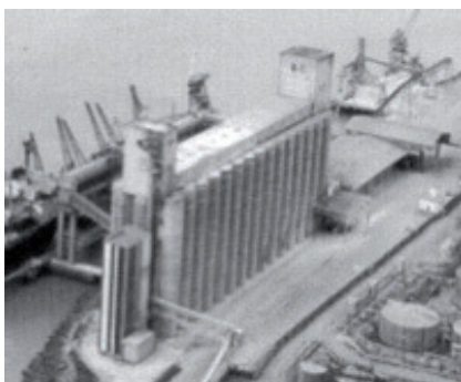
FIG. 2.8 – Silo avant l'accident.
