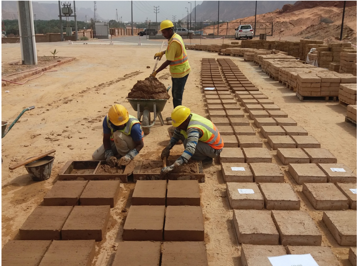
Figure 64 : Dans la vieille ville d'al-'Ulā, des ouvriers versent un mélange d'argile et de paille dans des moules pour la fabrication de briques, photo de l'entreprise HCC prise le 12 mars 2020 disponible sur l'URL : < https://hcc-heritage.com/projet/chantier-pilote-et-etudes-pour-la-conservation-et-la-documentation-architecturale-de-la-vieille-ville-dalula/ >.
