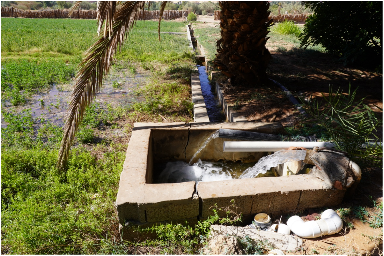
Figure 54 : Système d'irrigation gravitaire, par inondation de planches de culture, vieille palmeraie d'al-'Ulā, octobre 2021.
