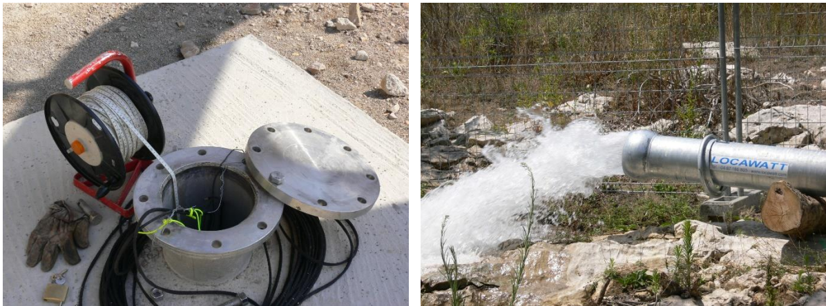
Essai de pompage de longue durée sur le système karstique des Cent-Fonts
