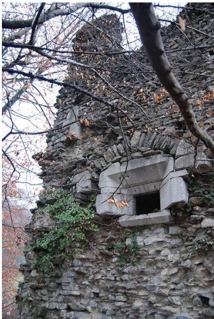
Fig. 8: Vestiges d'ouvertures sur un pan de la tour. Cliché : L. Benoit.
