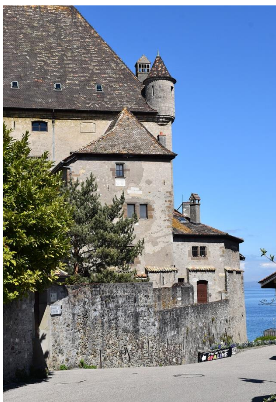
Fig.8: Tour d'escalier du château. Cliché : L. Benoit.
