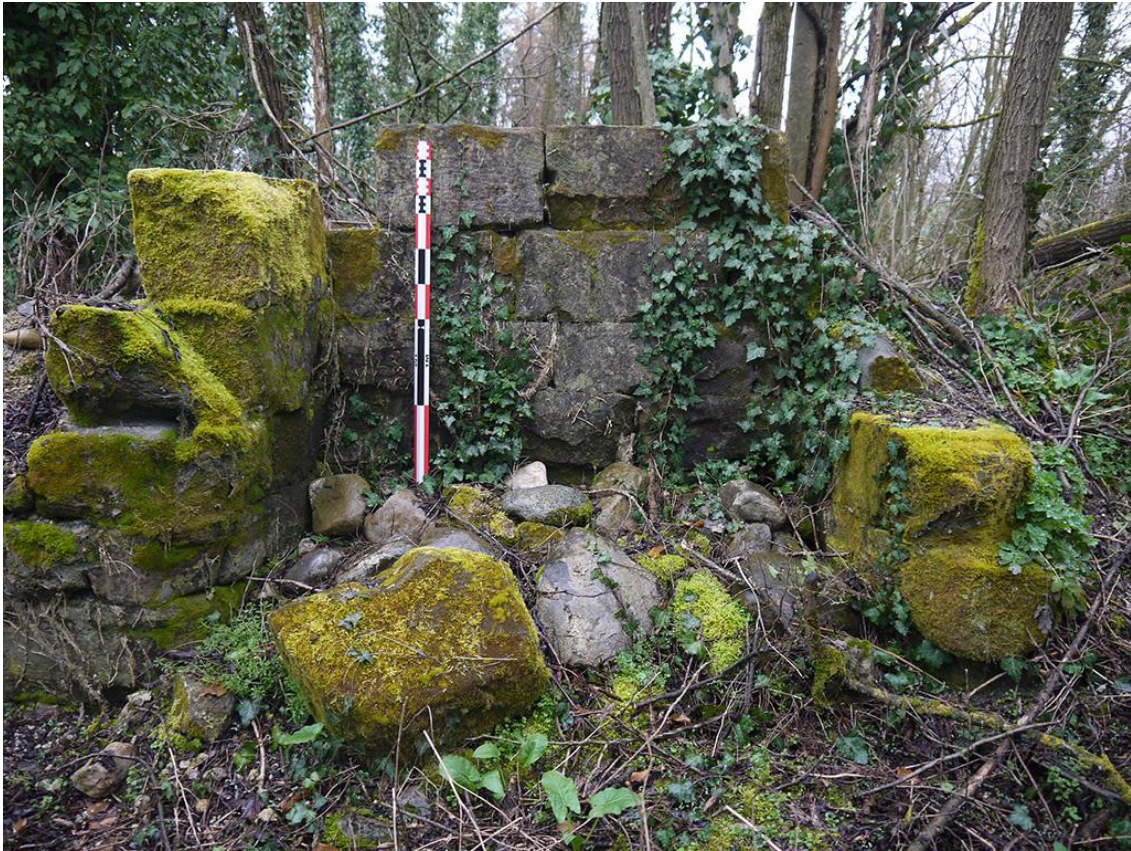
Fig. 3: Vestiges de la cheminée de la tour maîtresse. Cliché : L. Benoit.
