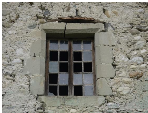
Fig. 15: Fenêtre à linteau plat et piédroits chanfreinés en molasse. Cliché : L. Benoit.
