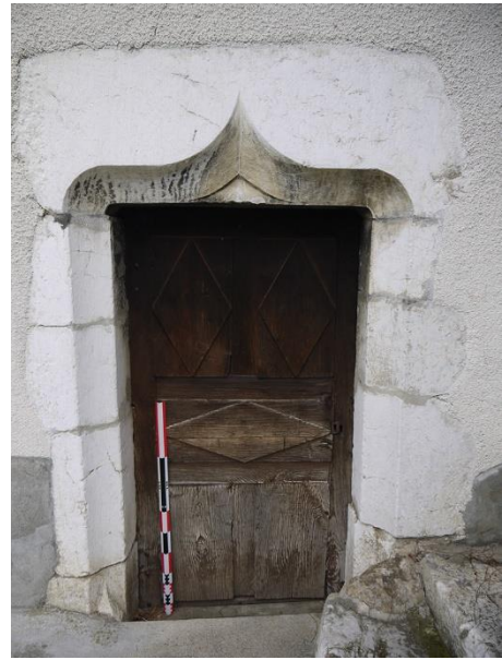
Fig. 7: Exemple de porte à linteau à accolade. Cliché : L. Benoit.
