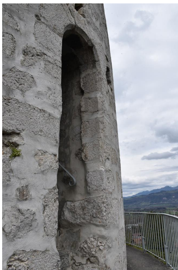
Fig. 4: Accès à l'intérieur de la tour. Cliché : L. Benoit.
