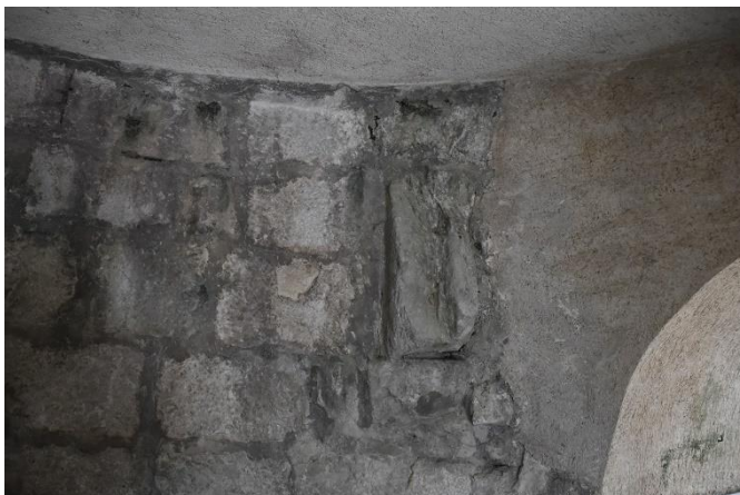
Fig. 8: Parement intérieur de la tour. Cliché : L. Benoit.
