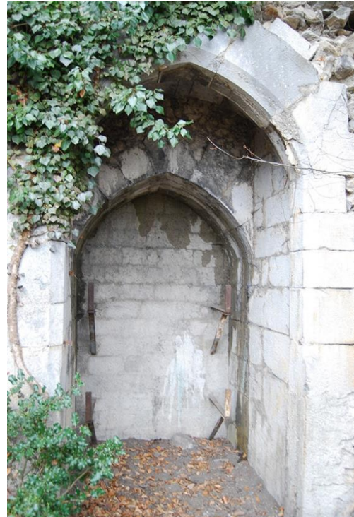
Fig. 7: Porte d'accès au rez-de-chaussée de la tour. Cliché : L. Benoit.
