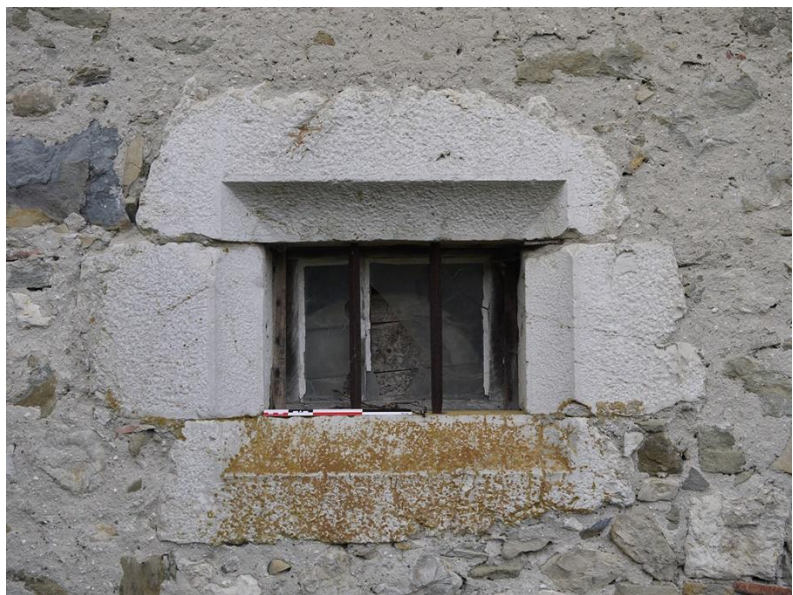
Fig. 10: Petite ouverture rectangulaire en calcaire. Cliché : L. Benoit.
