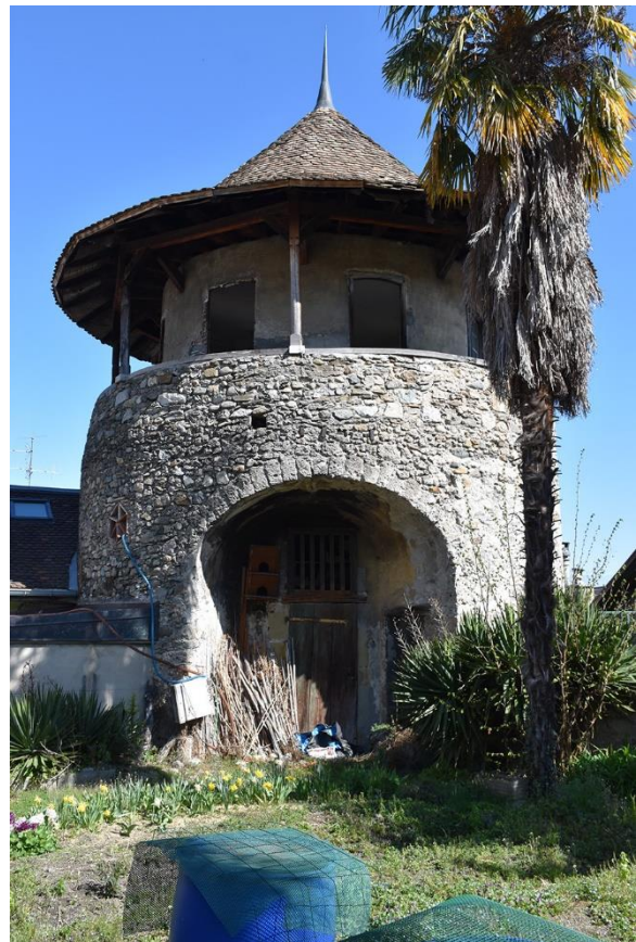
Fig. 2: Vue générale de la tour du château d'Evian. Cliché : L. Benoit.
