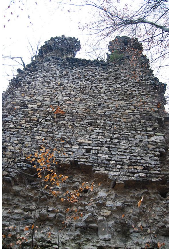
Fig. 5: Appareil de construction en moellons. Cliché : L. Benoit.
