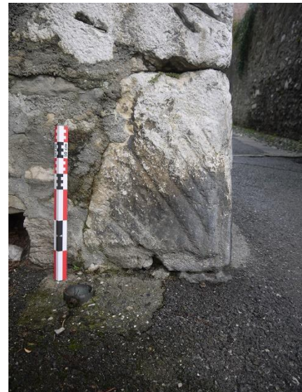
Fig. 13: Traces de laie, de broche et de ciseau. Cliché : L. Benoit.
