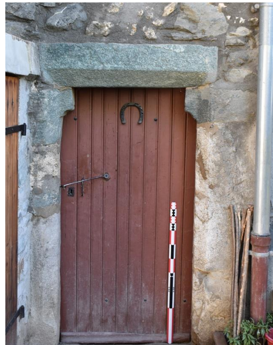
Fig. 7: Porte à linteau plat reposant sur coussinets. Cliché : L. Benoit.
