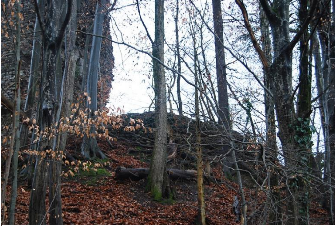
Fig. 9 : Probable logis au pied de la tour d'Ugine. Cliché : L. Benoit.
