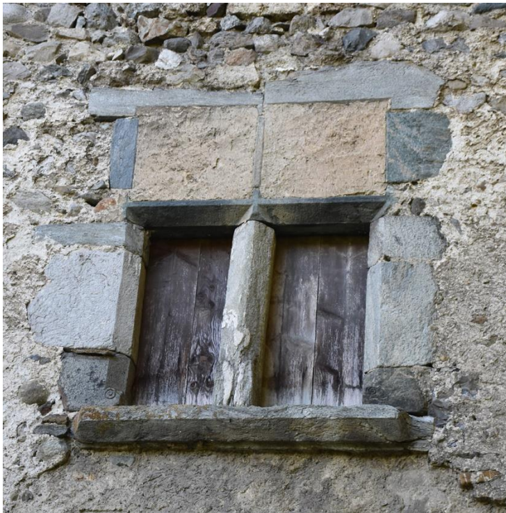
Fig. 8: Fenêtre à meneau et croisillons partiellement bouchée. Cliché : L. Benoit.
