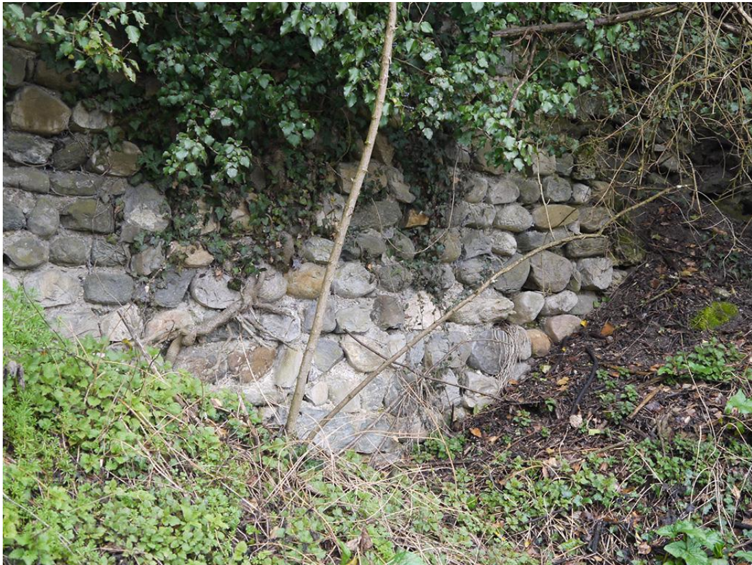
Fig. 6: Parement extérieur de la courtine du château. Cliché : L. Benoit.
