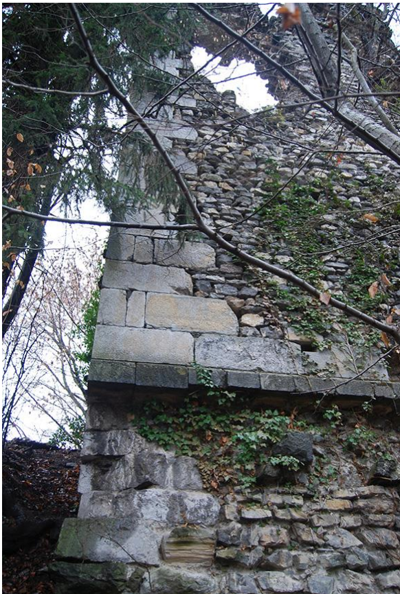
Fig. 6: Utilisation de la pierre de taille sur la tour d'Ugine. Cliché : L. Benoit.
