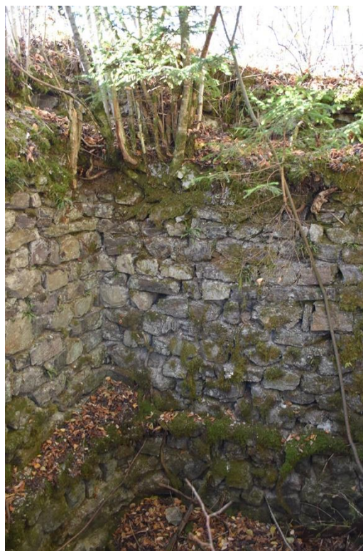
Fig. 5: Elévation intérieure de la tour maîtresse de Flumet. Cliché : L. Benoit.
