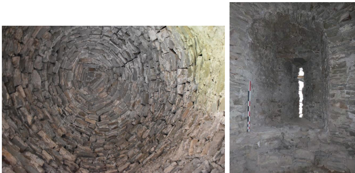
Fig. 16: Voûte maçonnée et archère du niveau inférieur. Clichés : L. Benoit et S. Bocquet.
