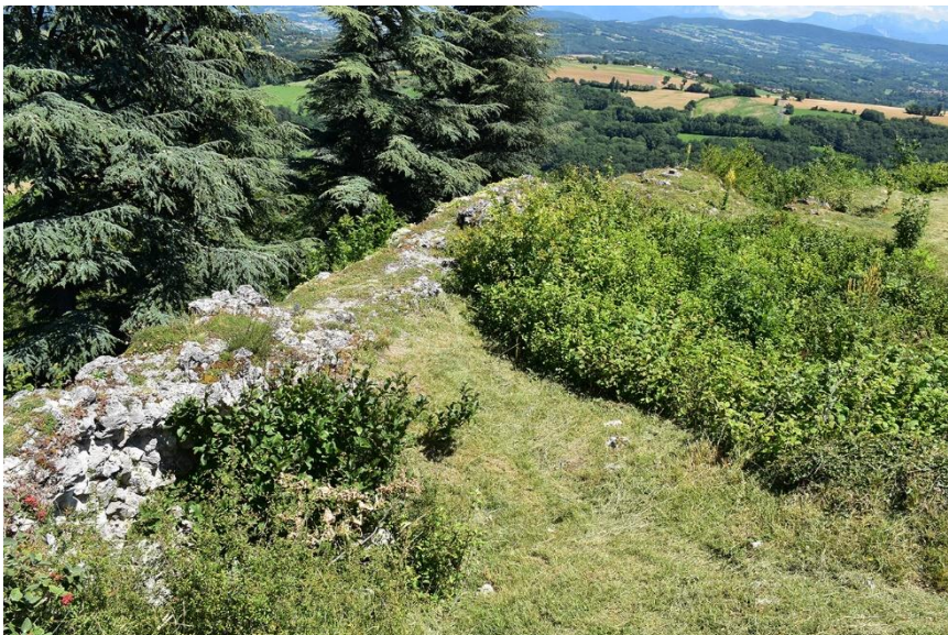
Fig. 7: Courtine dépassant de la terre végétale. Cliché : L. Benoit.
