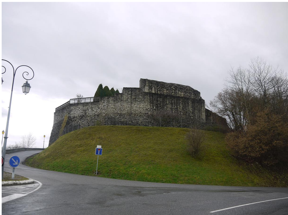
Fig. 2: Vue générale du château de Bonne. Cliché : L. Benoit.
