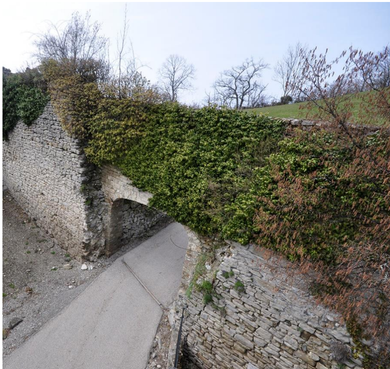
Fig. 14: Chemisage de la courtine sud. Cliché : L. Benoit.
