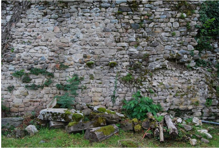
Fig. 10: Tronçon de courtine au sud. Cliché : L. Benoit.
