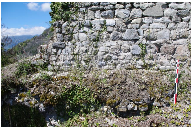
Fig. 4: Parement intérieur de la tour et départ de voûte. Cliché : L. Benoit.
