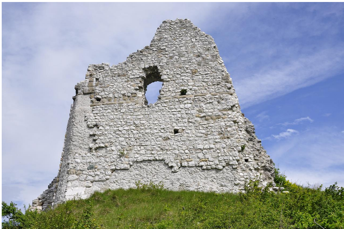
Fig. 4: Parement extérieur du mur ouest. Cliché : L. D'Agostino.
