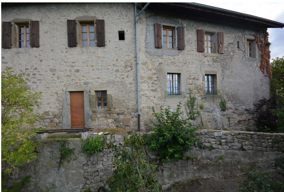
Fig. 25: Mur ouest de la tour maîtresse. Cliché : L. Benoit.
