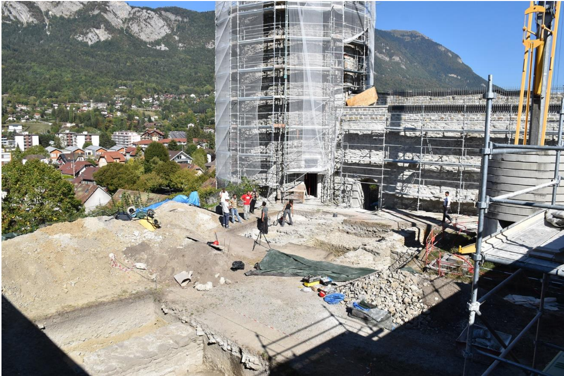
Fig. 6: Vue de la courtine orientale depuis l'intérieur du château. Cliché : L. Benoit.
