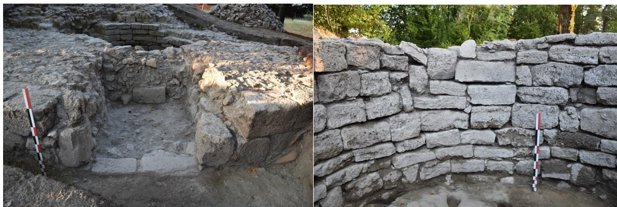
Fig. 8: Porte percée dans la tour (gauche) puis bouchée ultérieurement (droite). Cliché : L. Benoit.
