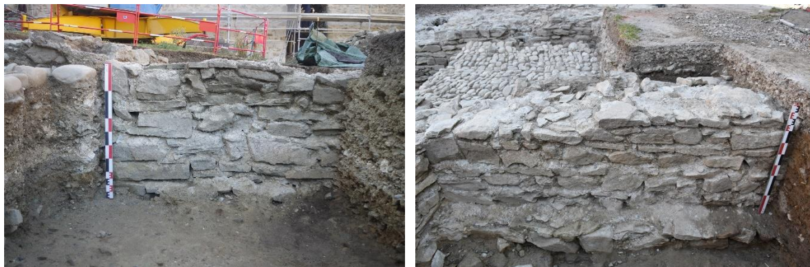
Fig. 22: Parement nord (gauche) et sud (droite) du mur d'axe est-ouest. Clichés : L. Benoit.
