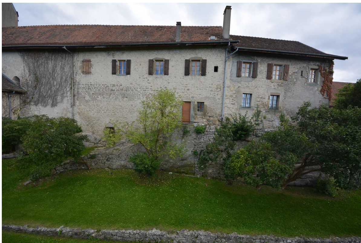
Fig. 22: Rampe d'accès à la cour haute. Cliché : L. Benoit.
