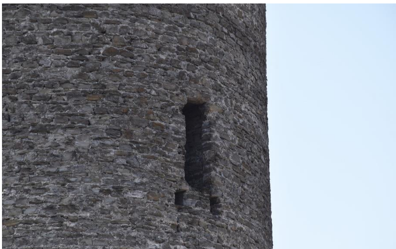
Fig. 14: Vestiges d'une ancienne latrine en encorbellement. Cliché : L. Benoit.
