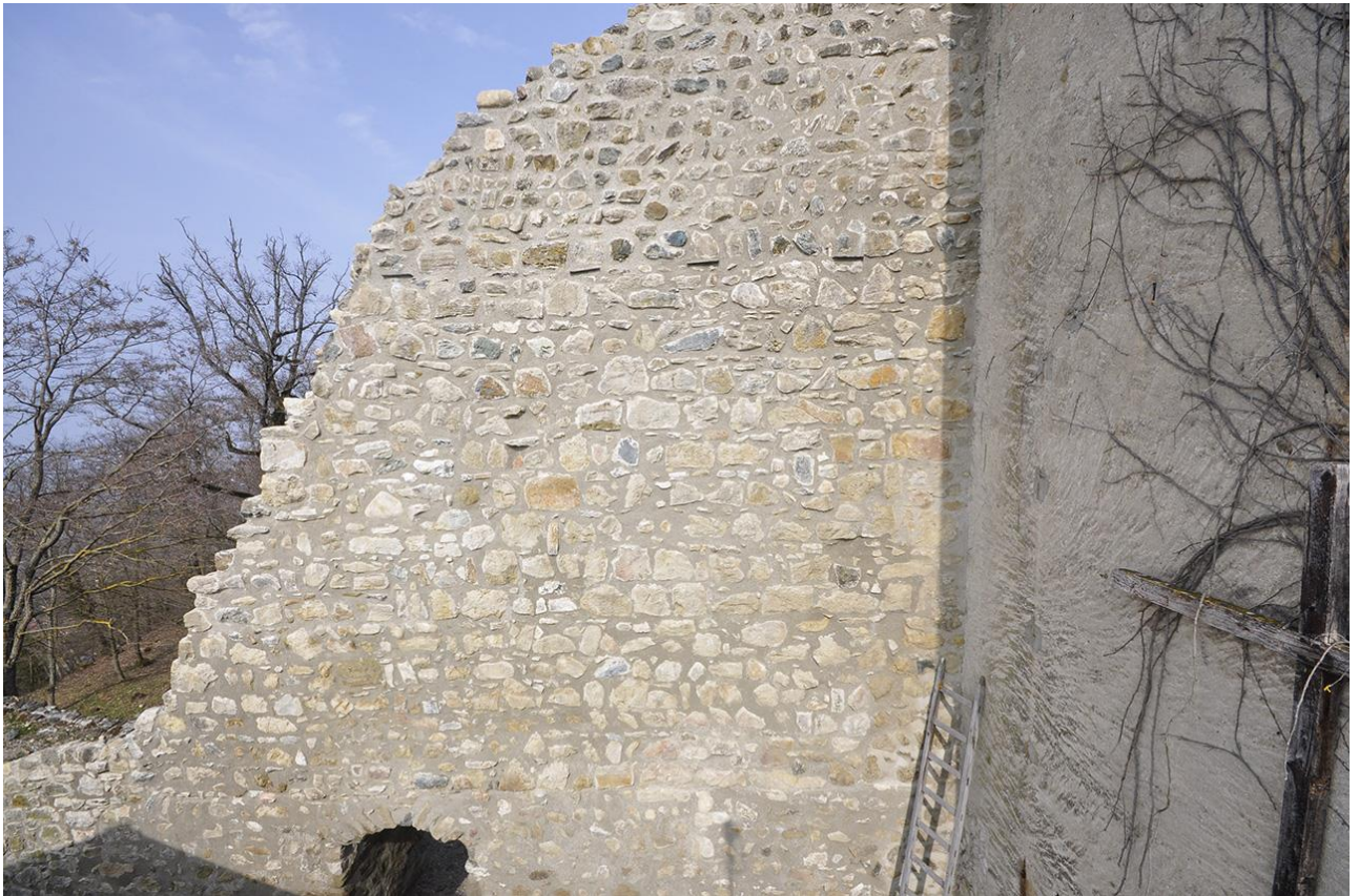
Fig. 16: Mur bouclier de Château-Neuf après restauration. Cliché : L. Benoit.
