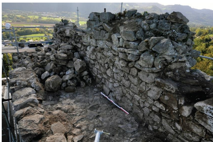
Fig. 32: Chemin de ronde présent au sommet du mur bouclier. Cliché : L. D'Agostino.
