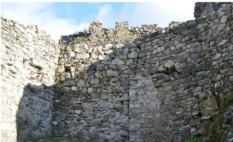
Fig. 4: Bouchage du portail de la barbacane ouest. Cliché : L. Benoit.
