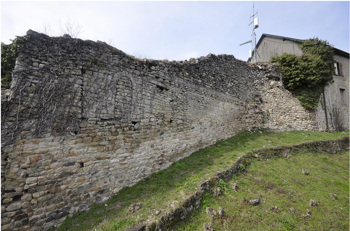
Fig. 13: Courtine orientale : fenêtres bouchées et fausse braie. Cliché : L. Benoit.
