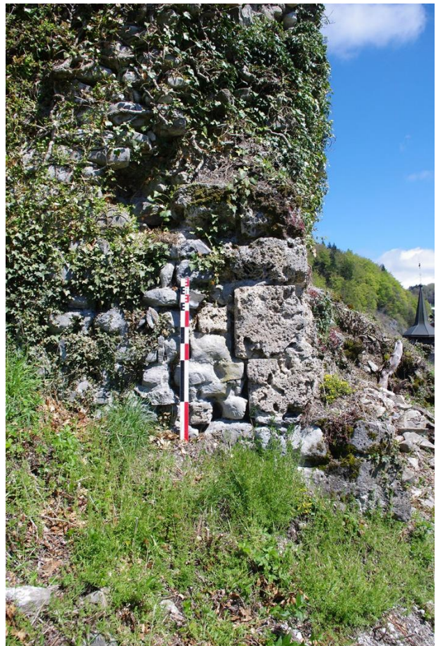
Fig. 6: Chaîne d'angle en tuf de la tour maîtresse. Cliché : L. Benoit.
