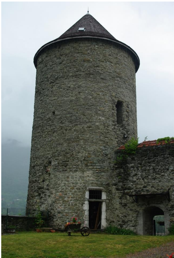
Fig. 10: Vue générale de la tour maîtresse avant restauration. Cliché : C. Guffond.
