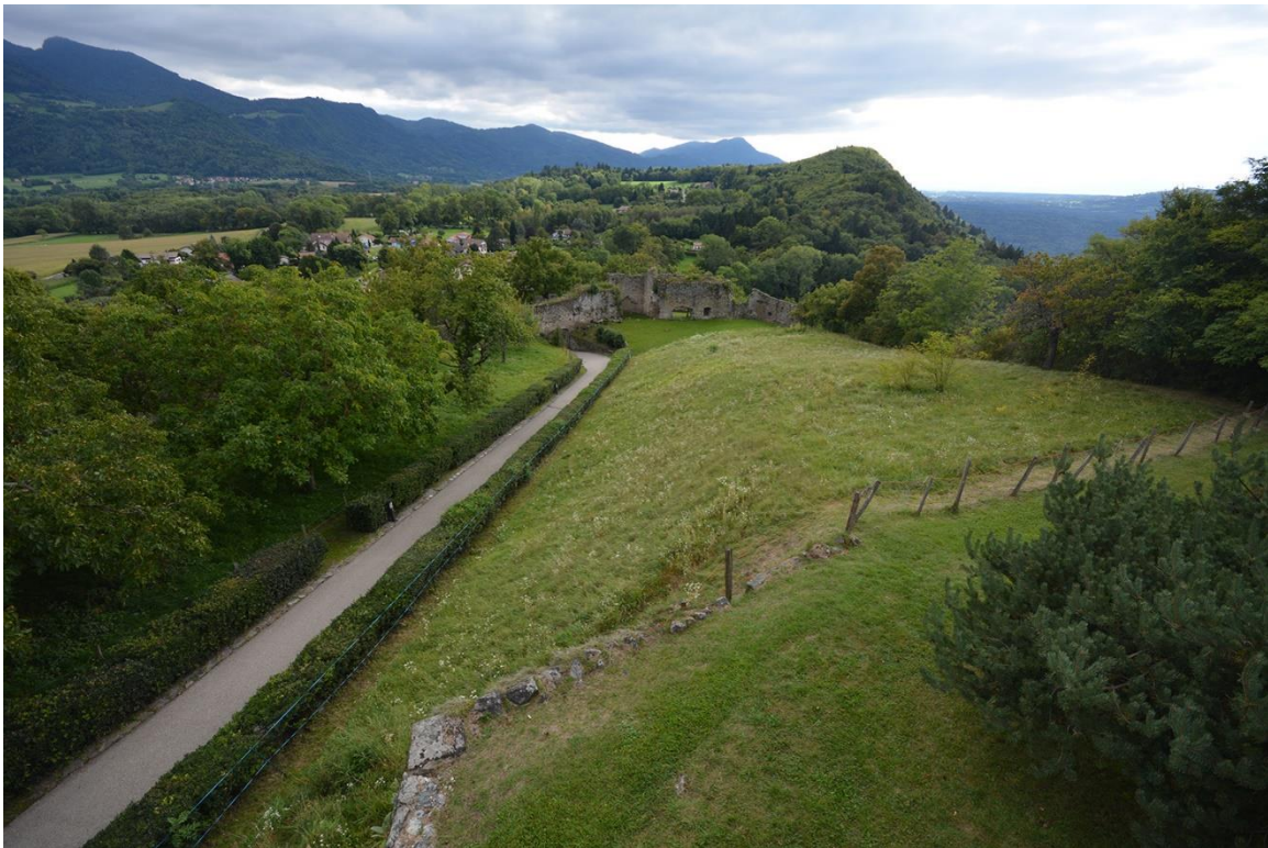
Fig. 46: Vue générale du bourg de Château-Neuf. Cliché : L. Benoit.
