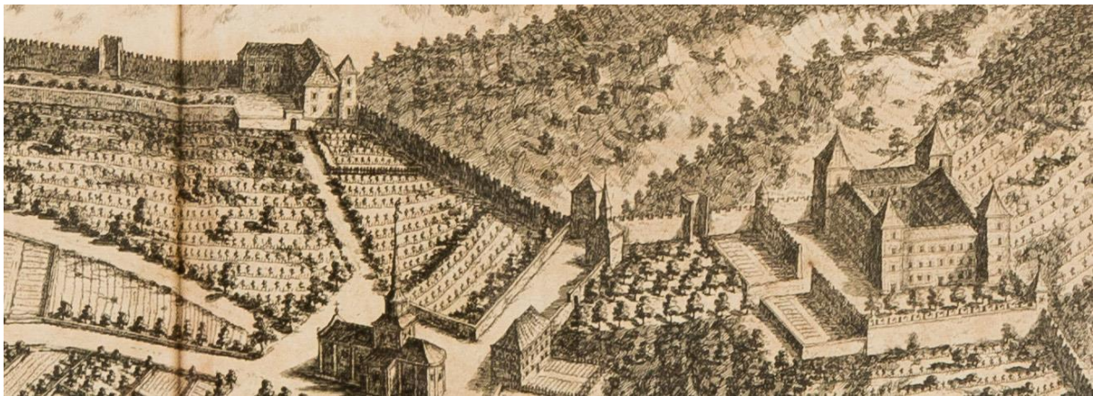
Fig. 30: Maisons fortes des Roches et de Pressy (à l'est du château) figurées sur le Theatrum Sabaudiae (XVII e siècle). Crédit : Dép74 - Bibliothèque du Grand Séminaire.
