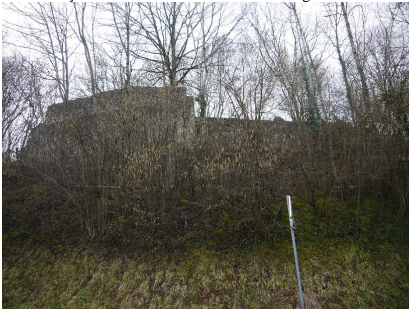
Fig. 4: Tronçon de courtine visible autour du site castral. Cliché : L. Benoit.
