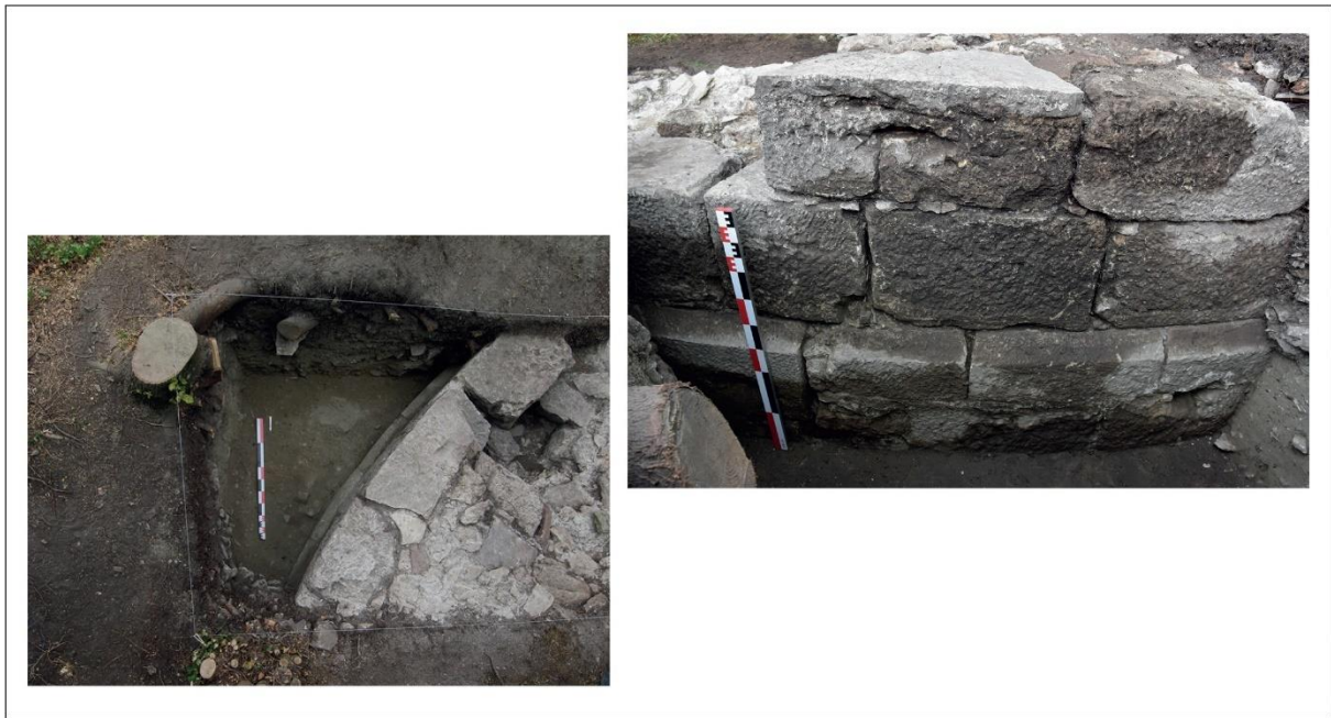
Fig. 29: Ressaut en partie basse de la tour maîtresse de Clermont. Cliché : L. Benoit.
