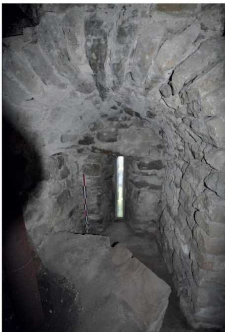
Archère à simple niche à Allinges-Neuf. Cliché: E. Chauvin-Desfleurs.
