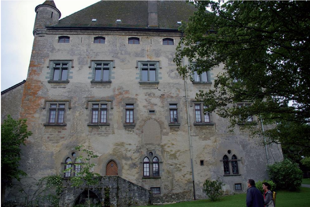
Fig. 27: Tour salle d'Ivoire vu depuis l'intérieur de la résidence privée. Cliché : C. Guffond.
