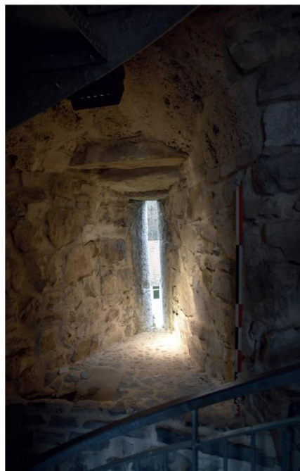
Archère à simple ébrasement à Faverges. Cliché: L. Benoit.
