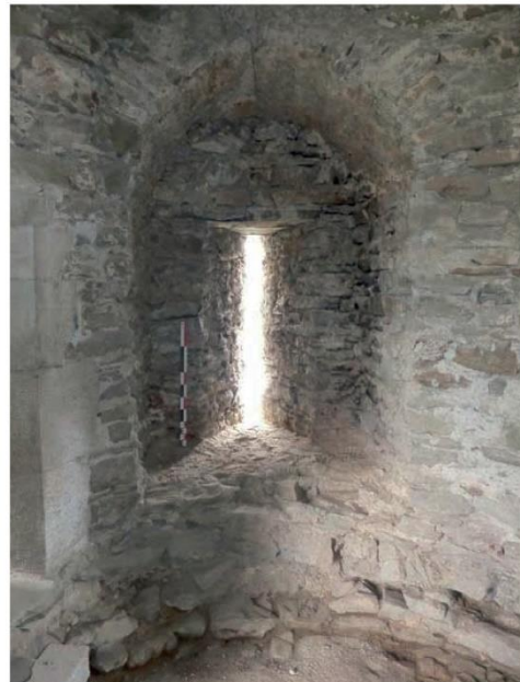
Archère à niche quadrangulaire à Bonneville. Cliché: S. Bocquet.
