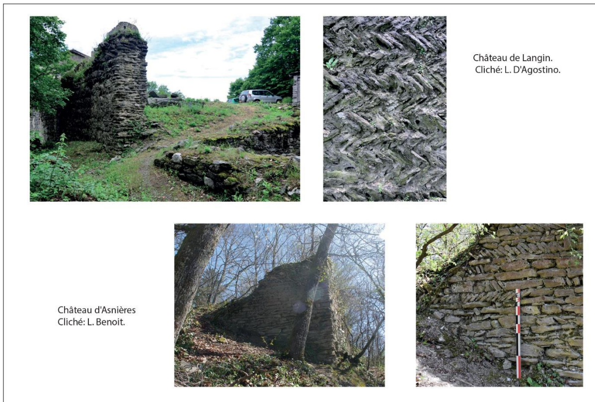
Fig. 58: Appareils en épis.
