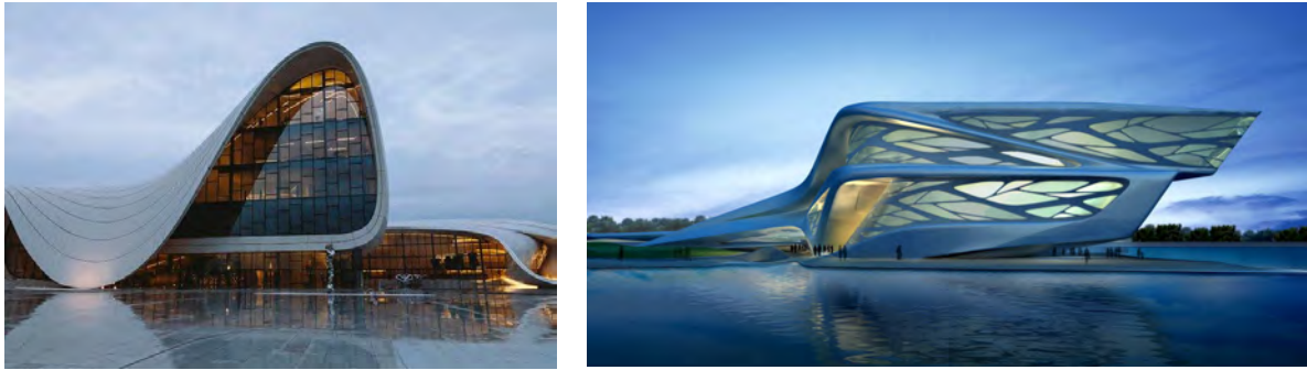
Figure 14. a. Tremplin de Bergisel ; b. Musée d'Ordrupgaard ; c. Centre Heydar Aliev ; d. Abu Dhabi Performing Art Center, , Zaha Hadid Architects
