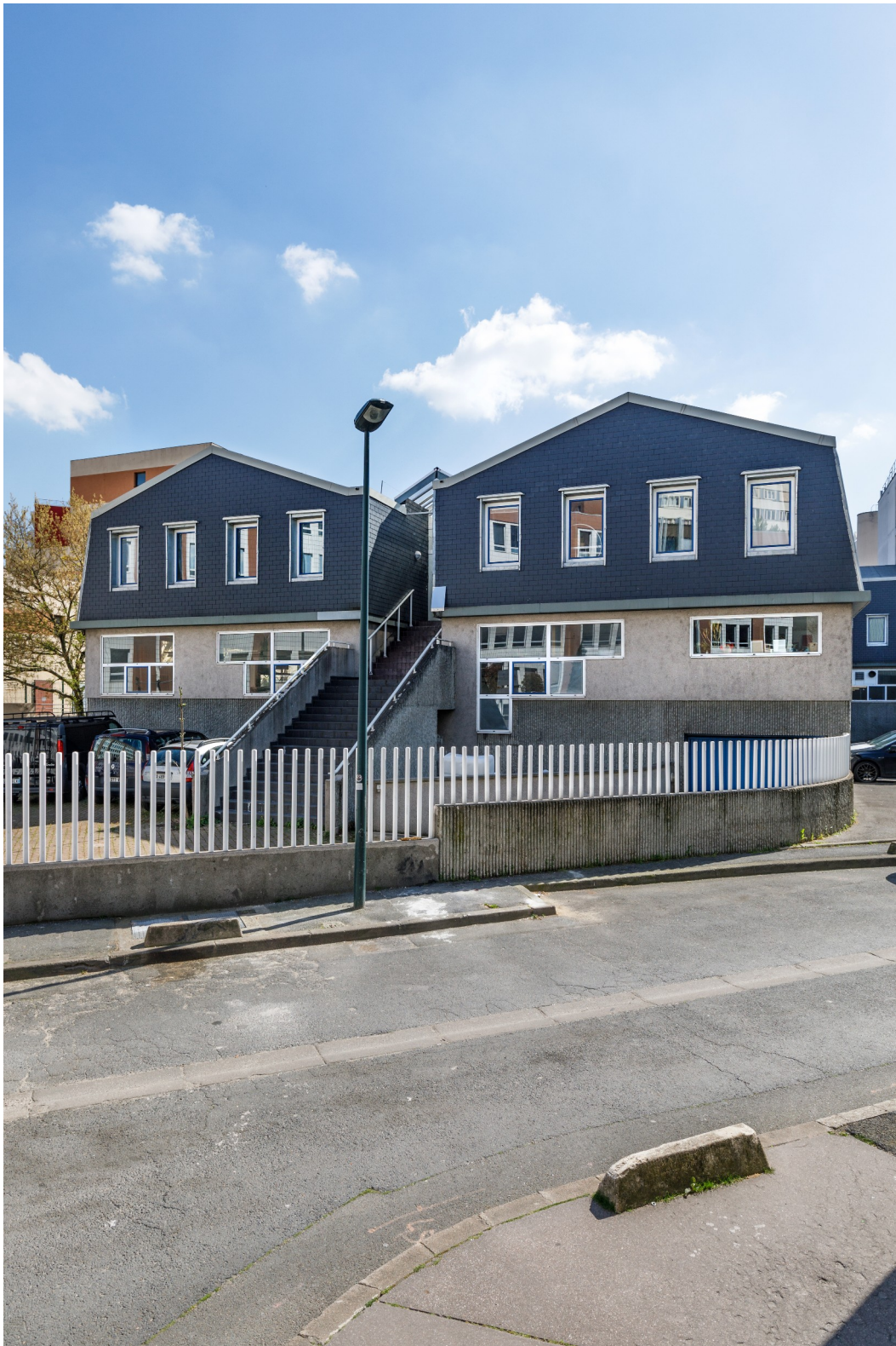
Archive photographique de Salim Santa Lucia. Façade du Wonder/Fortin.
