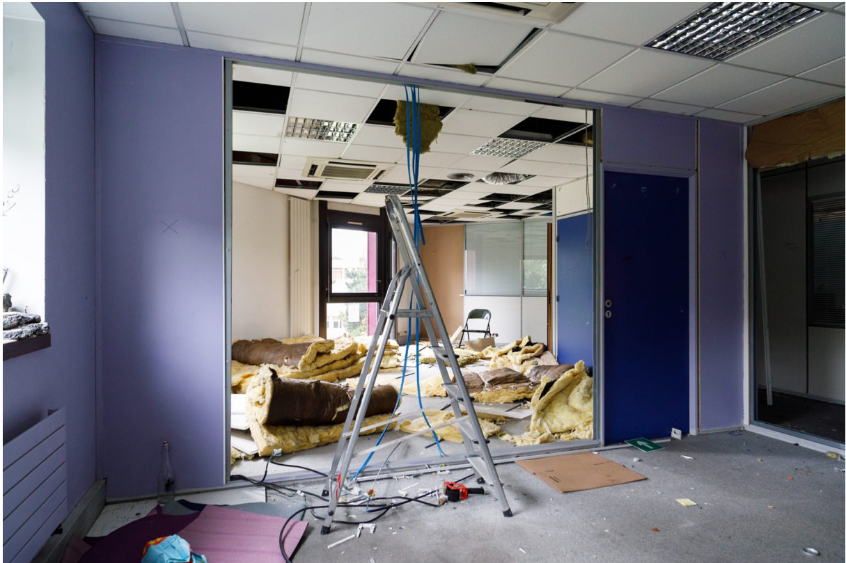
Archive photographique de Salim Santa Lucia. Les isolants sont démontés et emportés.
