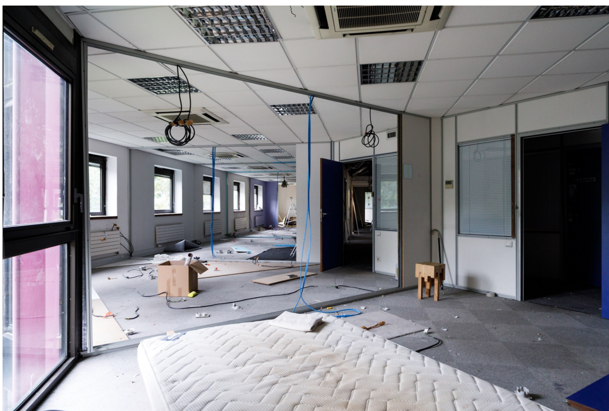
Archive photographique de Salim Santa Lucia. Les portes et cloisons sont démontées et emportées.
