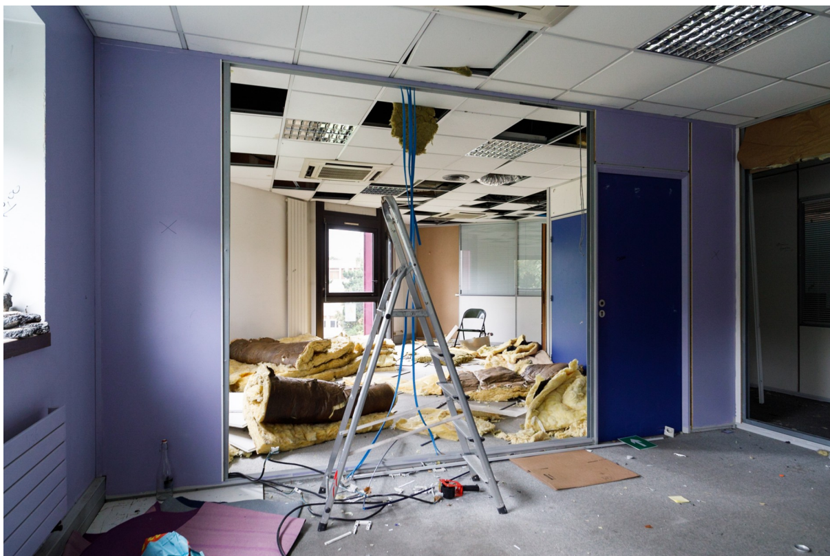
Archive photographique de Salim Santa Lucia. Les isolants sont démontés et emportés.
