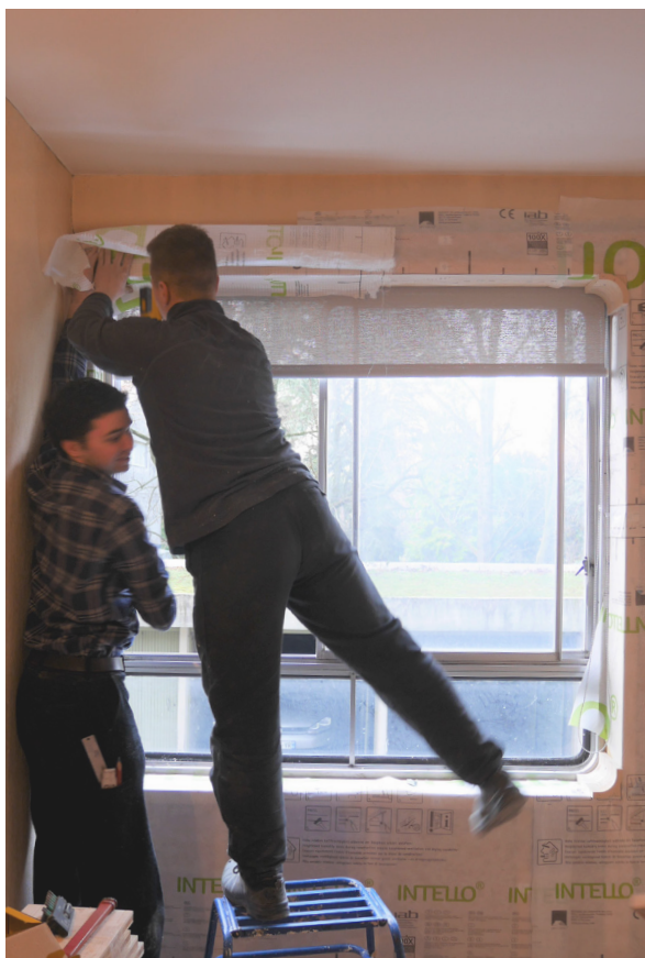
Pose de l'isolant thermique fibre de bois et du frein vapeur © Mathilde Padilla, 25 janvier 2020
