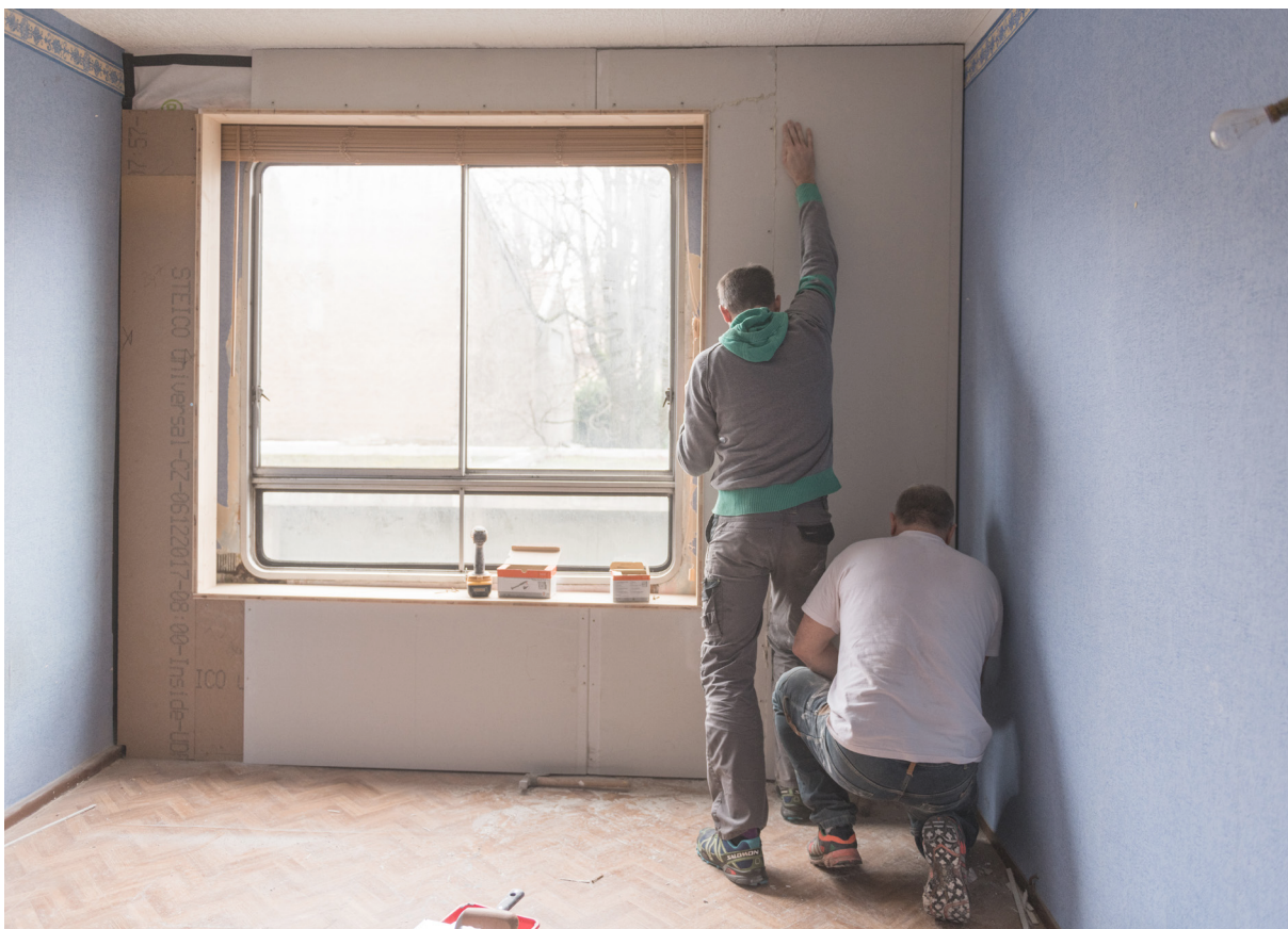
Pose de l'isolant phonique Fermacell © Sabine Serrad, 28 janvier 2020
