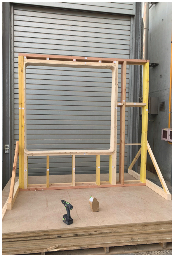
Ossature du prototype © Eddy Giroux, Compagnons du Devoir, novembre 2019
