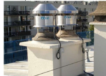
Mise en place de ventilation naturelle assistée en toiture : hybride
