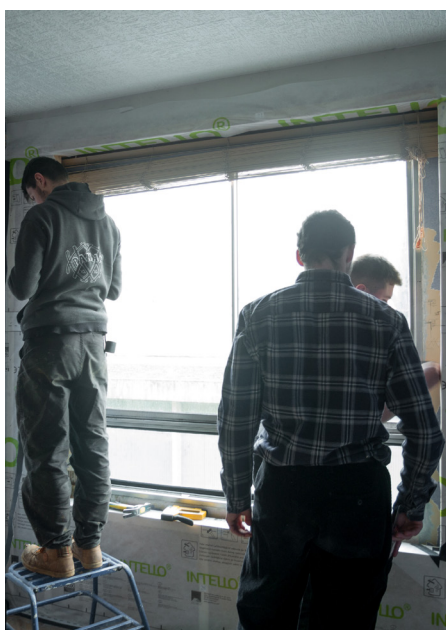
Pose de la première couche de fibre de bois 10 cm + frein vapeur © Mathilde Padilla, 25 janvier 2020
