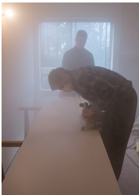
Pose des panneaux Knauf contrapanel © Mathilde Padilla, 25 janvier 2020
