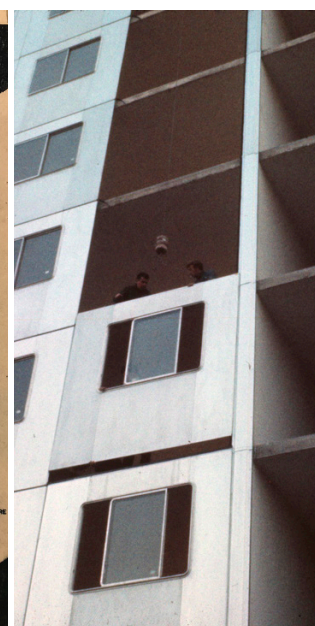
Pose d'un panneau lors du chantier (façade nord) © Centre Pompidou/MNAM-CCI/Bibliothèque Kandinsky/ archives numérisées/230150110_058_002_P
