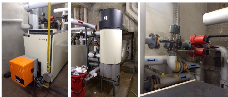
Gaines techniques : réseaux d'eau chaude pour le chauffage
