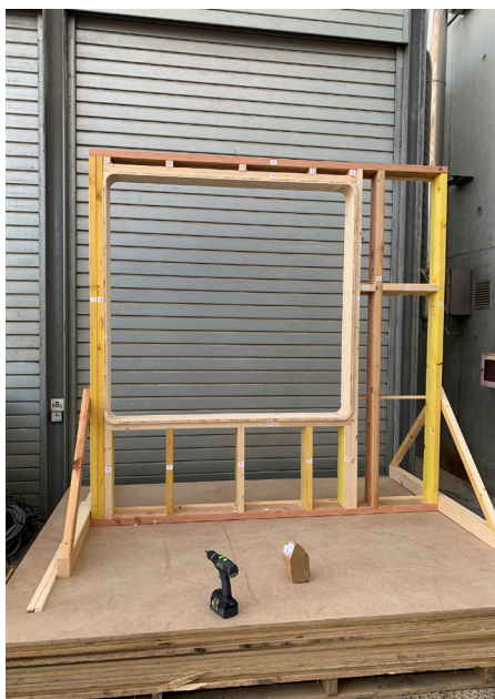
Ossature du prototype 1 © Eddy Giroux, Compagnons du Devoir, novembre 2019
