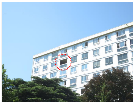
Photographies du point de mesures PF3
