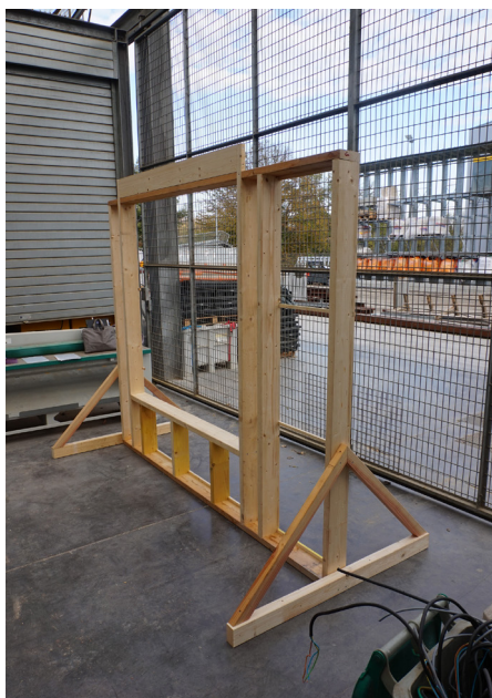
Ossature du prototype 2 © Eddy Giroux, Compagnons du Devoir, novembre 2019
