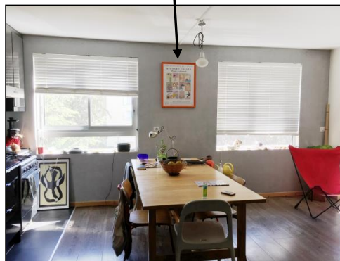
Doublage intérieur en plaques de plâtre
