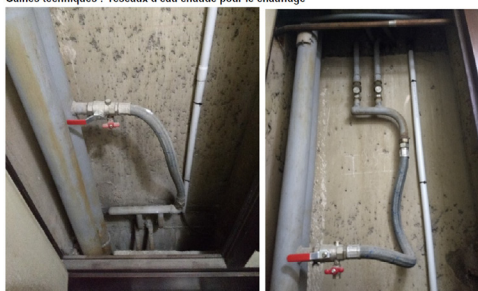
Gaines techniques : réseaux d'eau chaude pour le chauffage
