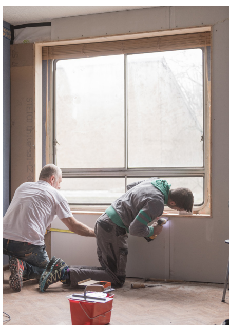
Pose du Fermacell © Sabine Serrad, 28 janvier 2020
