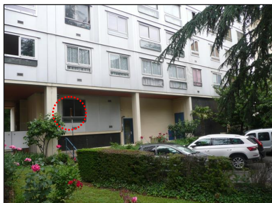
Photographies du point de mesures PF1
