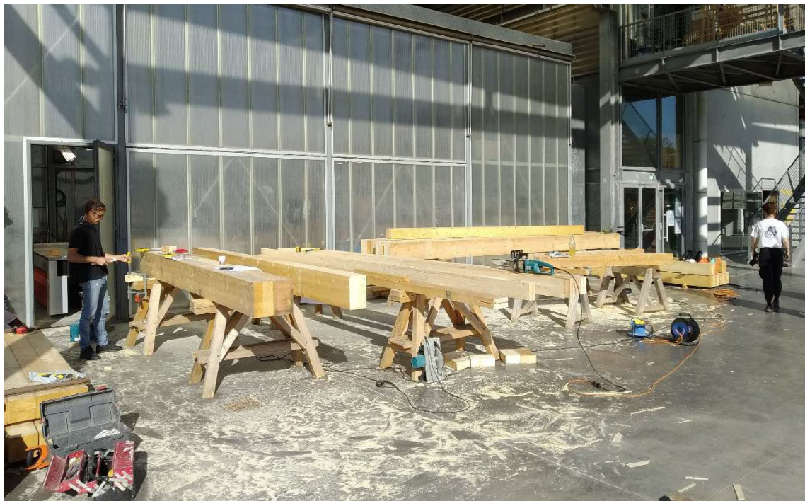
Figure 100 : découpe et perçage des sections en bois, octobre 2021, © Rémi Junquera
