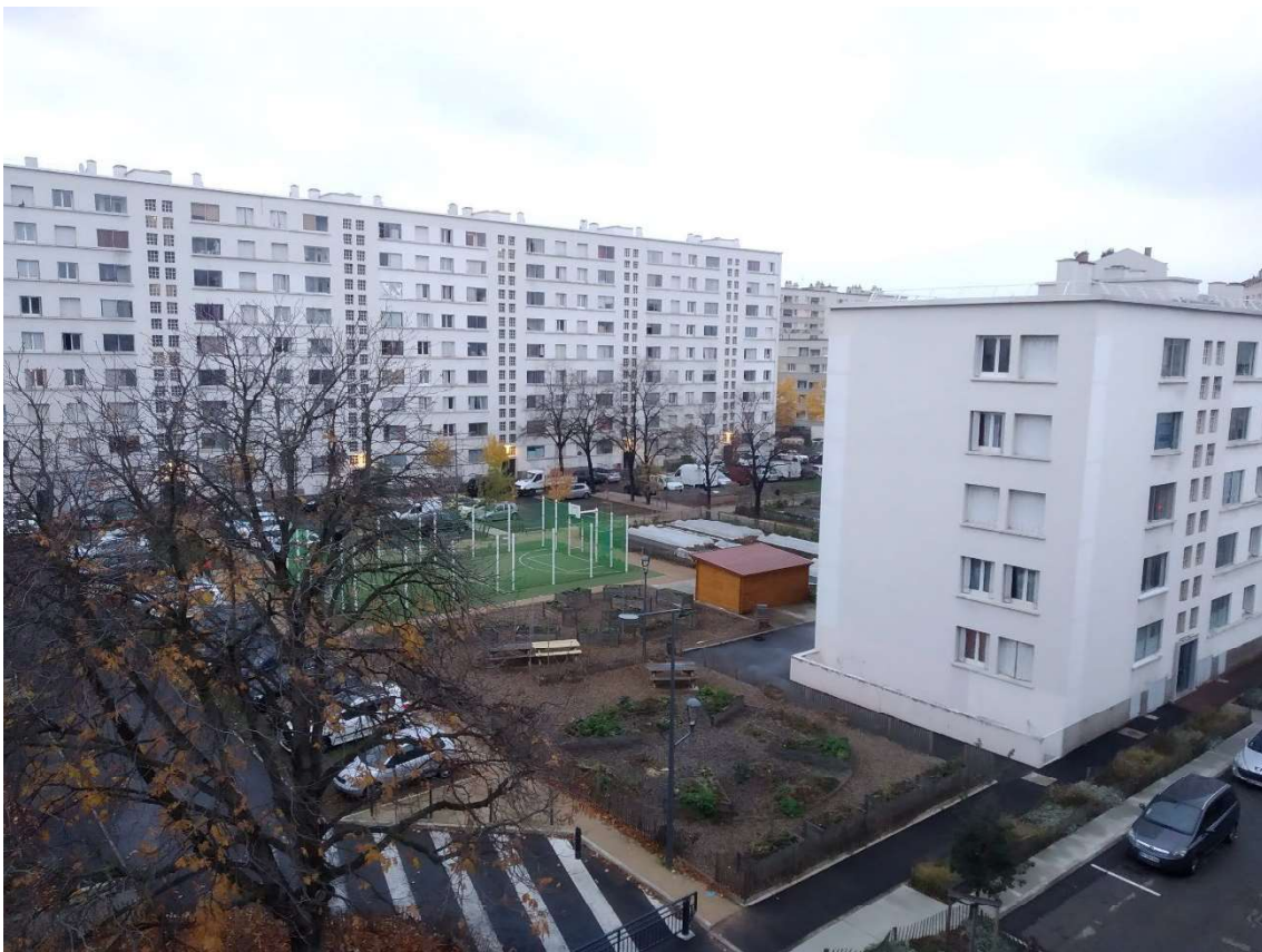
Figure 56 : vue depuis le balcon d'une habitante du bâtiment A4, novembre 2021, © Rémi Junquera
