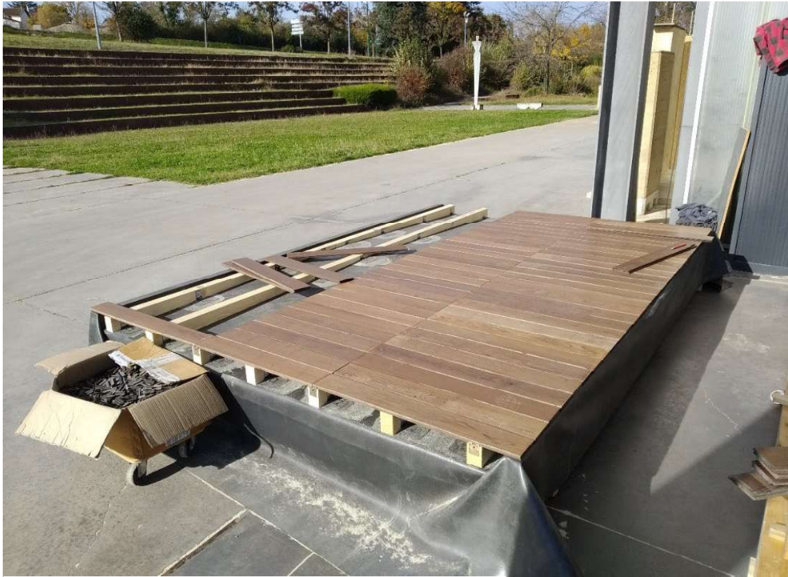
Figure 104 : module de plancher, octobre 2021, © Rémi Junquera
