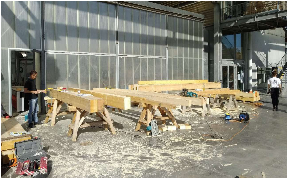
Figure 100 : découpe et perçage des sections en bois, octobre 2021, © Rémi Junquera
