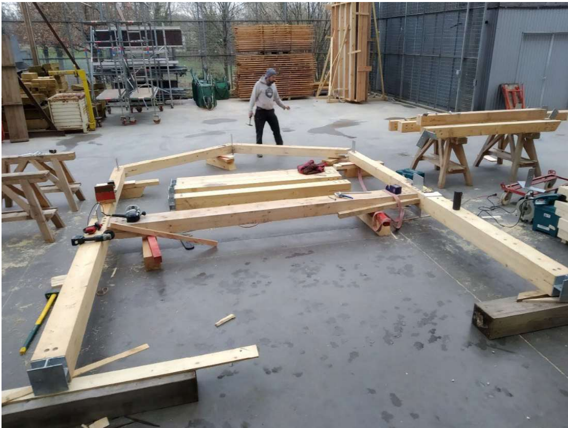
Figure 101 : assemblage du portique central, © Rémi Junquera
