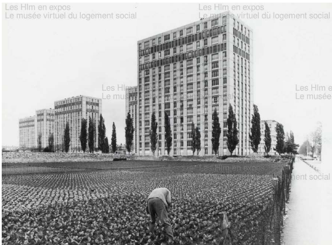
Figure 35 : Stains, le Clos Saint Lazare, 1970, Photo Ministère du Logement, Direction Régionale de l'Equipement N°32562, 24x18cm
