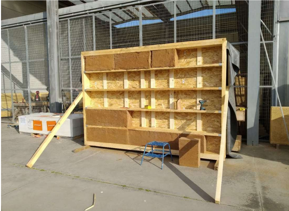
Figure 103 : mise en place des blocs d'isolant, novembre 2021, © Rémi Junquera
