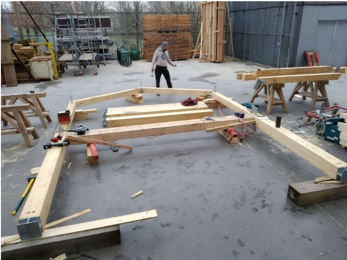
Figure 101 : assemblage du portique central, © Rémi Junquera
