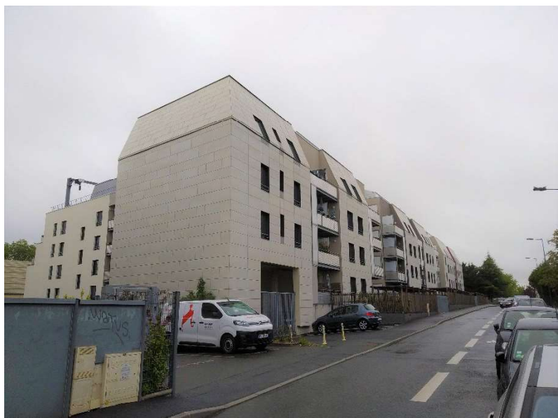
B : vue depuis le nord de la rue Milletière, © Rémi Junquera
