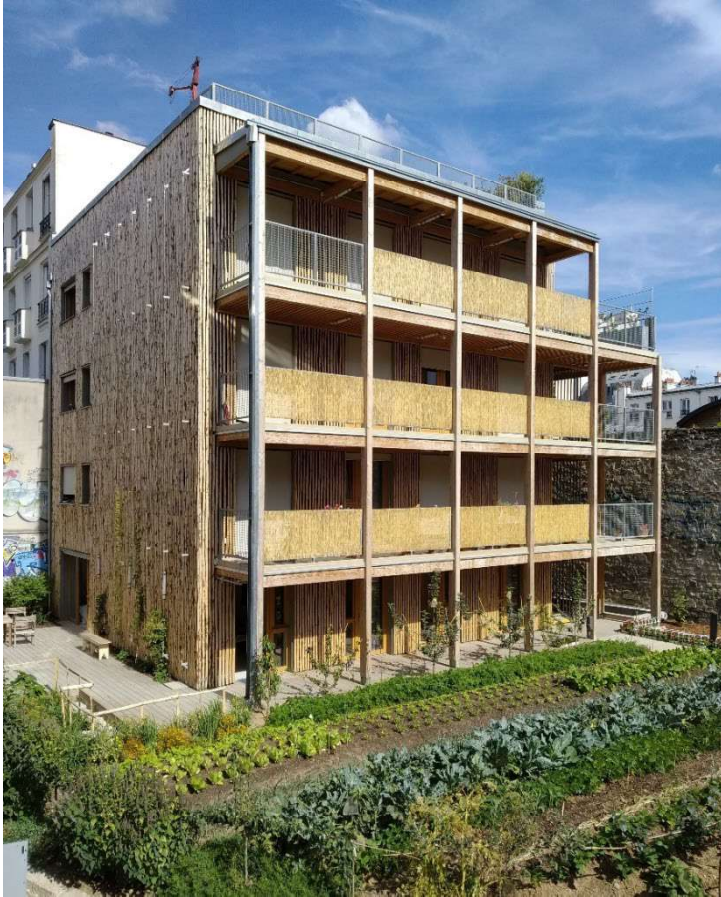
Figure 61 : le bâtiment de logement vu depuis la terrasse du restaurant, août 2020, © Rémi Junquera.
