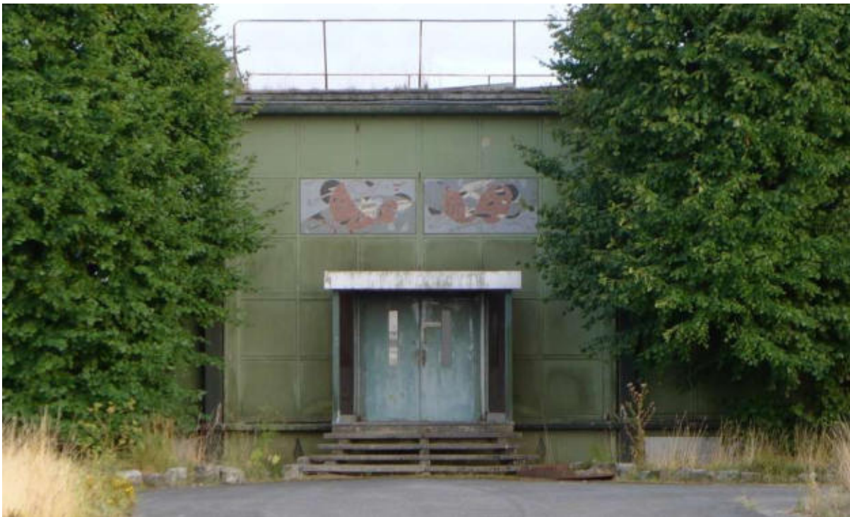
III. 225 « Centre d'émission d'Étampes ». Entrée du bâtiment principal, état en 2013. Cliché de l'auteur.
