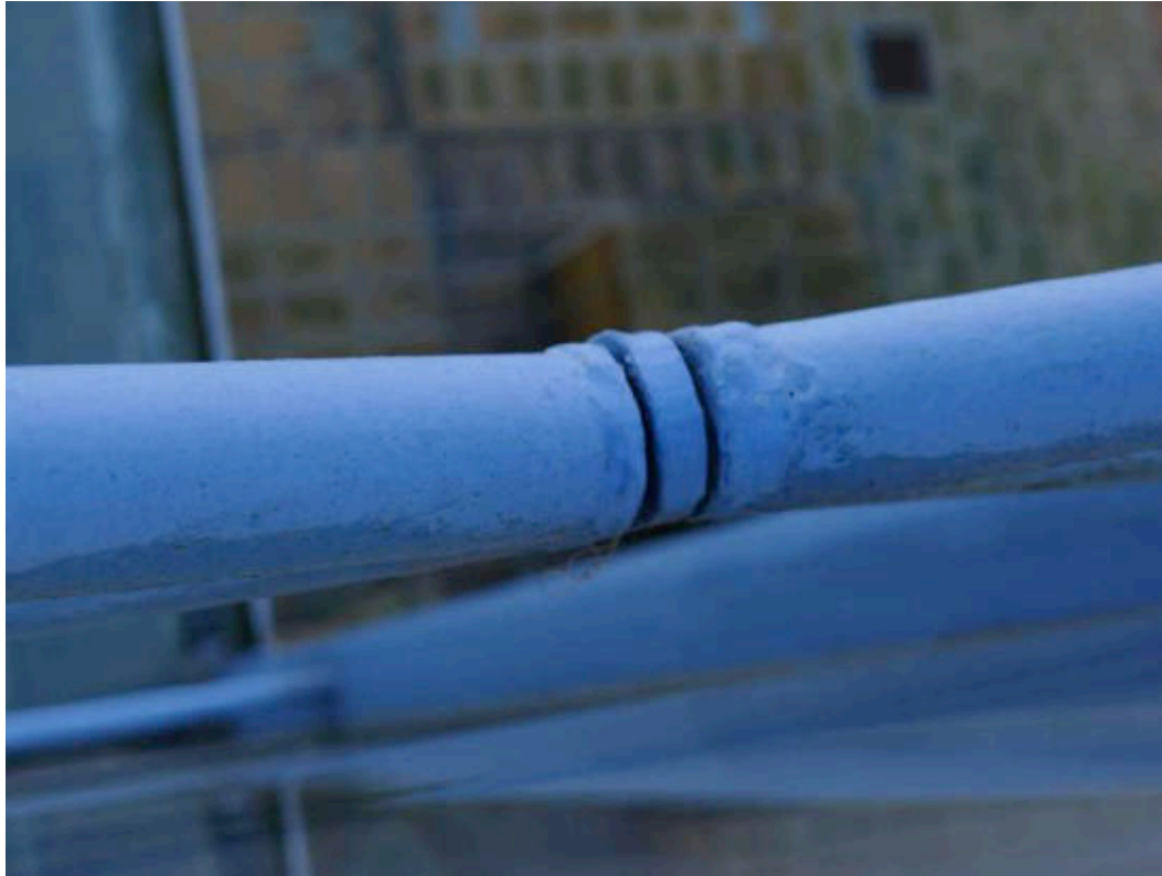
III. 619 Détail sur une croix de Saint-André placée au niveau d'un joint de dilatation. Orly, cliché de l'auteur, septembre 2013.
