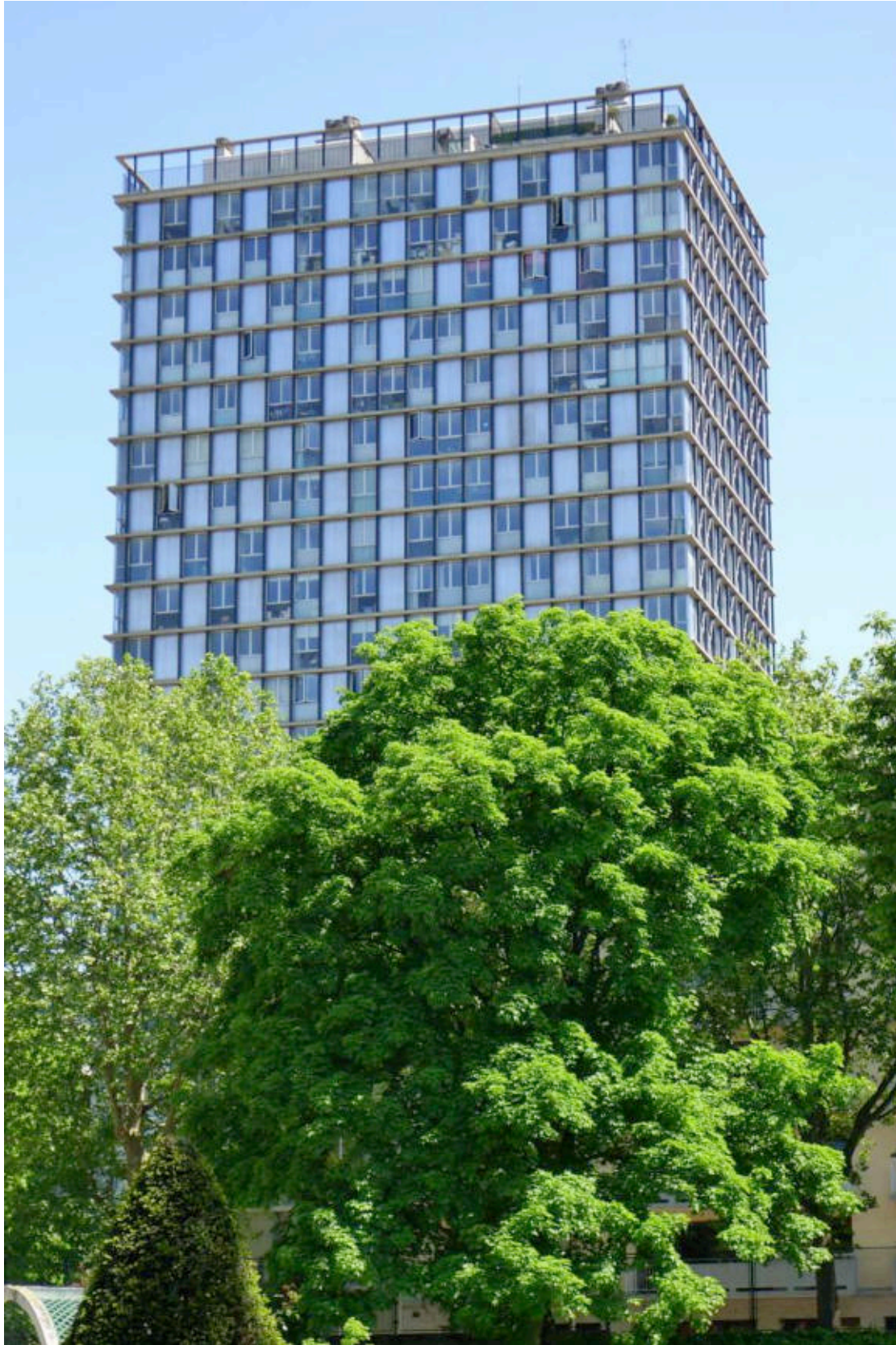
III. 550 Denier niveau de la tour avec prolongement de la structure, permettant d'absorber visuellement le niveau correspondant à la machinerie des ascenseurs. Cliché de l'auteur, mai 2012.
