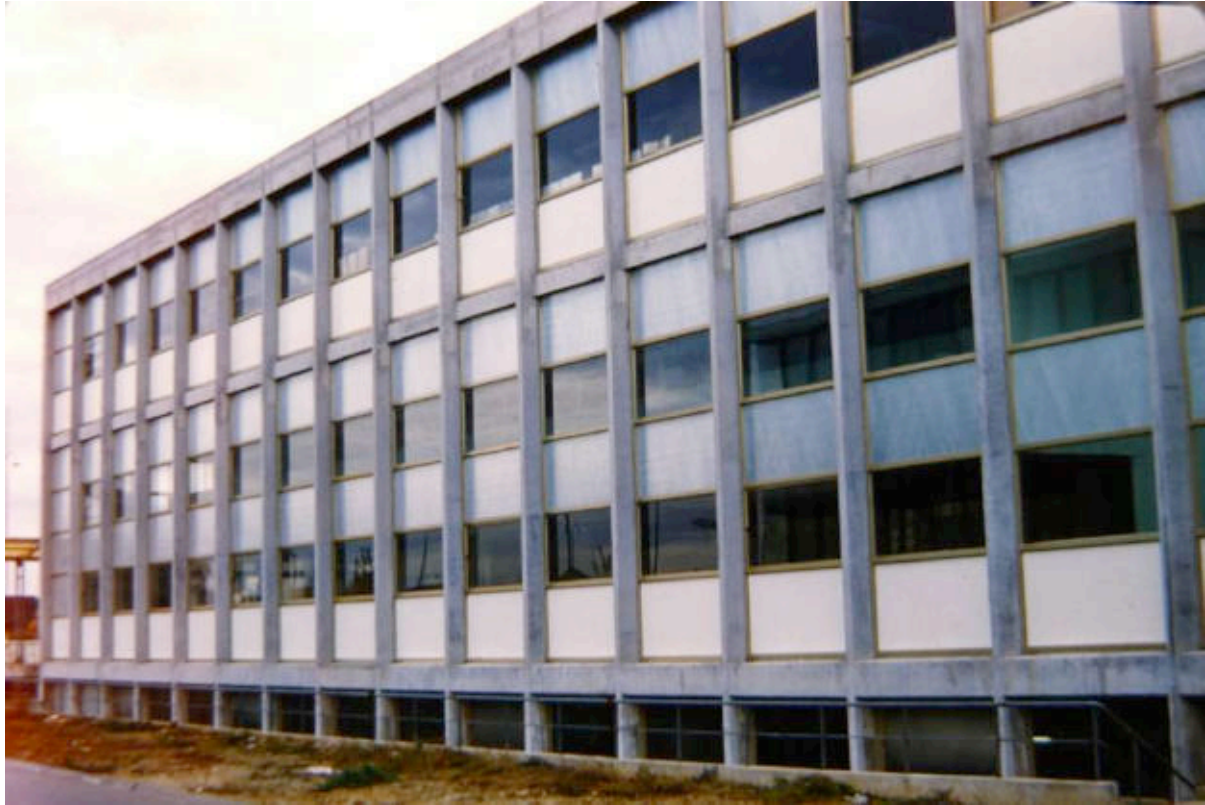
III. 413 Façade en béton armé du CRAC. Sans date [1960]. ALB_77 [Diapositives, iconographie de conférences].
