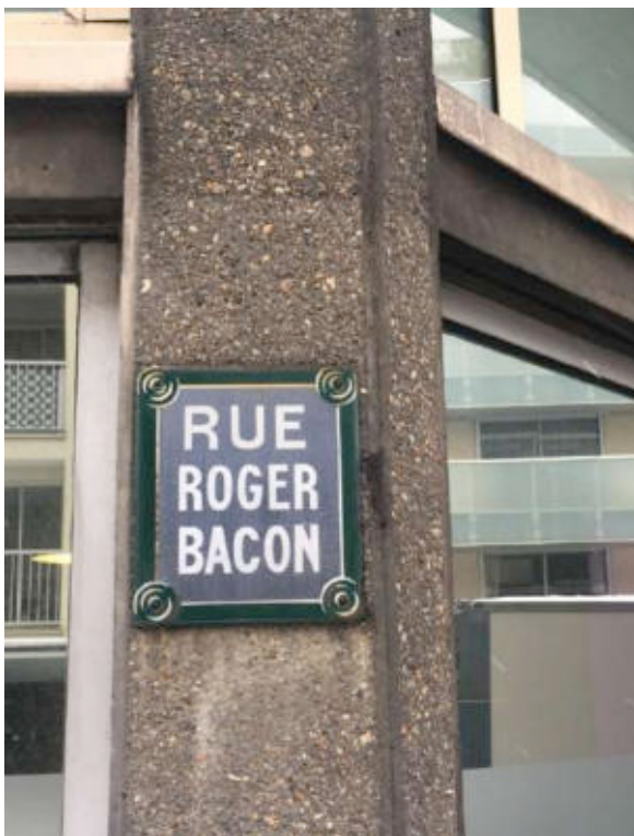
Ill. 528 Immeuble d'habitation 9-11, rue Roger Bacon, Édouard Albert architecte. Détail de traitement du béton bouchardé du soubassement. État en février 2018, cliché de l'auteur.
