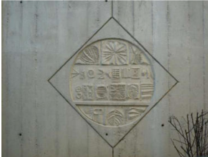
III. 795 Relief réalisé lors du coffrage des murs de béton armé, tour Nouveau Monde, cliché de l'auteur octobre 2012.
