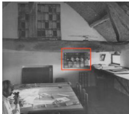
Ill. 997 Édouard Albert dans son atelier de recherche à Pecqueuse (), [1966]. Cliché publié in RAGON Michel, « Où vivent les architectes modernes ? », Jardin des arts , n° 144, novembre 1966, p. 15. On aperçoit une maquette d'étude du plafond décoré par Léon Gischia.
