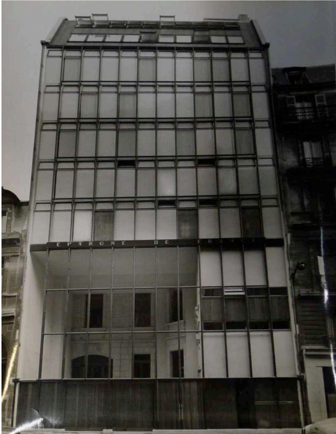
III. 240 Bureaux de l'Épargne de France 85, rue Jouffroy dans le XVII e arrondissement de Paris. Façade en pierre de l'hôtel de Gustave Eiffel au RDC et R+1. [1958]. ALB_30.1.
