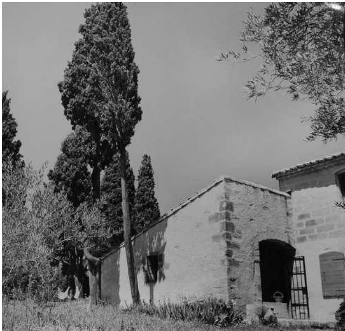
III. 722 Photographie présentant un détail du Mas. Appareillage de pierre, arc surbaissé, chaînage d'angle, grille en fer forgé, tuiles de la couvertures et volets en bois, autant d'éléments qu'Albert paraît aussi affectionner. ALB_11.
