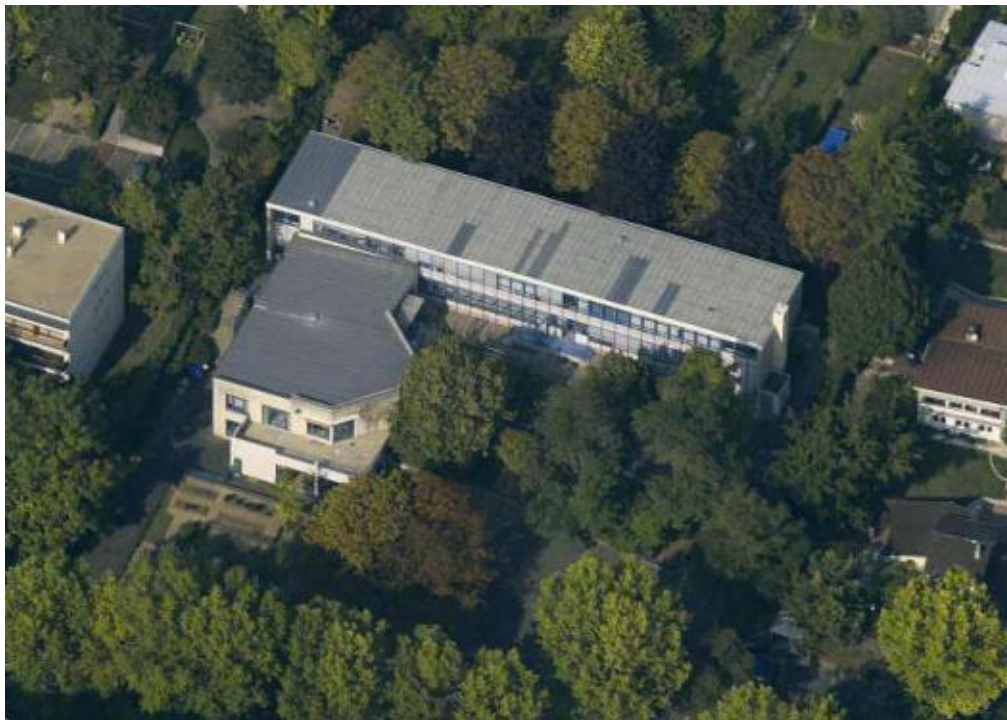
III. 500 École Jean de la Fontaine 141, rue Nicolas Filliette à Rueil-Malmaison (Hauts-de-Seine). Les salles de classe sont orientées au sud. Vue Google, site consulté le 10 mai 2012.
