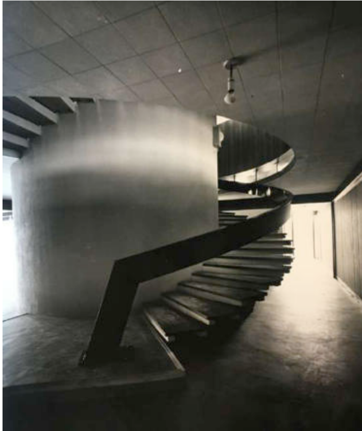
Ill. 545 Photographie du noyau central abritant les sanitaires et servant de support aux marches préfabriquées de l'escalier. Sans date [vers 1961]. ALB_48.2.
