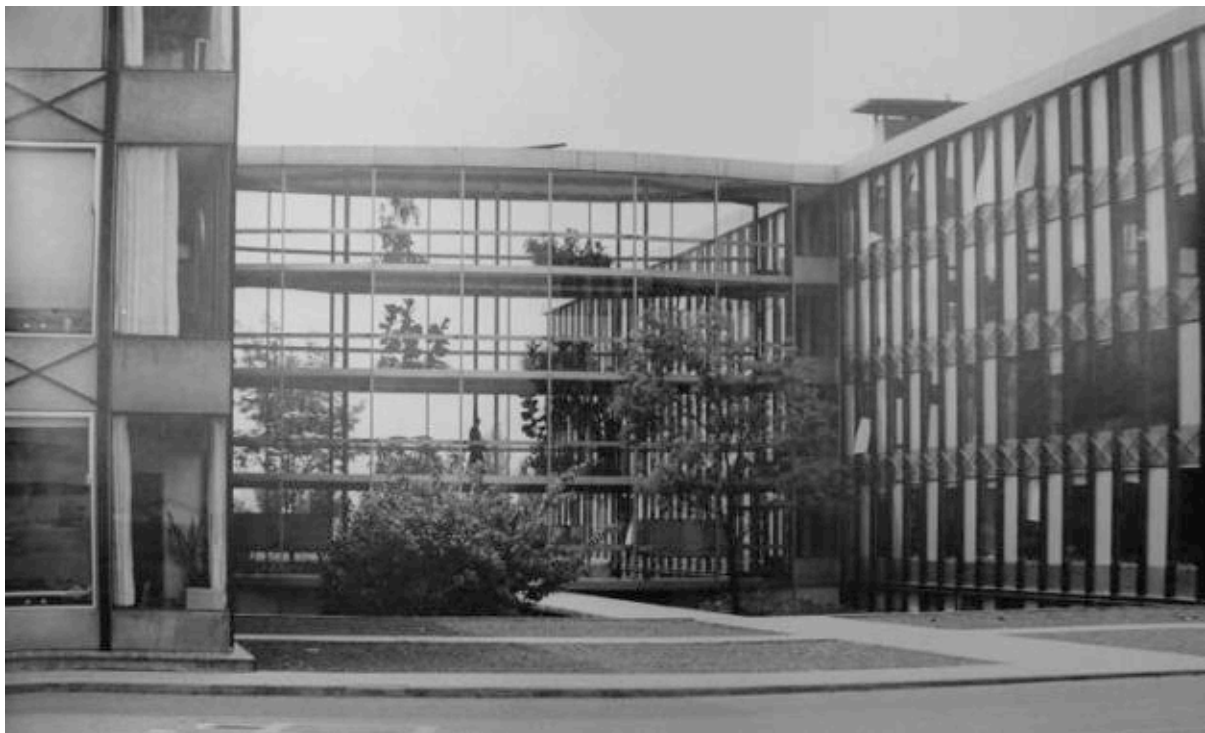
III. 459 « AFBA3 ». Vue de la passerelle et du jardin. Tirage grand format. ALB_40.2.
