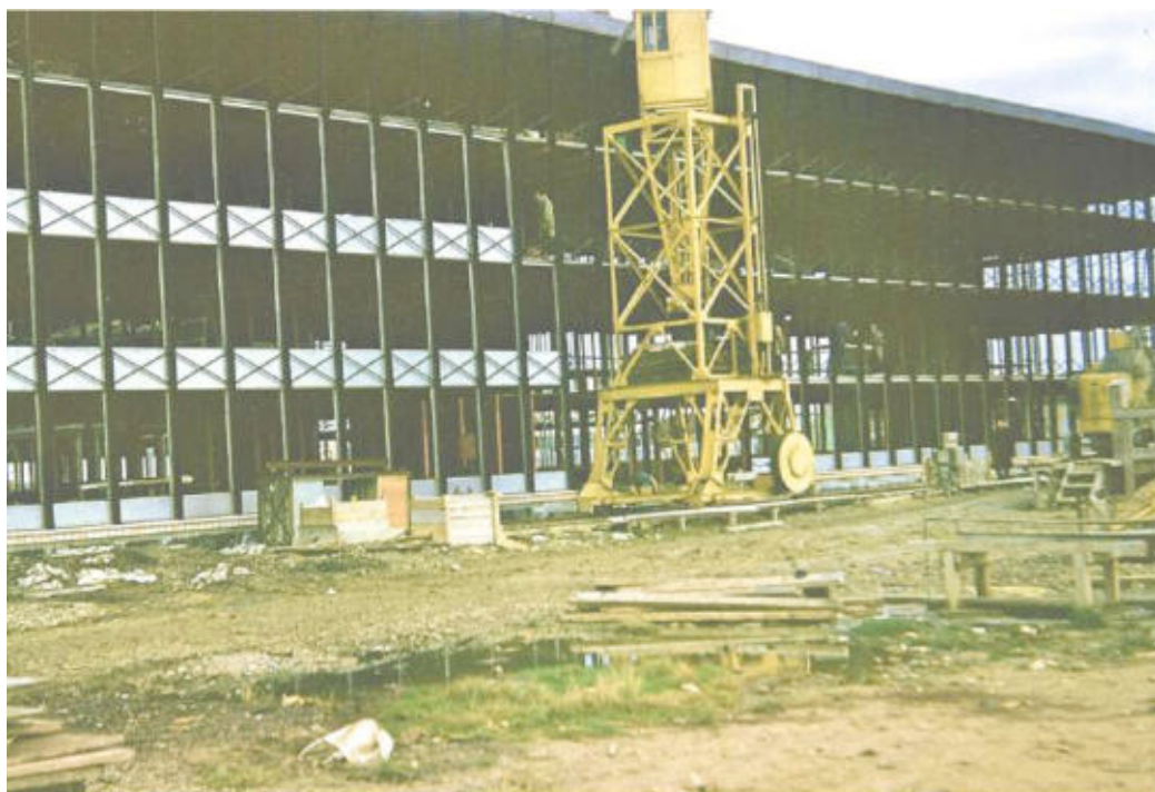
III. 434 Chemin de grue sur le chantier des bureaux d'Air France à Orly, 1959. Photographies E. Guhl.
