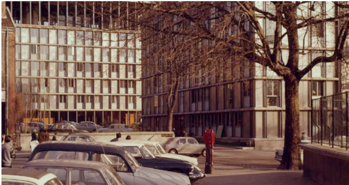
III. 581 Vue de l'entrée du jardin-parking avec entrée jouxtant le bâtiment sur rue. Sans date [vers 1962]. Archives Arnaldo Coutine.
