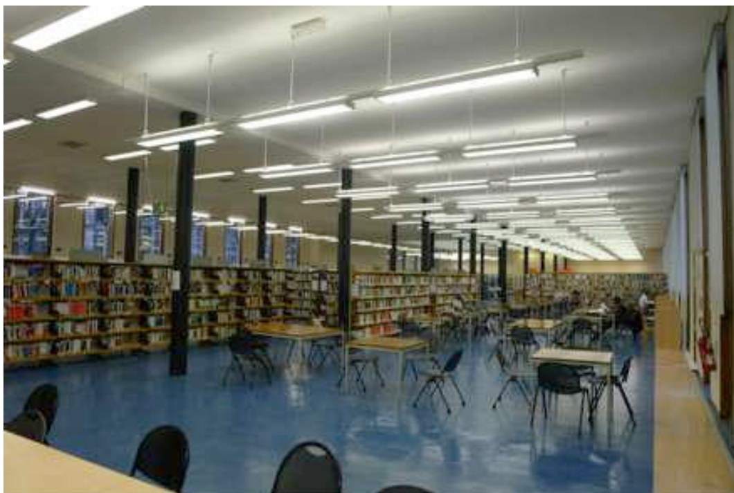
III. 786 « Bibliothèque universitaire de Nanterre », premier niveau d'une salle de lecture avec poteaux tubulaires supportant le plancher du second niveau. Les chaises d'Arne Jacobsen ont été remplacées. Cliché de l'auteur, mars 2012.
