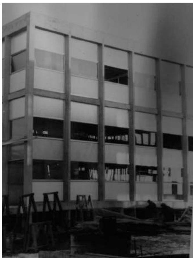
III. 412 Centre de Réapprovisionnement et d'Armement Commercial « CRAC » à Orly. Légendé au verso « CRAC Air France, mars 1960 ». On distingue dans le reflet des vitres les bureaux d'Air France aux façades métalliques. ALB_33.
