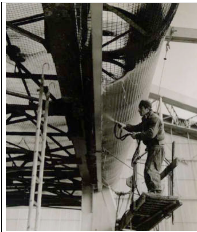
Ill. 645 « Toiture du Pavillon de la Ville de Paris – Bruxelles – Expo 1958 » légende au verso d'un cliché conservé avec les tirages de la « Chapelle de Montconseil ». Projection de « Cocoon » pour l'étanchéité. ALB_41.1.
