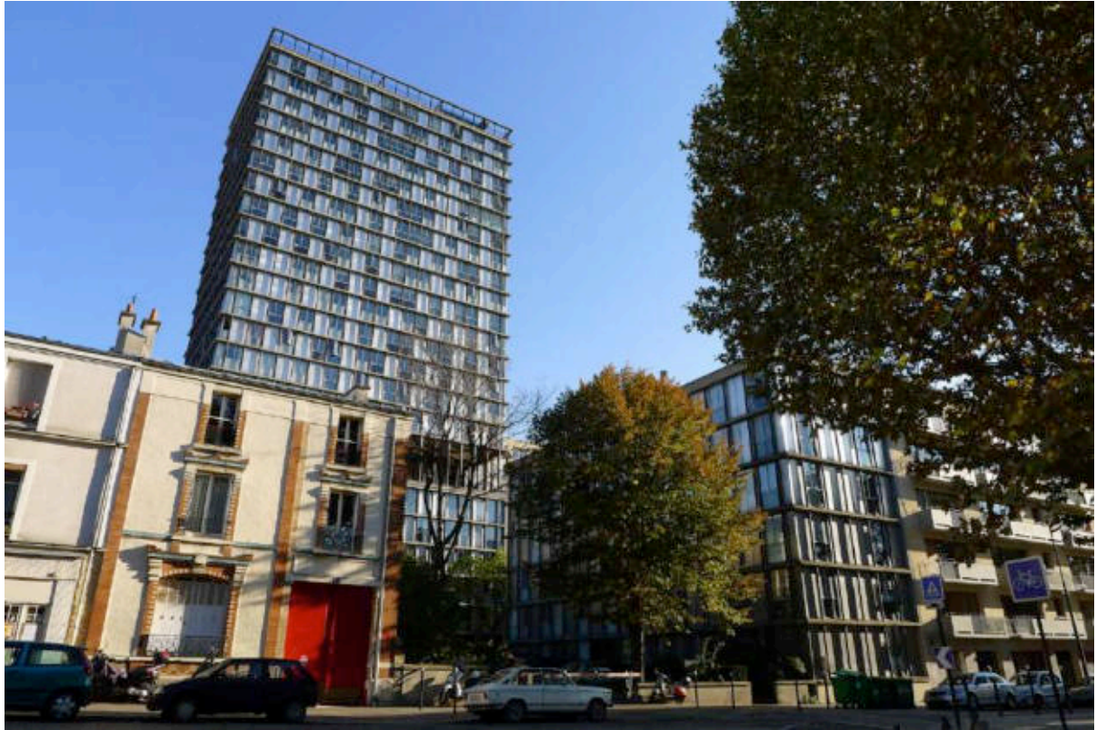
III. 335 Rupture d'alignement au niveau du numéro 33 de la rue Croulebarbe. Cliché de l'auteur, octobre 2011.
