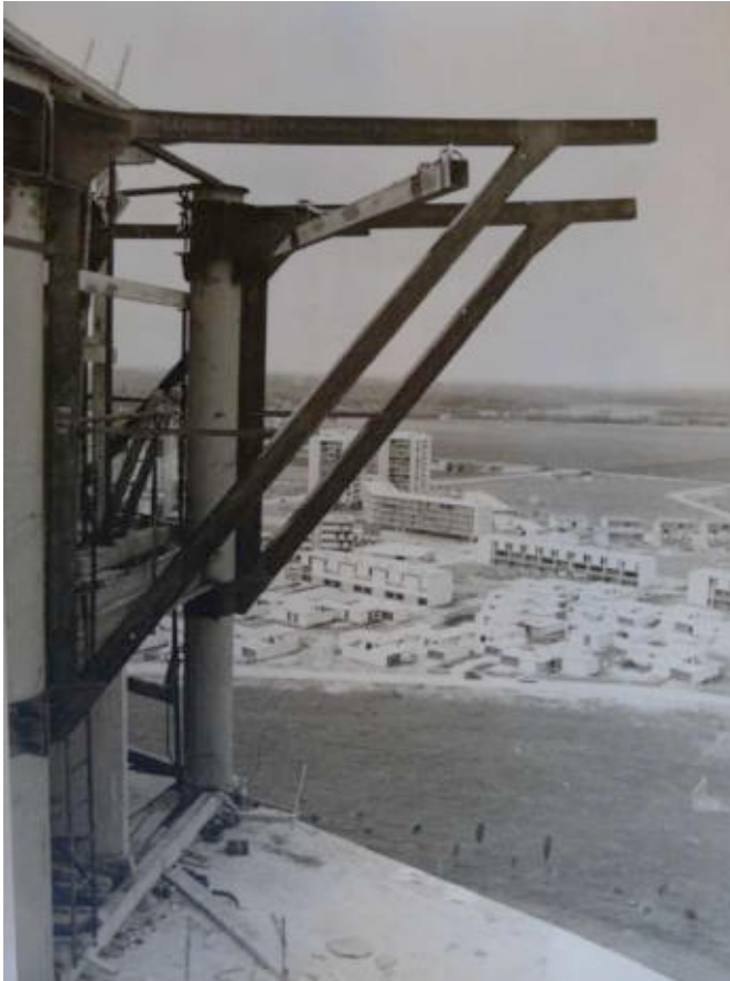
III. 907 « Coffrage de la chaufferie, mai 1967 ». ALB_50.2.
