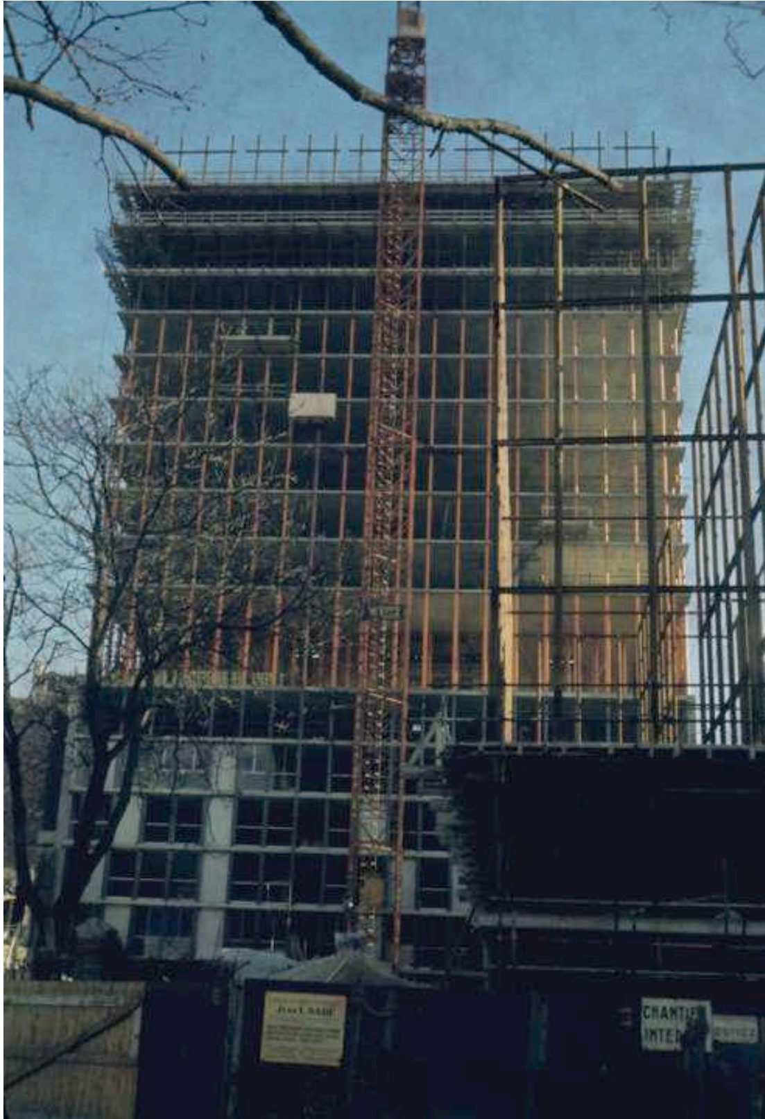
III. 293 Construction des derniers niveaux du gratte-ciel. Une grue permet de hisser les échelles préfabriquées au sommet du chantier. Au premier plan on distingue la mince ossature métallique du bâtiment sur rue, dont les dalles des planchers ne sont pas encore coulées. Photographie couleur, sans date [vers mai 1960]. ALB_35.
