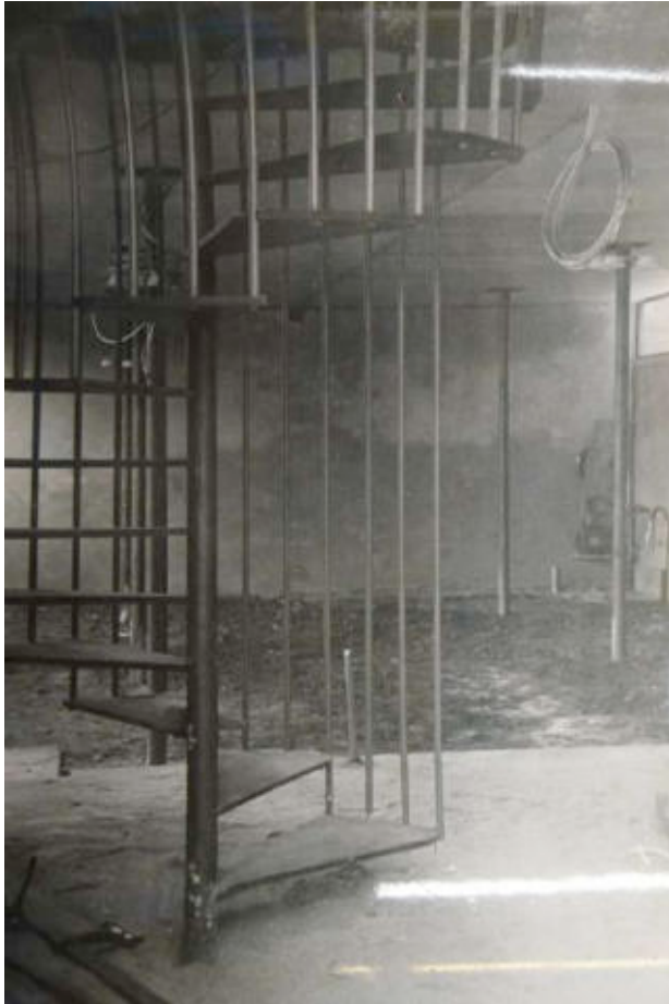
Ill. 81 « Bureaux Fakler » (Montreuil). Rez-de-chaussée avec des tubes métalliques portant le plancher du second niveau. Sans date [1948]. ALB_18.
