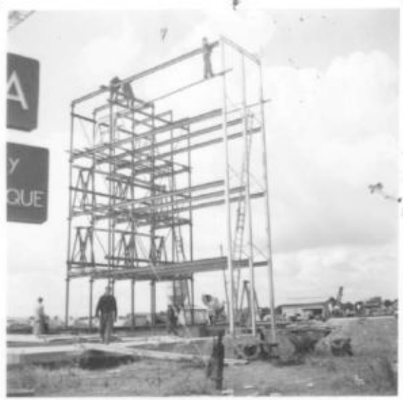
Ill. 430 « AFBA », photographie du chantier. Mise en place des échelles métalliques, raccordées au portique par des poutres IPN destinées à supporter les planchers. Daté au verso, 30 juin 1959. ALB_40.2.
