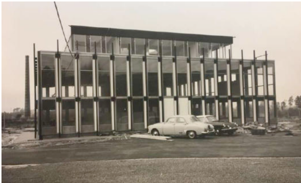
Ill. 546 « Centre d'études Vallourec » à l'achèvement des travaux, avant l'installation des bureaux. Les façades intégralement vitrées dessinent un volume presque transparent. Sans date [vers 1961]. ALB_48.2.
