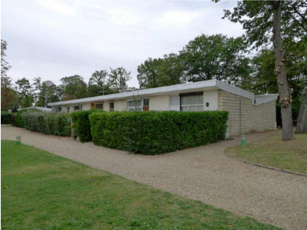
III. 126 « Minimax ». Logements préfabriqués en « bande », avec pignon en maçonnerie traditionnelle, lotissement du Parc de Maisons-Laffitte. État en 2011, cliché de l'auteur.
