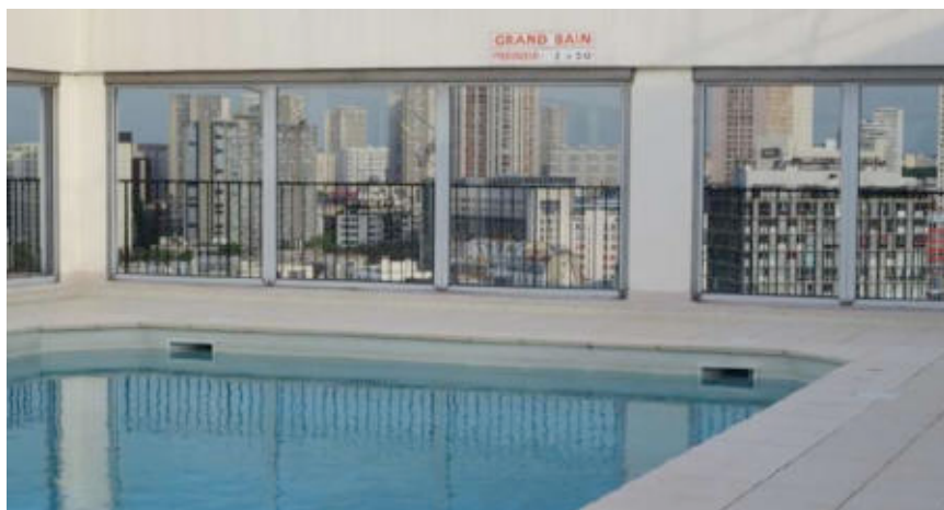
Ill. 591 Piscine au sommet de la tour dessinée par Gilles Gauthier et Pierre Milande, servant de réserve d'eau en cas d'incendie. Sur la droite on aperçoit le « Gratte-ciel n°1 ». Cliché de l'auteur, juillet 2013.
