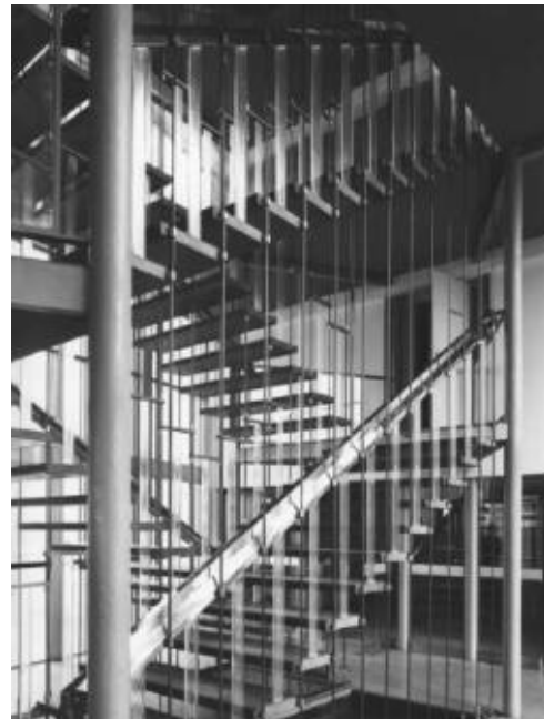
Ill. 968 « Bibliothèque universitaire de Nanterre », escalier entre les salles de lecture. Sans date [vers 1969]. Archives de François Maroti.
