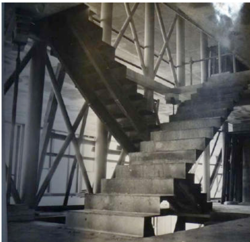
Ill. 589 Escaliers métalliques préfabriqués (6 e étage). Lors de travaux visant à l'amélioration de la sécurité incendie, ils sont retirés au rez-de-chaussée et remplacés par des volées en béton armé. En 2017, dans le cadre d'une campagne de remise en état et de sécurisation du hall, de nouveaux escaliers métalliques sont installés, suivant le dessin initial conçu par Albert. ALB_35.
