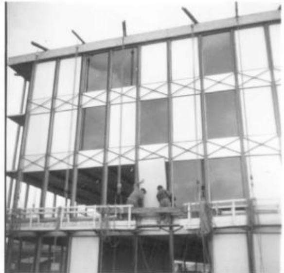
Ill. 432 « AFBA », photographie du chantier. Sans date [c.1961]. ALB_40.2.
