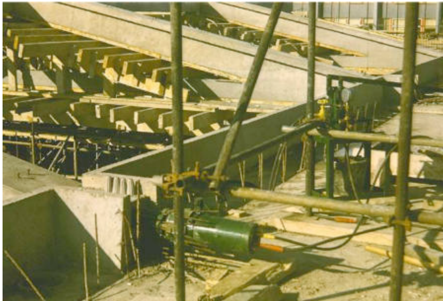
III. 416 « Centre de Réapprovisionnement et d'Armement Commercial » d'Air France. On distingue le système de mise en tension des files métalliques. Bibliothèque Kandinsky, fonds Édouard Albert. Cliché Édouard Guhl, non coté.
