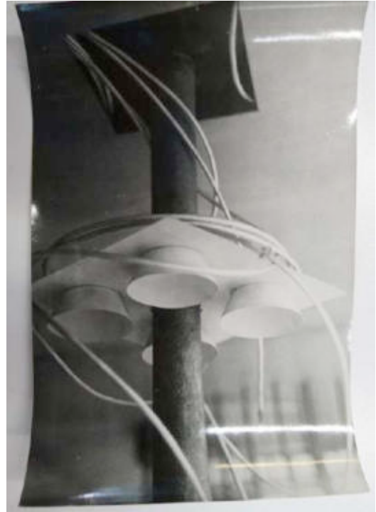
Ill. 82 « Bureaux Fakler » (Montreuil). Détail mettant en évidence la jonction entre le tube structurel et les planchers préfabriqués, abritant les câbles électriques. [Gros plan intentionnel de l'architecte. Ce détail est visible sur le cliché précédent, derrière l'escalier]. ALB_18.
