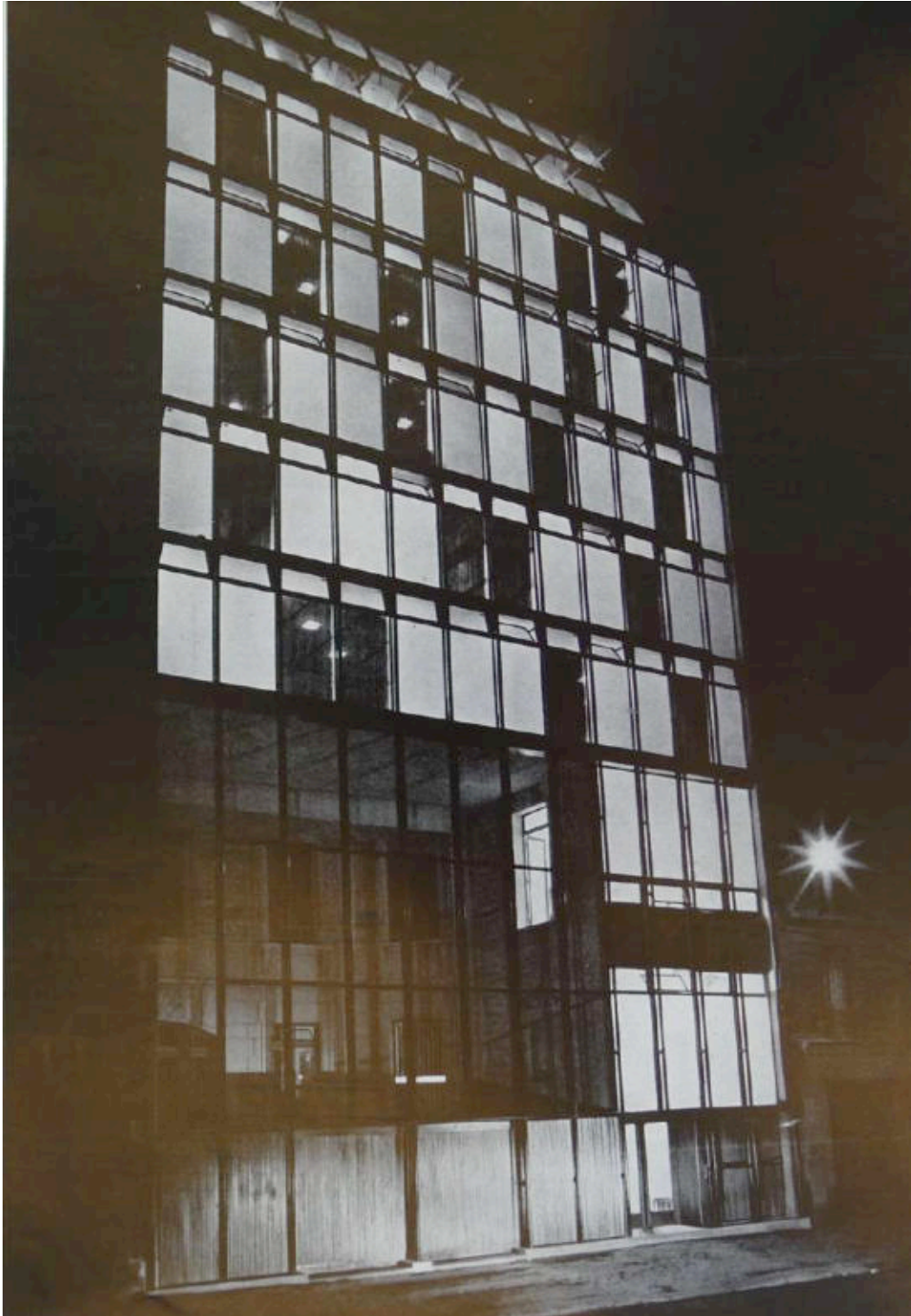
III. 556 Cliché publié in ALBERT Édouard, « Un essai d'architecture tubulaire », Acier Stahl Steel , n° 6, juin 1956, p. 245.
