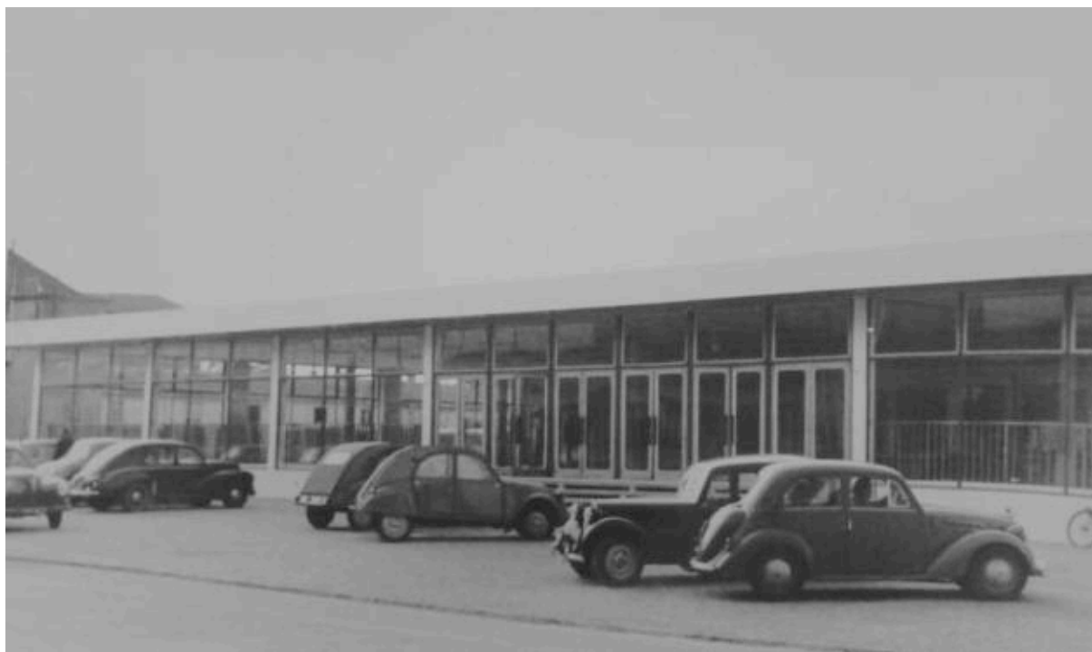
III. 400 « Cantine nord d'Air France », vue de l'entrée principale. Sans date [vers 1960]. ALB_34.
