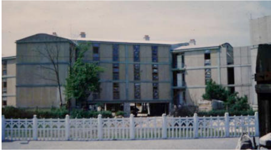
III. 236 Lotissement « Tricorne » (Vernouillet). Sur la gauche du cliché, on distingue la mise en place des panneaux de béton préfabriqués, formant le remplissage. ALB_32.
