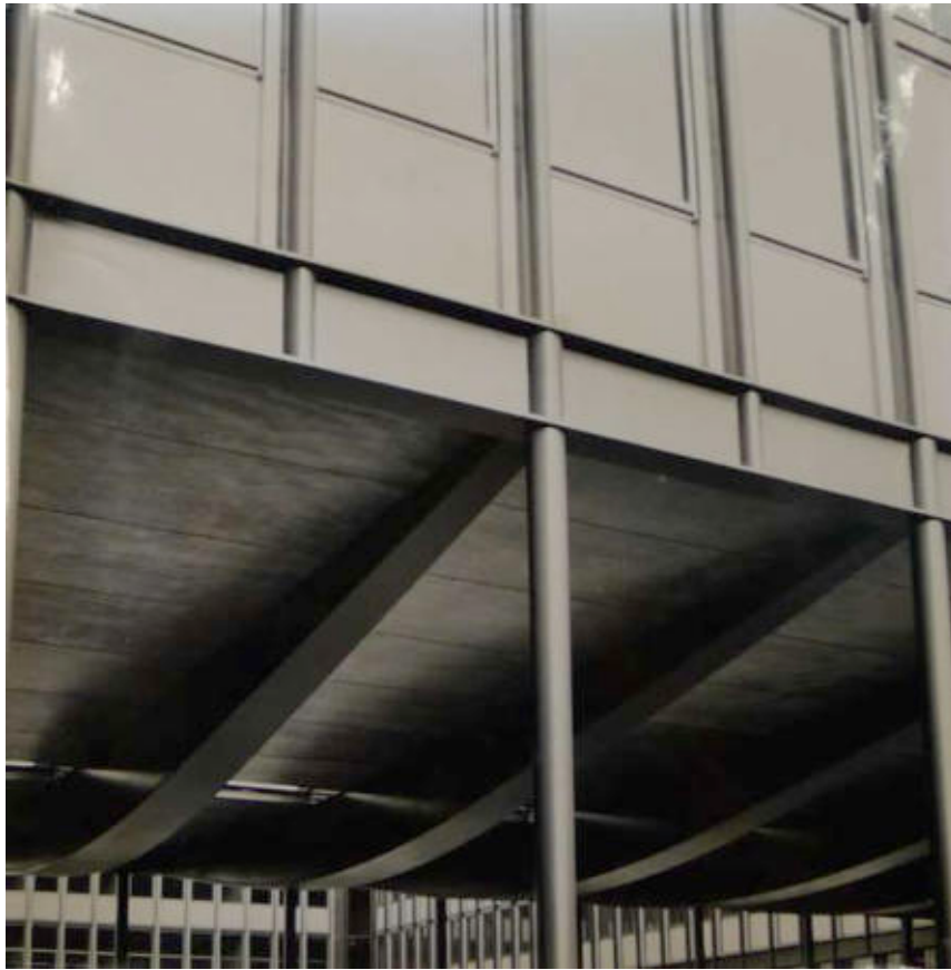
Ill. 718 Poutres « gondoles » de 18 mètres de portée du niveau « Jussieu ». ALB_53.2.
