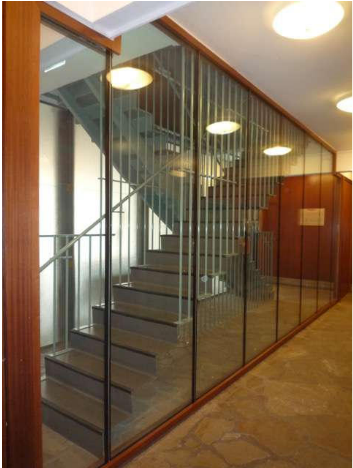
III. 601 Vue des nouveaux escaliers métalliques du rez-de-chaussée, mis en place lors des travaux de restauration du hall en 2017. Cliché d'Arnaldo Coutine, décembre 2018
