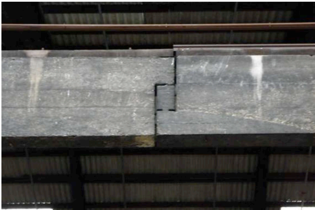
Ill. 75 « Usine de forge » Grosdemouge. Détail pour la dilatation des poutres longitudinales de la nef de 75 mètres de longueur. Cliché de l'auteur, juin 2013.
