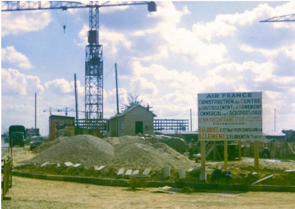
III. 415 Panneau annonçant la construction du « Centre de Ravitaillement et d'Armement Commercial » utilisant le « BETON PRECONTRAINTE STUP Procédé Freyssinet ». Sans date [1955 ?]. Bibliothèque Kandinsky, fonds Édouard Albert. Cliché Édouard Guhl, non coté.
