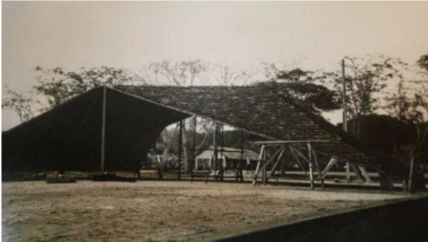
III. 687 « Église d'An-Loc ». Essai de couverture tuiles. ALB_38.
