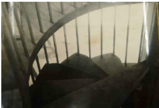
Ill. 83 « Bureaux Fakler » (Montreuil). Escalier hélicoïdal (détail) et finesse des planchers sont ici mise en évidence. Sans date [1948]. ALB_18.
