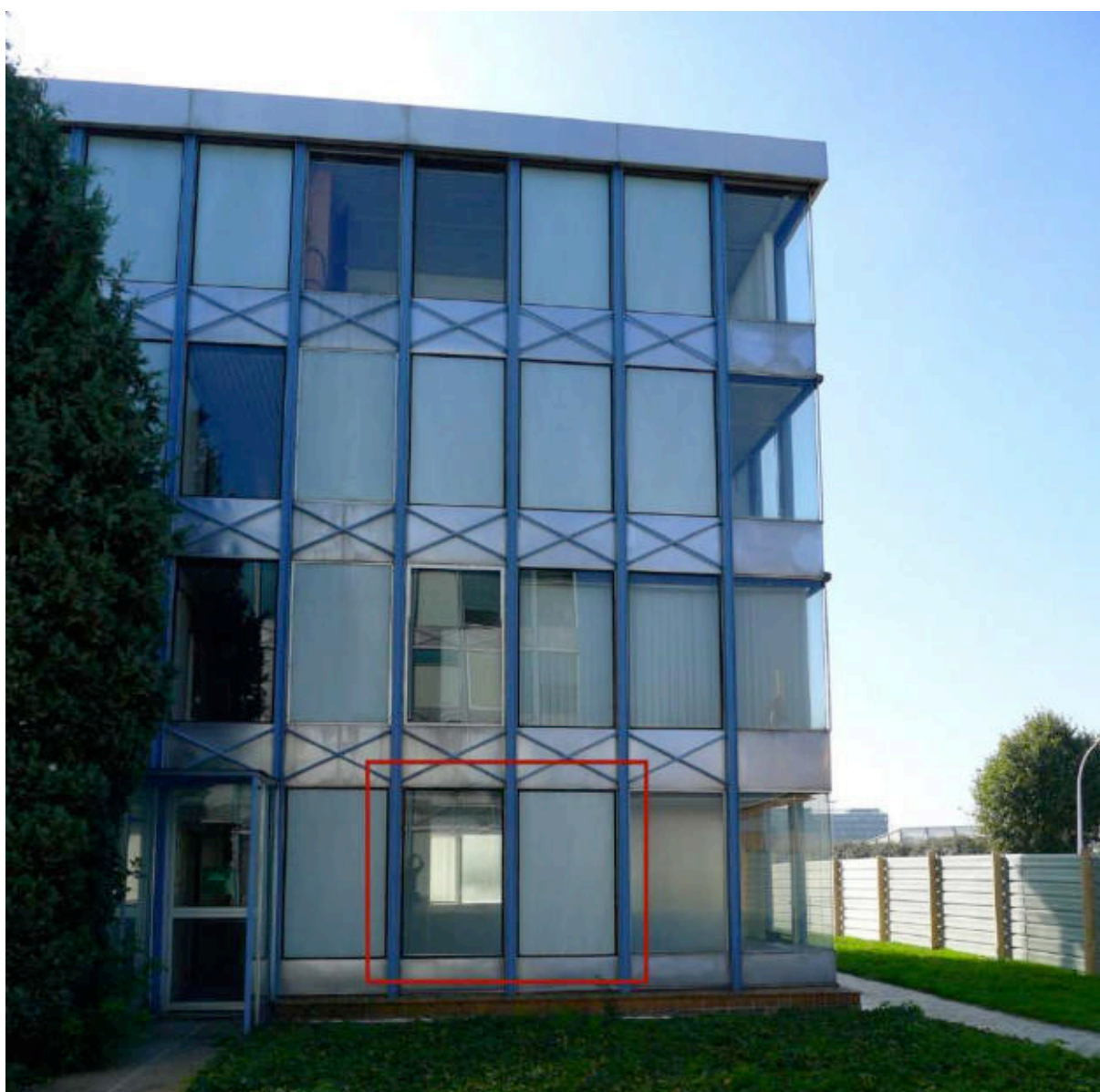
Ill. 622 Deux panneaux d'origine « glace claire » et « Thermolux » translucide, avec leurs joints néoprène noir. Beaucoup de vitrages ont été modifiés, adjonction de fenêtres basculantes mais aussi vitrage fixe translucides d'un autre type. Orly, cliché de l'auteur, septembre 2013.
