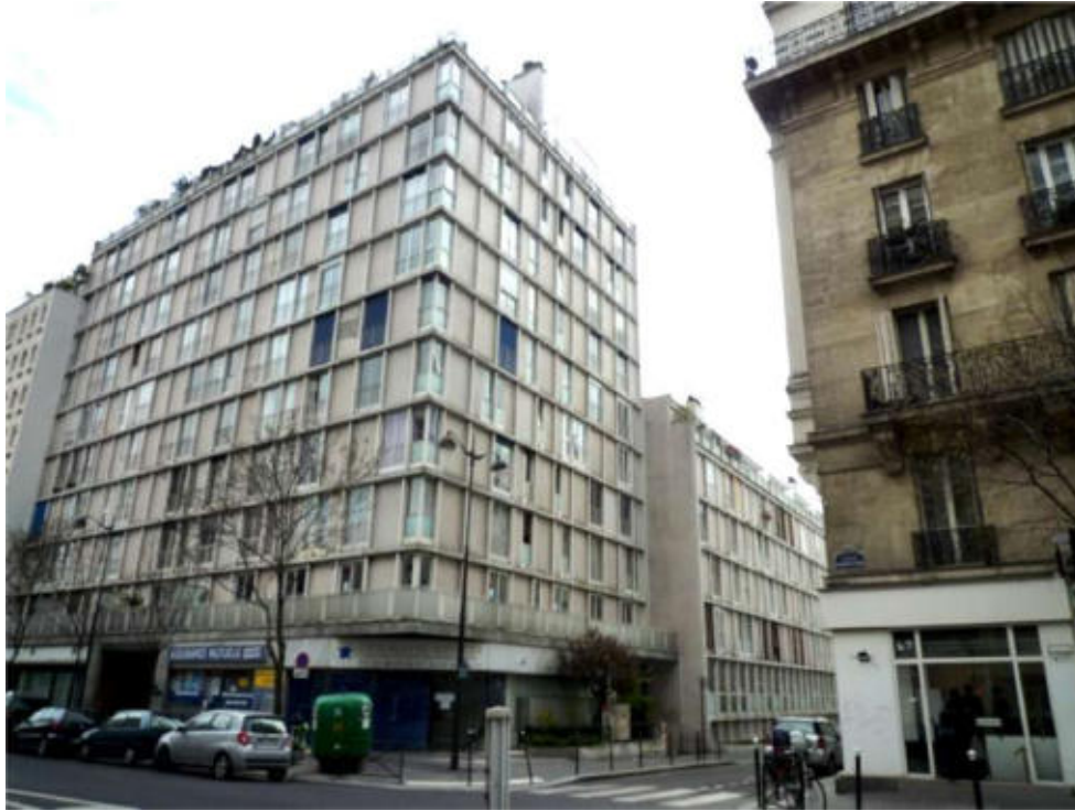
III. 485 Immeuble d'habitation 63-65, avenue Parmentier. [Les tubes de l'ossature sont initialement de couleur sombre]. Cliché de l'auteur, mars 2011.
