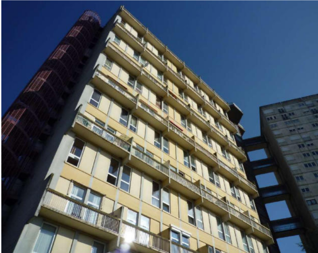
Ill. 909 « Résidences Plein Ciel ». Aile de logements en duplex avec alternance des ouvertures et balcon brise-soleil. Sur la droite du cliché, on distingue une barre réalisée postérieurement au décès d'Édouard Albert. La façade est plane et présente une stricte monotonie dans la disposition des baies. Cliché de l'auteur, 2011.
