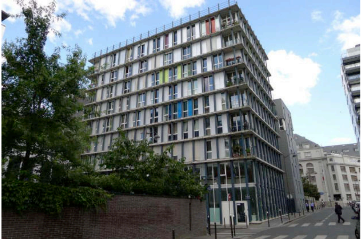
III. 627 Immeuble d'habitation, Zone d'aménagement concerté Rive gauche, Jean-Philippe Pargade architecte 2002. Cliché de l'auteur, juin 2011.
