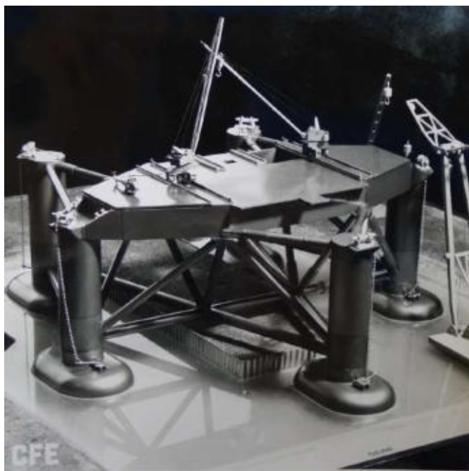
III. 1064 Tirage photographique d'une maquette de plateforme pétrolière flottante de 80 mètres d'envergure, imaginée par la CFE [Compagnie française d'entreprises]. Recto du cliché avec croquis de la structure pentagonale. ALB_56.1.
