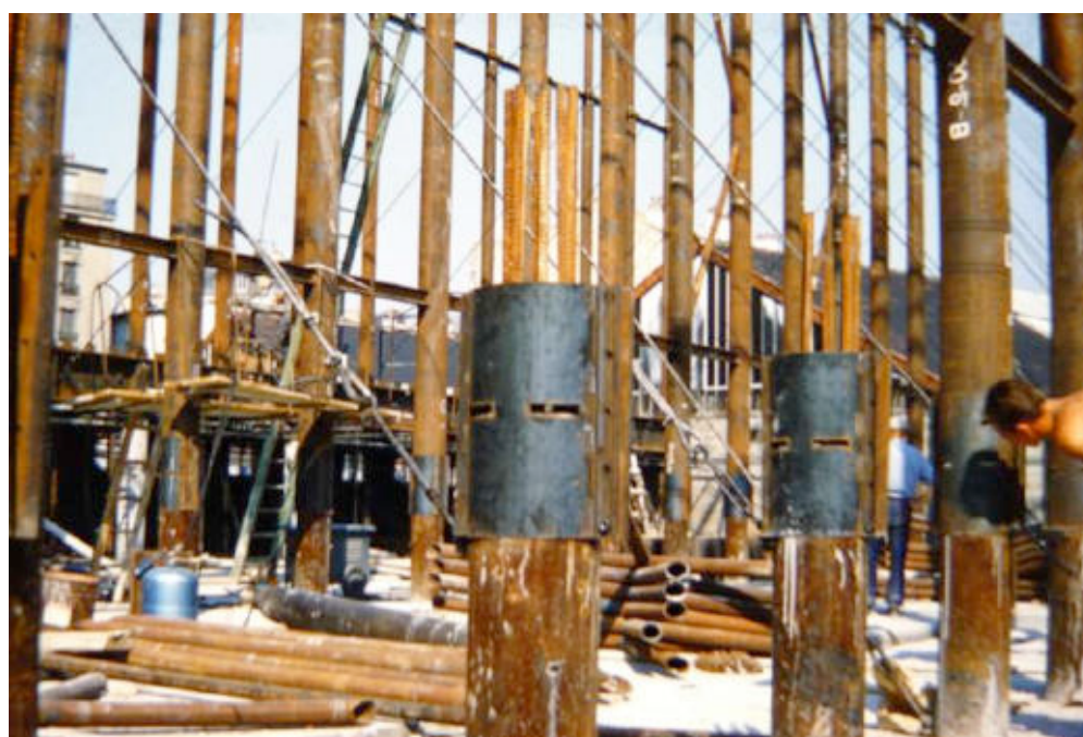
Ill. 289 Au premier plan, on distingue le système permettant de raccorder les échelles tubulaires. Au second plan des croix de Saint-André sont entreposées au sol. Le contreventement est temporairement assuré par des câbles disposés en diagonales. A l'arrière-plan, on observe les échelles avec leurs profilés IPN soudés aux tubes verticaux. ALB_77 [Diapositives, iconographie de conférences].
