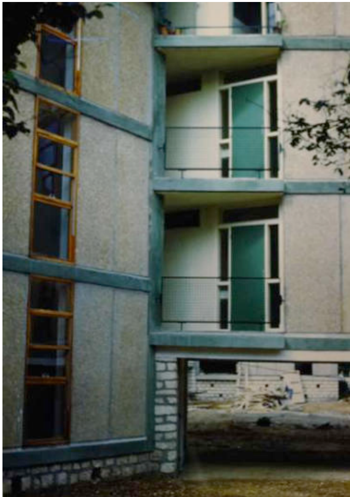
III. 237 Lotissement « Tricorne » (Vernouillet). Mise en évidence de la structure en béton armé, trame orthogonale en béton armé peint en vert, panneaux de remplissage avec gravier de couleur ocre, fenêtres en bois et soubassement en pierre. Diapositive en couleur. ALB_32.
