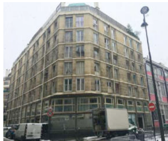
Ill. 529 Immeuble 9-11, rue Roger Bacon. Vue de l'angle entre la rue Roger Bacon et la rue Aumont-Thiéville. Cliché de l'auteur, février 2018.
