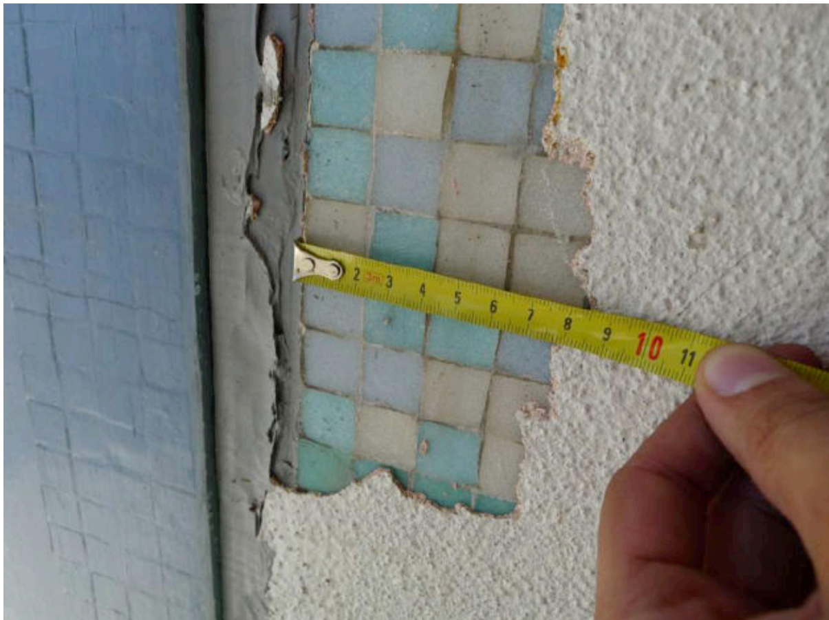
Ill. 618 Ancien hall des bureaux d'Air France. Sous un épais crépi, on retrouve la trace des mosaïques du hall. Il s'agit d'un motif abstrait en pâte de verre, offrant la même vibration que le remplissage irrégulier des façades. Cliché de l'auteur, septembre 2013.
