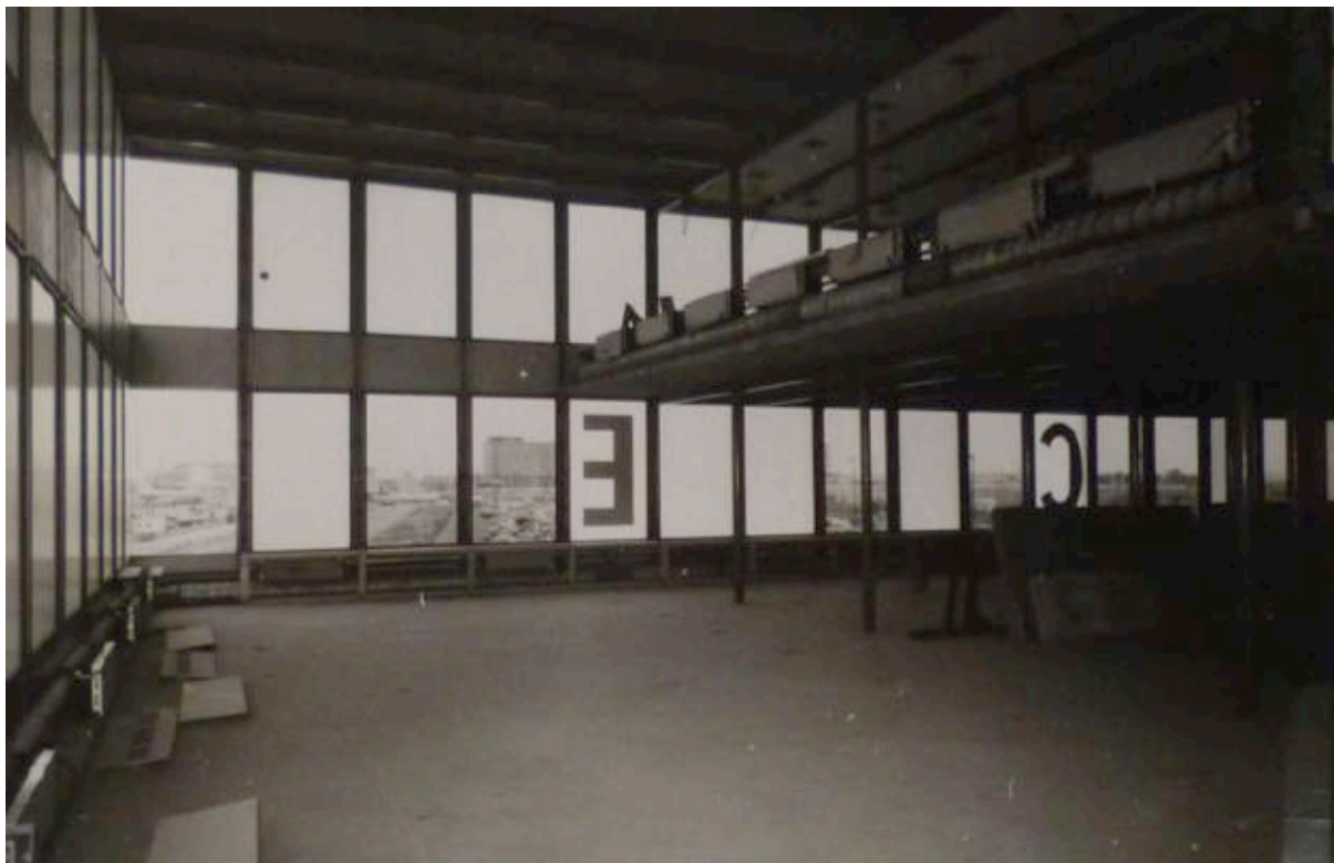
III. 428 « AFBA », Double hauteur de la « Salle des mouvements » pour le contrôle des avions. Sans date. ALB_40.2.
