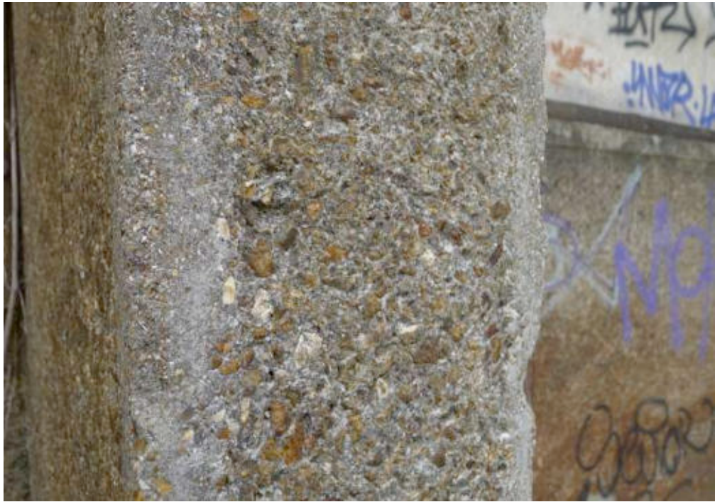
III. 68 « Usine métallurgique » Grosdemouge (1939-1940). Détail d'un pilier en béton armé bouchardé, béton bouchardé. Cliché de l'auteur, 2013.
