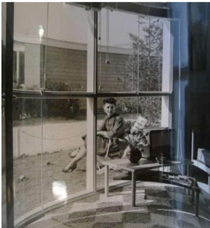
Ill. 117 « Minimax ». Vue depuis l'intérieur de la maison présentée au Salon des arts ménagers, Esplanade des Invalides, 1954. ALB_28.5.
