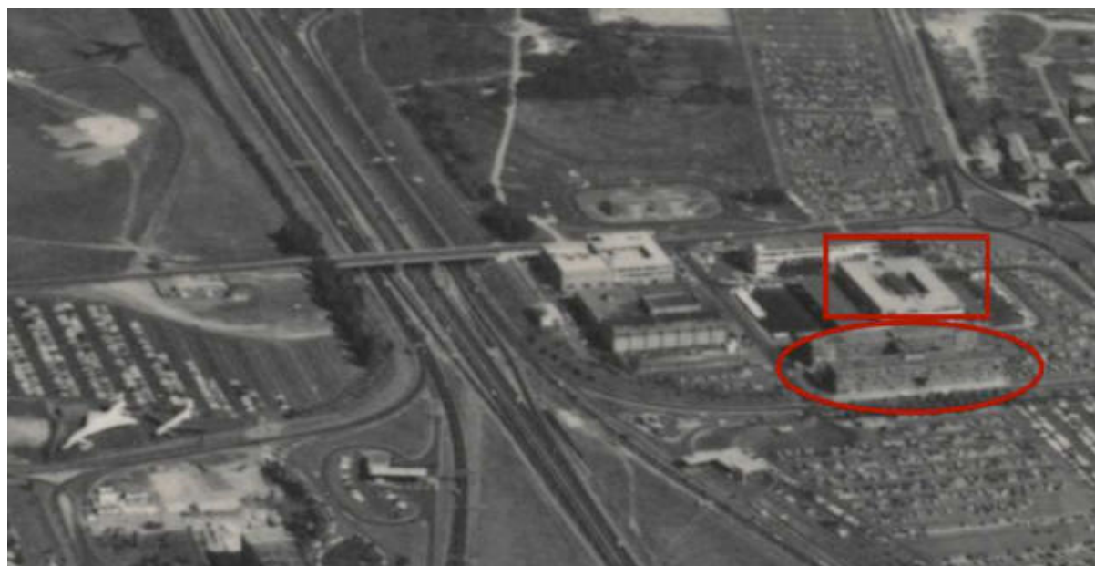
III. 405 Photographie aérienne de l'aérogare en 1971. A la loupe, on distingue les bureaux administratifs d'Air France, ainsi que le « CRAC » avec en son centre une cour. A gauche, le concorde avec son aile delta incarne l'envol du progrès. Archives du musée Air France, non coté.
