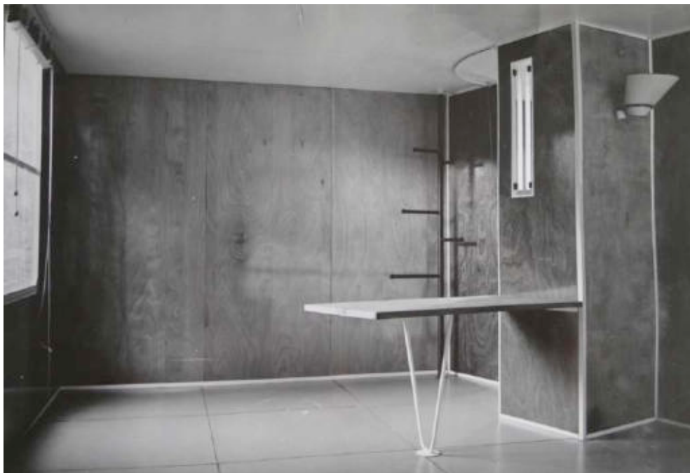
Ill. 354 Cloisons préfabriquées avec placage de bois. Maison Philhome [vers 1949]. Photographie n°5236, album n°140, fonds photographique de l'IHA.
