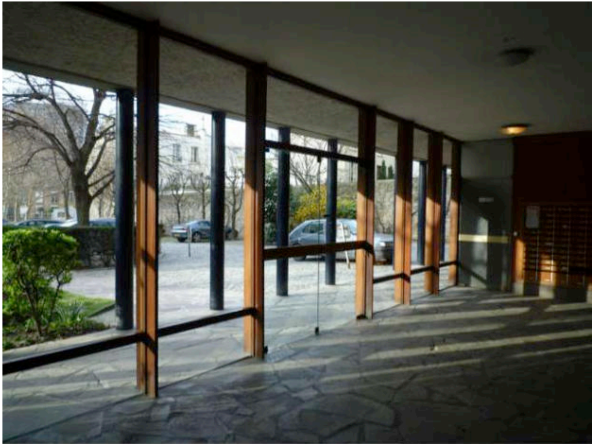
Ill. 327 Vue depuis le hall du gratte-ciel. La clôture vitrée est placée en retrait de l'alignement de la file de tubes. On note les minces raidisseurs en bois maintenant de larges surfaces vitrées descendant jusqu'au sol. Le dallage en opus incertum du chemin se poursuit dans le hall, contribuant à annuler la dichotomie entre intérieur et extérieur. Cliché de l'auteur, mars 2011.
