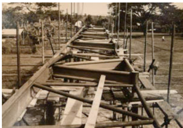
III. 681 « Église d'An-Loc ». Détail d'une poutre latérale. Sans date [vers 1963]. ALB_38.
