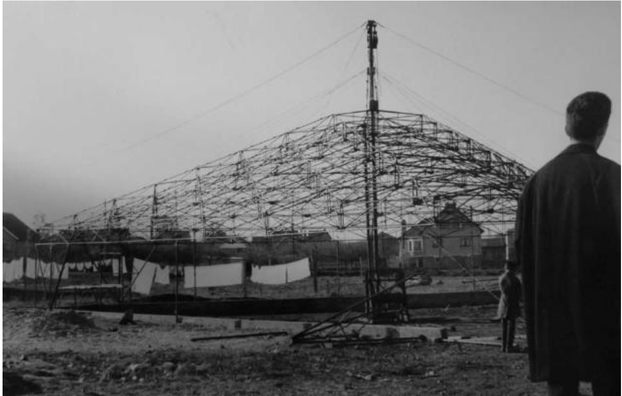
III. 643 « Chapelle de Montconseil ». La charpente est élevée grâce à un mat temporaire suivant une solution employée par Buckminster Fuller pour la réalisation de ses dômes géodésiques. Sans date [1960]. ALB_41.1.
