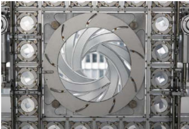
Ill. 1055 Détail d'un panneau de façade de l'Institut du monde arabe (1987, Jean Nouvel et Architecture Studio). On aperçoit, à travers le mécanisme filtrant la lumière, une façade du gril d'Édouard Albert. Cliché Fabrice Cateloy – IMA.
