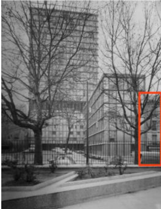
Ill. 269 « Gratte-ciel n°1 », 1961. ALB_35 L'immeuble situé au n°35, juste à droite du « petit bâtiment » d'Édouard Albert, est celui figurant sur le cliché d'Henri Godefroy.
