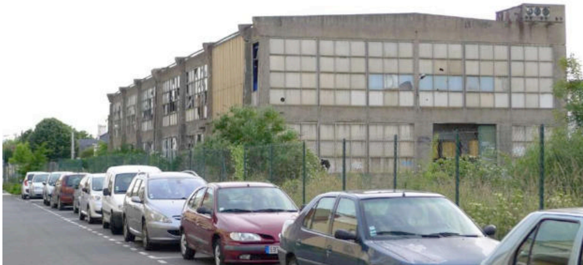
Ill. 64 « Usine métallurgique » Grosdemouge (1939-1940). État du bâtiment désaffecté, 2013. Cliché de l'auteur.
