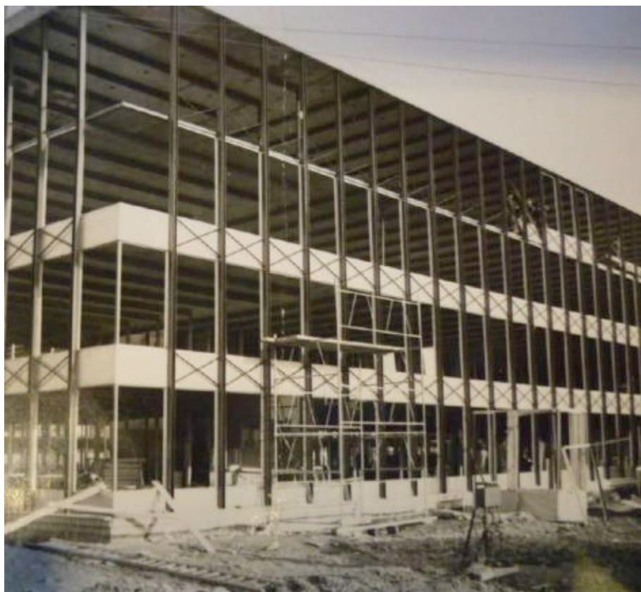
III. 433 « AFBA », photographie du chantier. Daté au verso, 6 décembre 1959. ALB_40.2.
