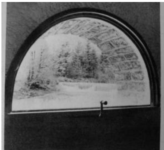
Fenêtre demi-circulaire avec glace « Securit » coulissante, qui se manœuvre comme une glace de voiture.
