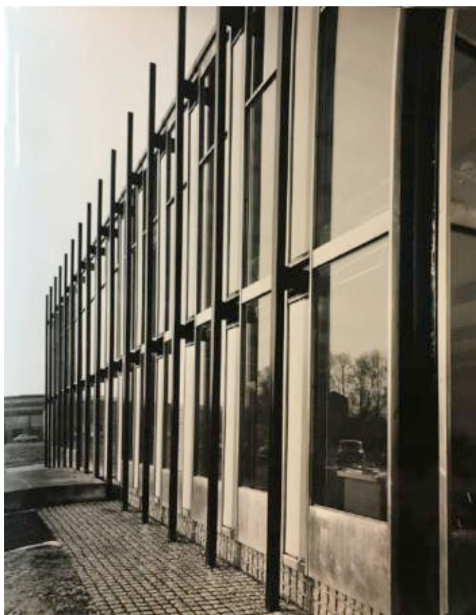
Ill. 555 « Centre d'études Vallourec », angle du bâtiment. Le prolongement des tubes ne relève pas de la rationalité mais davantage d'une question d'équilibre visuelle et de transition avec le dernier niveau. ALB_48.3.
