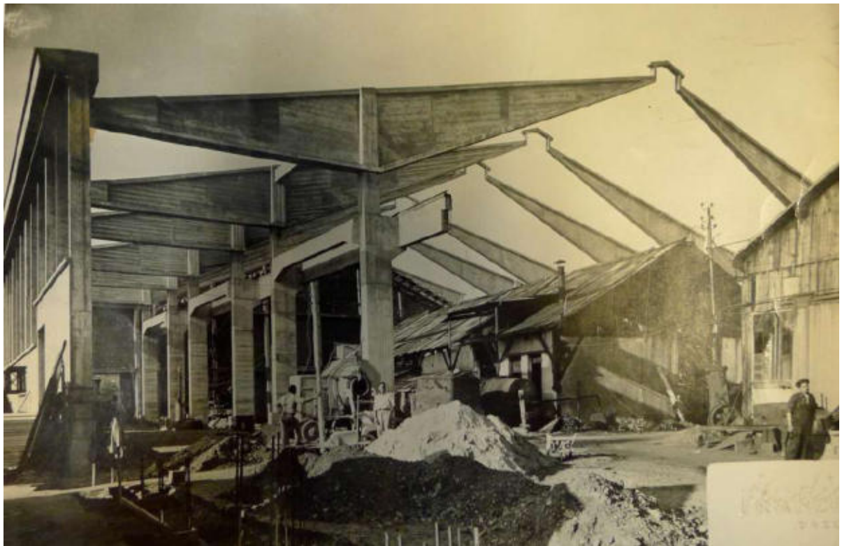
III. 69 « Usine de forge » Grosdemouge. Chantier de construction avec maintien des activités sous la nouvelle structure. Sans date [1946 ?]. ALB_13.
