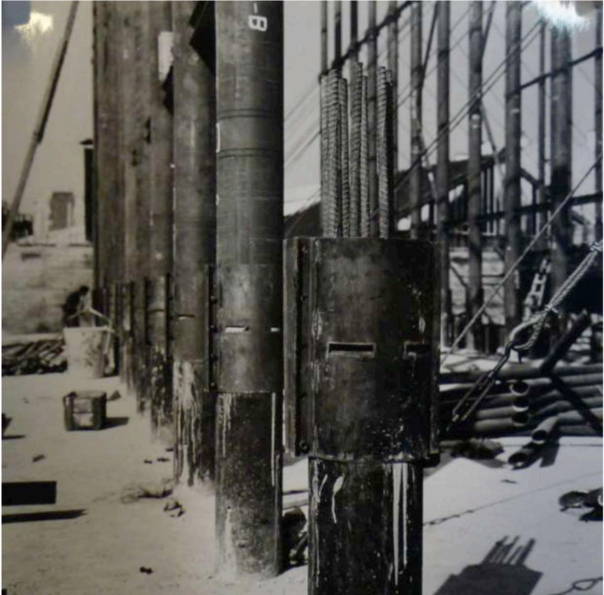
III. 482 « Gratte-ciel n°1 ». Photographie du ferrailage et du béton coulé dans un tube servant de coffrage. ALB_35.
