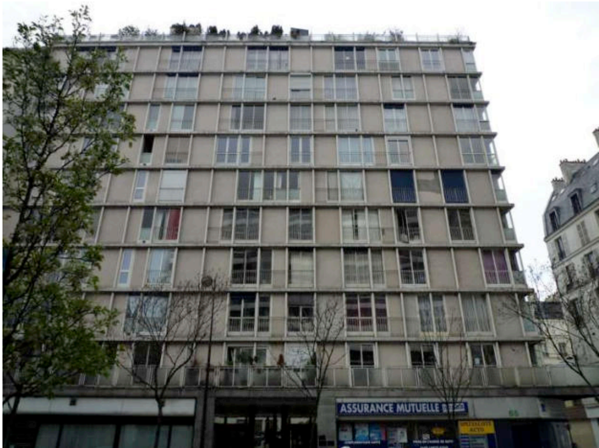
III. 613 Immeuble d'habitation 63-65, avenue Parmentier, Paris. État de la façade principale en 2011 [Les poteaux métalliques sont peints en blanc]. Cliché de l'auteur, mars 2011.
