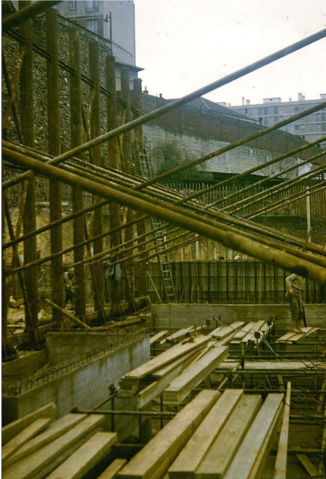
III. 300 Chantier du « Gratte-ciel n°1 ». Au premier plan, on remarque les diagonales formées par les étais maintenant la structure tubulaire en cours de montage. A l'arrière-plan, on aperçoit le mur de soutènement de la rue des Reculettes qui surplombe le terrain des frères Noël. Tout à fait au fond, on distingue la trabéation de l'immeuble d'Adrien Brelet. Cliché d'Édouard Guhl, sans date [1958], conservé à la Bibliothèque Kandinsky en marge du fonds Édouard Albert, non coté.
