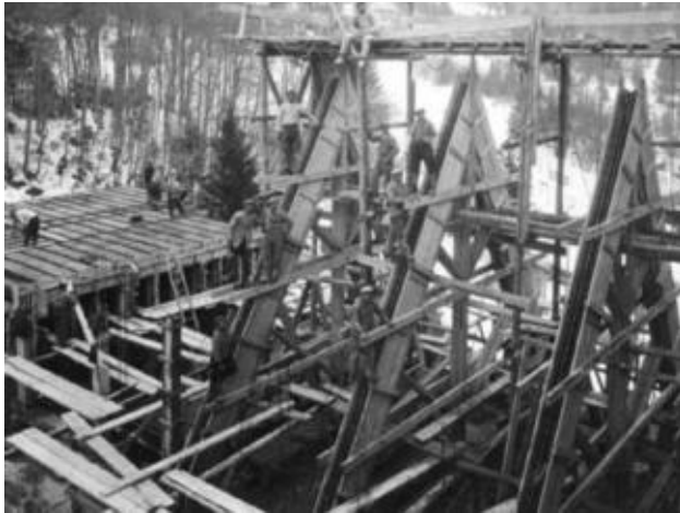
Ill. 39 Pol Abraham, chapelle du sanatorium Martel de Janville. Coffrages des fermes triangulaires, vers 1937. Cliché G. Tairraz, publié in TOBE Anne, Passy, Plateau d'Assy, montagne magique, l'art inspiré , Passy, CREHA, 2007, 93 p.
