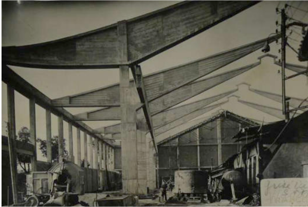
III. 70 « Usine de forge » Grosdemouge. Sans date [1946 ?]. Cliché publié in ALBERT Édouard, « Evolutions d'une conception structurale 1939-1961 », L'Architecture d'Aujourd'hui , n° 99, décembre 1961-janvier 1962, p. 44.
