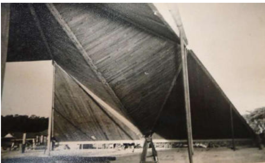
III. 689 « Église d'An-Loc », sous face des panneaux de bois. ALB_38.
