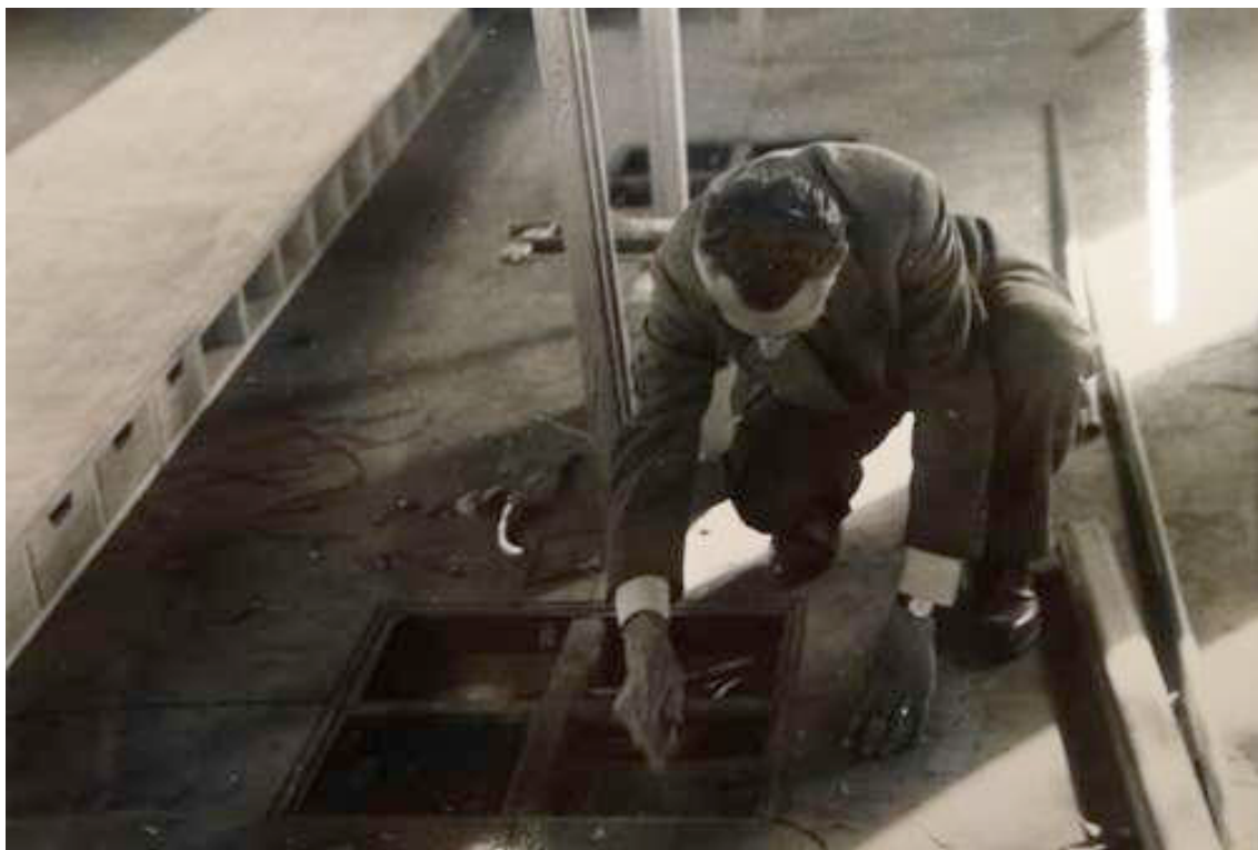
III. 88 « Bureaux Fakler » (Montreuil). Édouard Albert sur le chantier, vérifiant un élément du plancher préfabriqué. Sans date [1948]. ALB_18.
