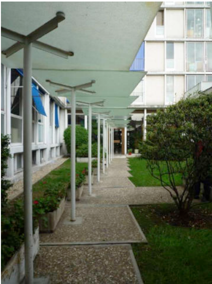
Ill. 496 Passage couvert en tubes métalliques et verre. Cliché de l'auteur, mars 2011.
