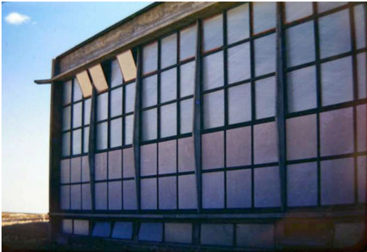
III. 216 « Centre d'émission d'Étampes ». Extrémité de la façade du bâtiment principal, avec raidisseurs en béton armé et cadre en béton préfabriqué. Diapositive couleur. Sans date [1950-1951]. ALB_24.4.
