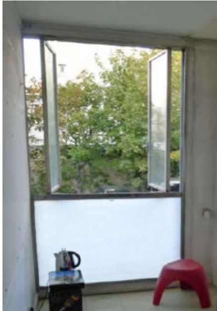
III. 599 Fenêtre d'origine, s'ouvrant vers l'extérieur et se décalant grâce à un système de rail afin de rendre accessible la partie du vitrage située à l'extérieur. Cliché de l'auteur, octobre 2011.
