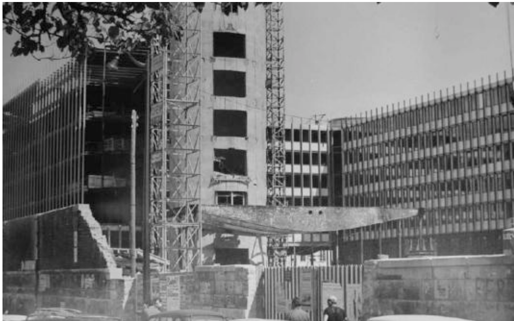
Ill. 715 Tirage photographique « grand format » [40x55cm]. Au premier plan, pose d'une poutre « gondole » ALB_53.2.
