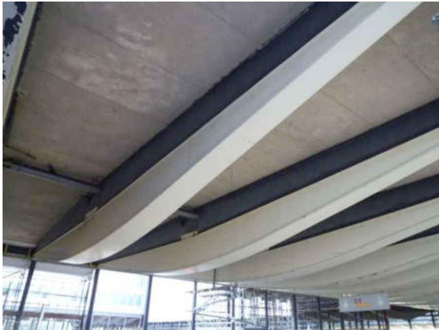
Ill. 719 Les panneaux du faux plafond dessinent une courbe qui suit la courbure des poutres gondoles, afin d'en accuser la légèreté. Cliché de l'auteur, avril 2011.
