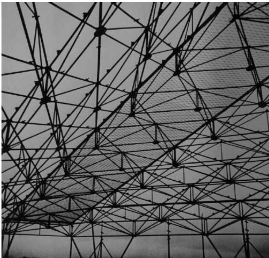
Ill. 646 Résille métallique destinée à recevoir un revêtement translucide en « Cocoon ». Sans date [1960]. ALB_41.1.
