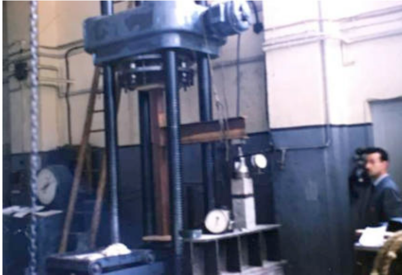
Ill. 543 « Centre de recherches Vallourec », essai de rupture d'un élément de structure. ANMT, fonds Jean-Louis Sarf, 1998_021_1195 [Diapositive couleur].
