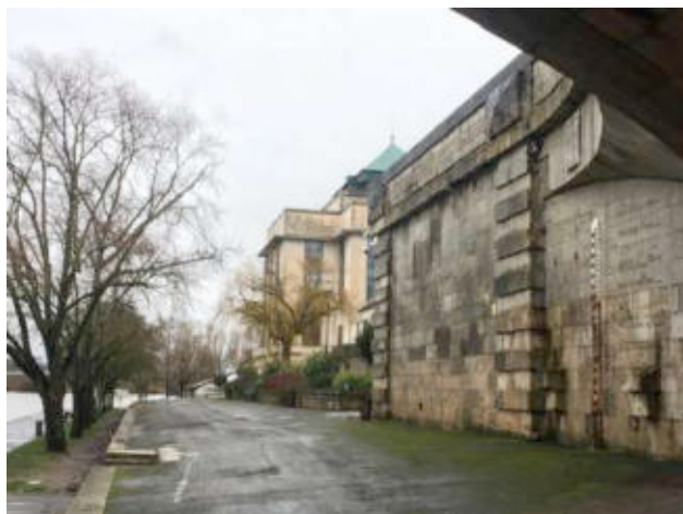
III. 834 Quai de la Loire, bibliothèque conçue par Pierre Patout, vue sous le pont Wilson dont la première pile garde la trace des crues du fleuve. Cliché de l'auteur, février 2019.
