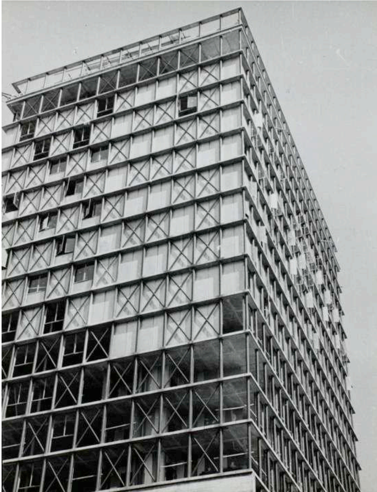
III. 358 Pignon sud. Sans date [1960]. La mise en place du remplissage et la disposition des pignons semblent relever des aléas de la livraison des éléments préfabriqués. Les compagnons suivent en réalité un plan précis, établi par Édouard Albert. ALB_35.
