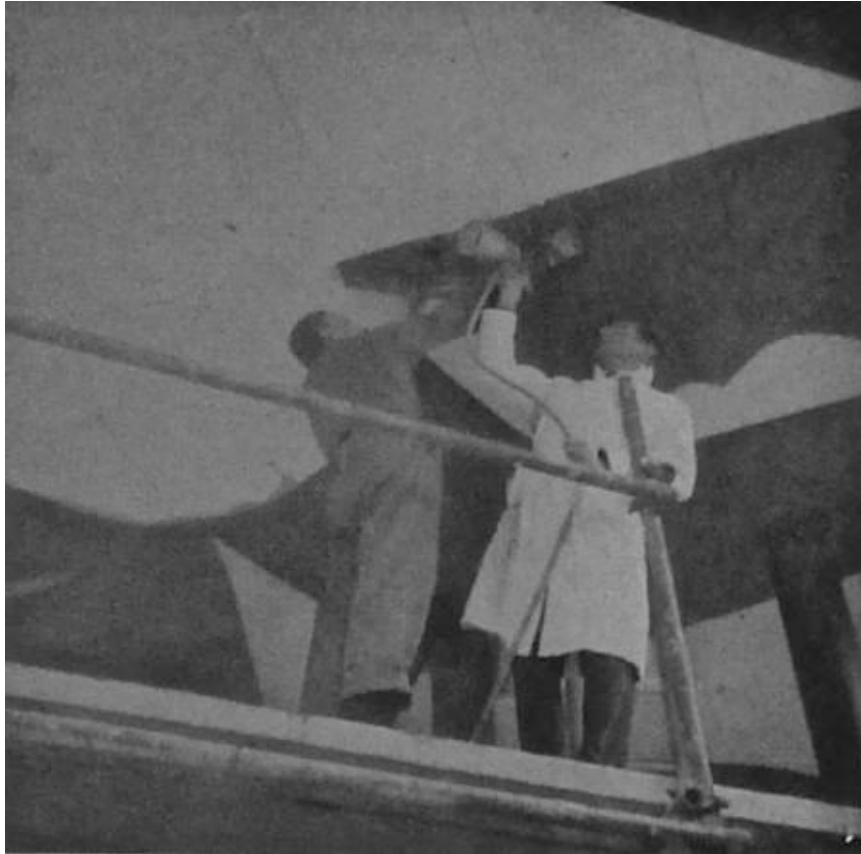
III. 389 illustration présentant l'application de la laque Noxall au pistolet pour la réalisation du plafond de l'immeuble 33, rue Croulebarbe. PAULY Claude, « Un revêtement imperméable et décoratif pour béton : la laque Noxall, à base d'isocyanates », Bâtiment , p. 20. ALB_35 [Revue de presse].
