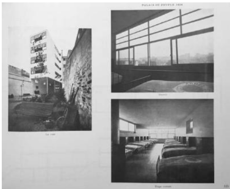
Ill. 271 Dortoir du « Palais du Peuple » de l'Armée du Salut (1926). Publié avec une axonométrie mettant en évidence le toit-terrasse (aujourd'hui remplacé par une toiture à un pan). La photographie à droite, en haut, montre la vue offerte par les fenêtres en bandeau sur le jardin des Gobelins. Clichés publiés in LE CORBUSIER, Œuvre complète, volume 1, 1910-1929 , Bâle, Birkhäuser, 1995 [Édition originale 1929], p. 124-125.
