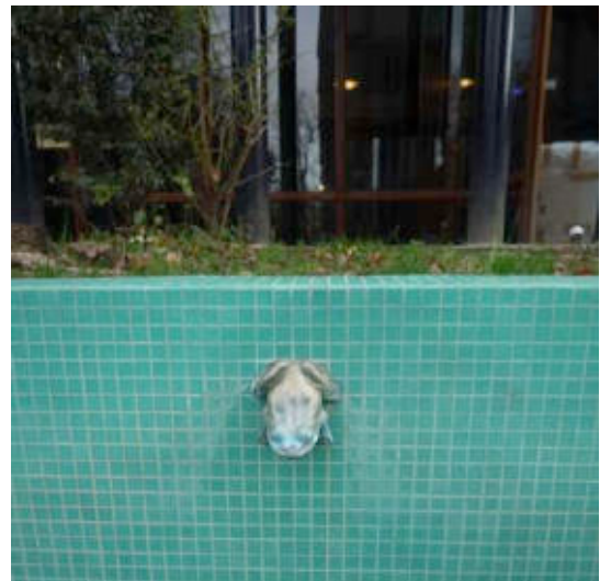
Ill. 588 Une grenouille de bronze vient à nouveau offrir un contrepoint à l'architecture préfabriquée. On décèle ici l'humour de Jacques Lagrange avec qui l'architecte collabore. Cliché d'Arnaldo Coutine, décembre 2018.
