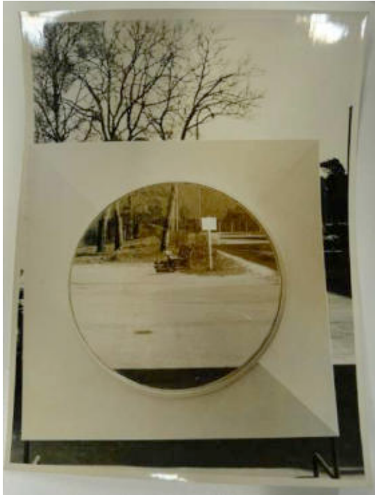
Ill. 836 « Faculté de Tours », cliché d'un panneau hublot échelle grandeur en aluminium. Légendé au verso « Prototype de panneau de façade réalisé par la S.E.A.L. 31/3/1968 ». ALB_49.
