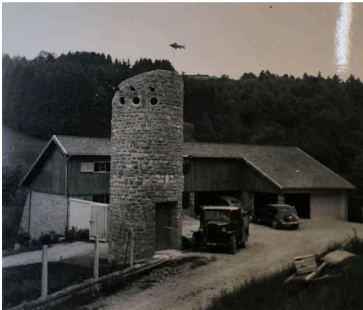
Ill. 156 « Maison Lacroix » (Conte). Pigeonnier-transformateur surmonté d'une enseigne en poisson annonçant l'entrée du « rendez-vous de pêche » de M. Lacroix. A l'arrière-plan, les dépendances de la propriété (Logement du gardien, garages, stockage). Sans date [vers 1951]. ALB_26.3.
