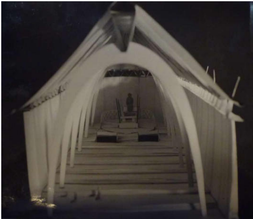
III. 32 Église du Sacré-Cœur, projet pour Mantes-la-Ville. Maquette présentant la structure composée de fermes paraboliques. Sans date [1942-1943]. ALB_17.5.
