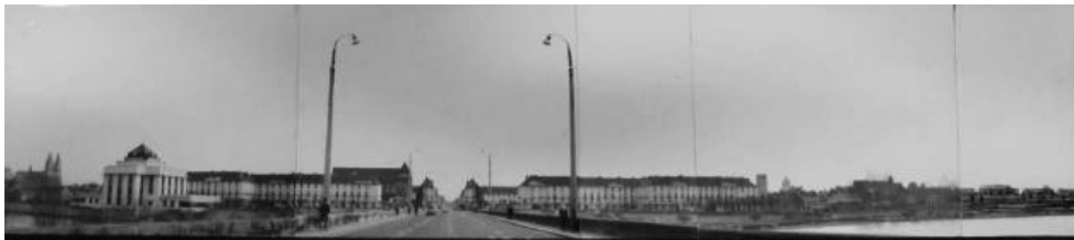
III. 806 Vue des quais de la Loire depuis l'extrémité nord du pont Wilson. Sans date [vers 1963]. ALB_49.7.
