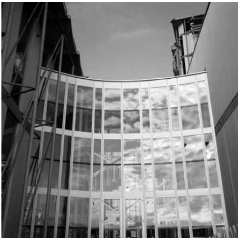
III. 790 « Bibliothèque universitaire de Nanterre ». Jonction des salles de lecture. L'œil du photographe révèle ici les jeux de transparence et les reflets offerts par les surfaces vitrées concaves. Sans date [vers 1970]. Bibliothèque Kandinsky, fonds Cardot-Joly
