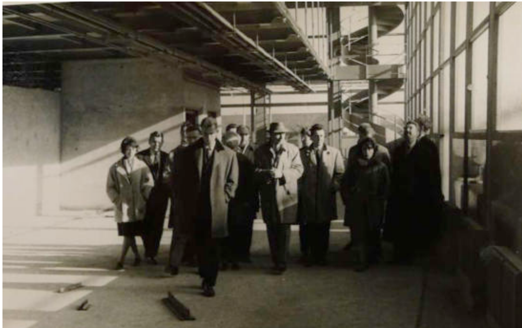
III. 414 « Centre de Réapprovisionnement et d'Armement Commercial », visite de chantier de l'architecte [au centre du cliché]. Photographie légendée au verso « Air France – Bâtiment CRAC Orly ». ALB_33.
