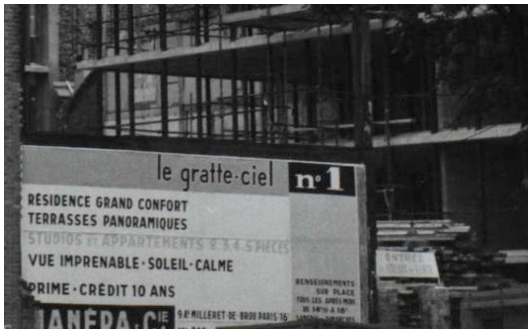
III. 266 Panneau devant le chantier. Sand date [1960]. ALB 35.
