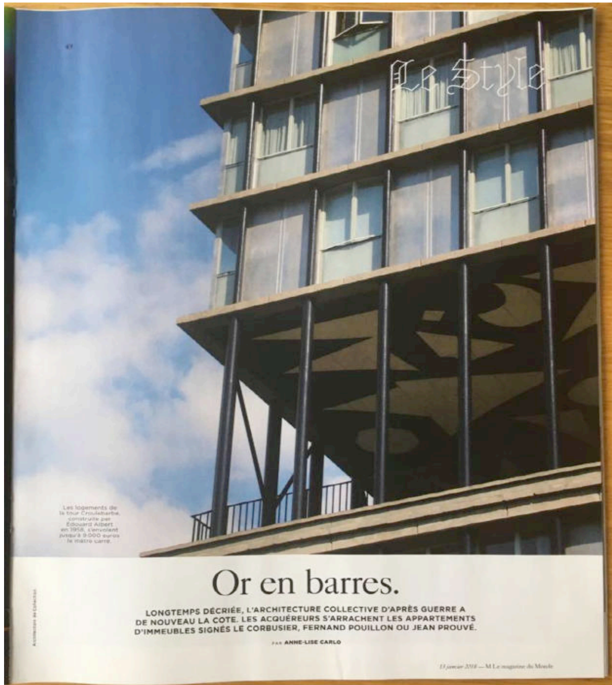
III. 575 Première page d'un article consacré au regain d'intérêt pour l'architecture d'après-guerre, avec une photographie du « Gratte-ciel n°1 » accompagné de la légende : « Les logements de la tour Croulebarbe construite par Édouard Albert en 1958 s'envolent jusqu'à 9000 euros le mètre carré. » in CARLO Anne-Lise, « Or en barres », M le magazine du Monde , 13 janvier 2018, p. 49-51.
