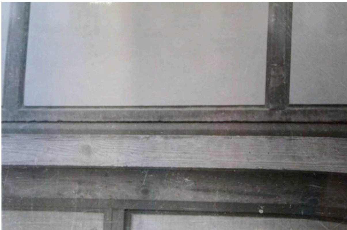
Ill. 223 « Centre d'émission d'Étampes ». Détail du béton armé traditionnel avec coffrage et béton « fondu » des cadres préfabriqués. Sans date [1950]. ALB_24.4.
