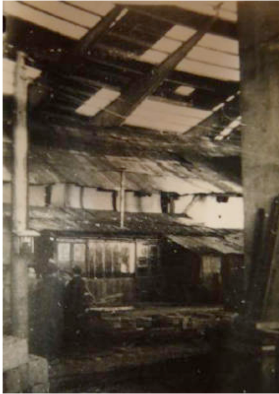
III. 72 « Usine de forge » Grosdemouge. Sans date [1946 ?]. Cliché pris lors du chantier montrant la coexistence des anciens ateliers avec la nouvelle structure en béton armé. ALB_13.
