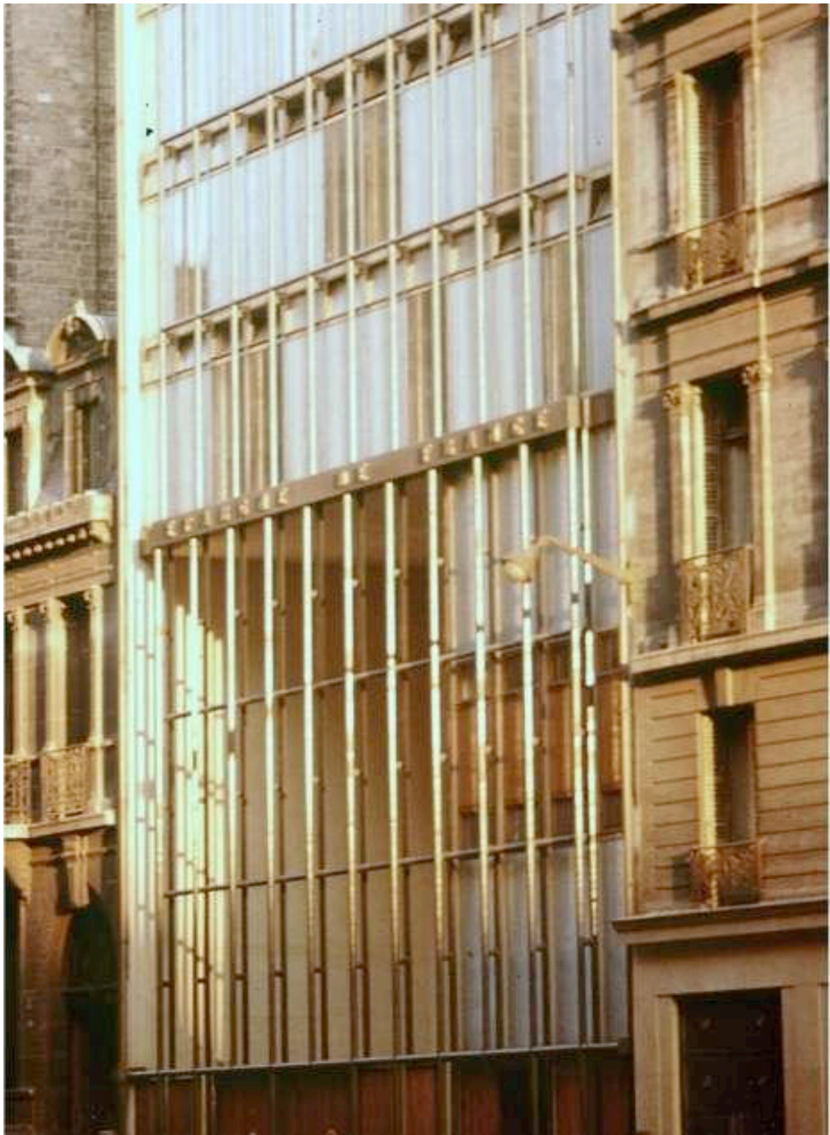
III. 607 Bureaux de l'Épargne de France 85, rue Jouffroy dans le XVII e arrondissement. Façade principale, sans date [1958]. Photographie Édouard Guhl.
