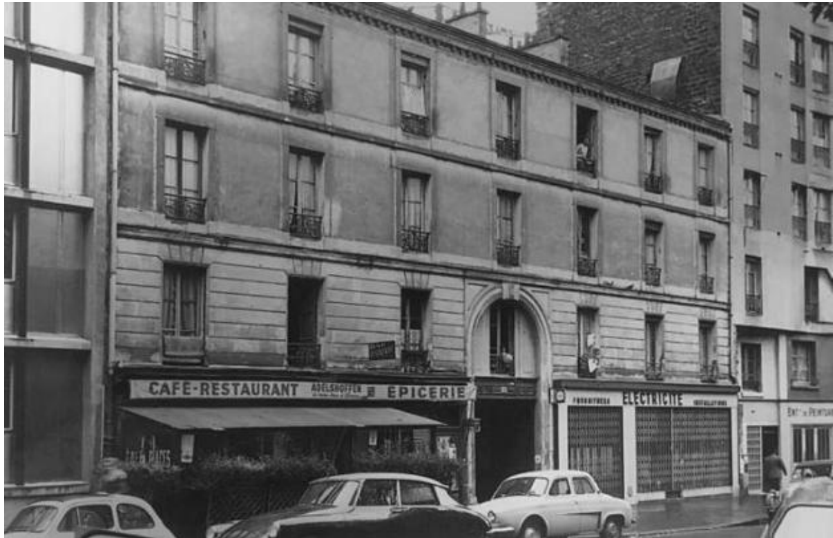
III. 604 Immeuble 35, rue Croulebarbe, sans date [vers 1961], cliché de H. Voithenleitner. On aperçoit à gauche les panneaux préfabriqués du bâtiment d'Édouard Albert. Au premier plan, une DS Citroën évoque la magie d'une époque tournée vers le progrès. A la fin des années 1960, les commerces et le « café-restaurant » laisse place à des bureaux, surmontés de logements disposants de balcons. A la date de la photo l'immeuble est déjà condamné par un projet « reconstruction », porté par les frères Noël, propriétaire de la parcelle qui s'étend jusqu'à la rue des Reculettes où ils construisent également l'immeuble mitoyen de la tour. Cf. Archives de la ville de Paris, 1069W_472.
