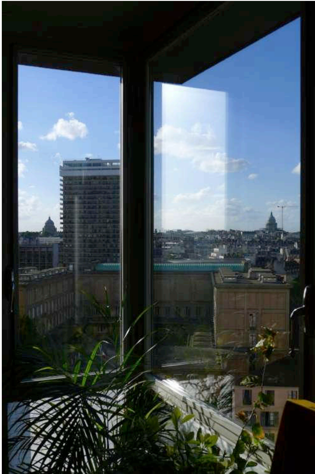
III. 363 Fenêtre d'angle avec vue sur le Mobilier national, la tour des architectes Gauthier et Milande, à l'arrière-plan les dômes du Val-de-Grâce et de l'actuel Panthéon. Mise en évidence de la jonction entre un demi panneau vitré et un panneau vitré d'angle. Il s'agit d'un des trois angles sans poteau tubulaire. Cliché de l'auteur, juin 2013.
