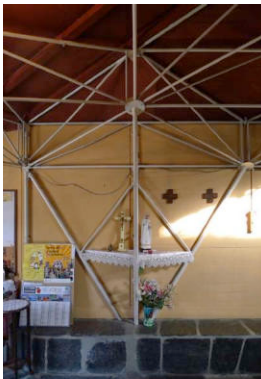
III. 657 « Chapelle de Montconseil ». Support de la charpente. Cliché de l'auteur, août 2013.
