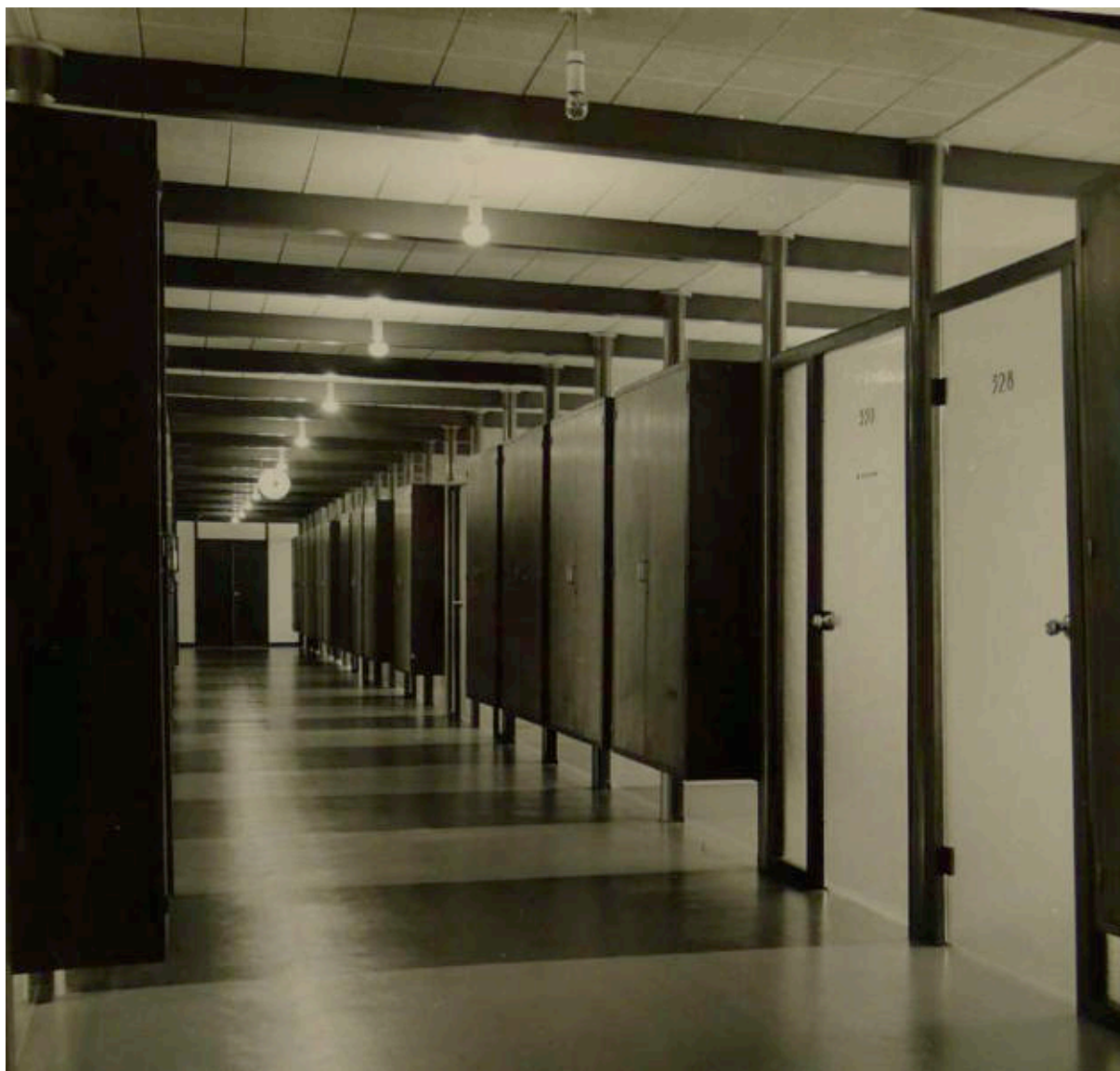
III. 470 « AFBA », couloir de circulation formé par la succession de tubes auxquels sont accroché des meuble-cloison en bois. L'espace vitré au-dessus et au-dessous contribue à laisser pénétrer la lumière naturelle dans ce couloir en principe aveugle. ALB_40.2.
