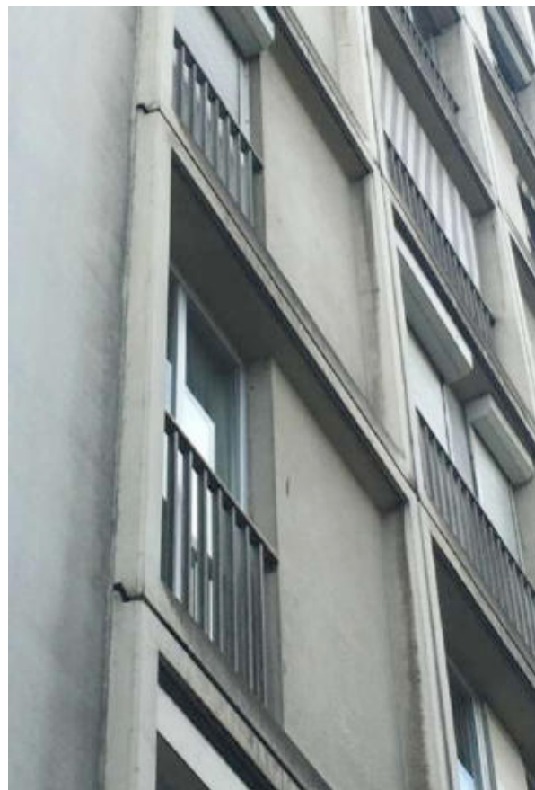
III. 920 « Immeuble 27-29, avenue Parmentier ». Détail de la jonction des panneaux préfabriqués. Cliché de l'auteur, septembre 2018.
