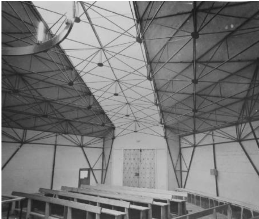
Ill. 650 « Chapelle de Montconseil », mobilier dessiné par l'agence Albert. La structure peinte dans une couleur sombre qui tranche avec le remplissage des façades. Sans date [1961]. ALB_41.1.
