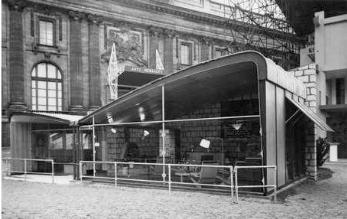
Ill. 135 Jean Prouvé, Maison « Coque », Salon des arts ménagers 1951. Fonds photographique de l'IHA. La maison offre un étonnant contraste entre la légèreté des coques et le massif mur en pierre calcaire.
