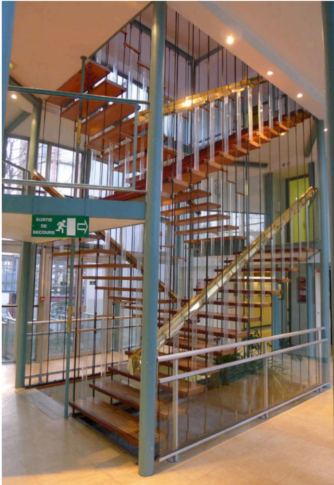
III. 791 « Bibliothèque universitaire de Nanterre », escalier suspendu à double révolution et couloirs de jonction entre deux salles de lecture. Cliché de l'auteur, mars 2012.
