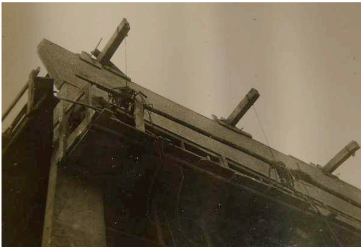
Ill. 65 « Usine métallurgique » Grosdemouge (1939-1940). Opération de bouchardage des piliers et poutres. Sans date [vers 1939]. ALB_13.
