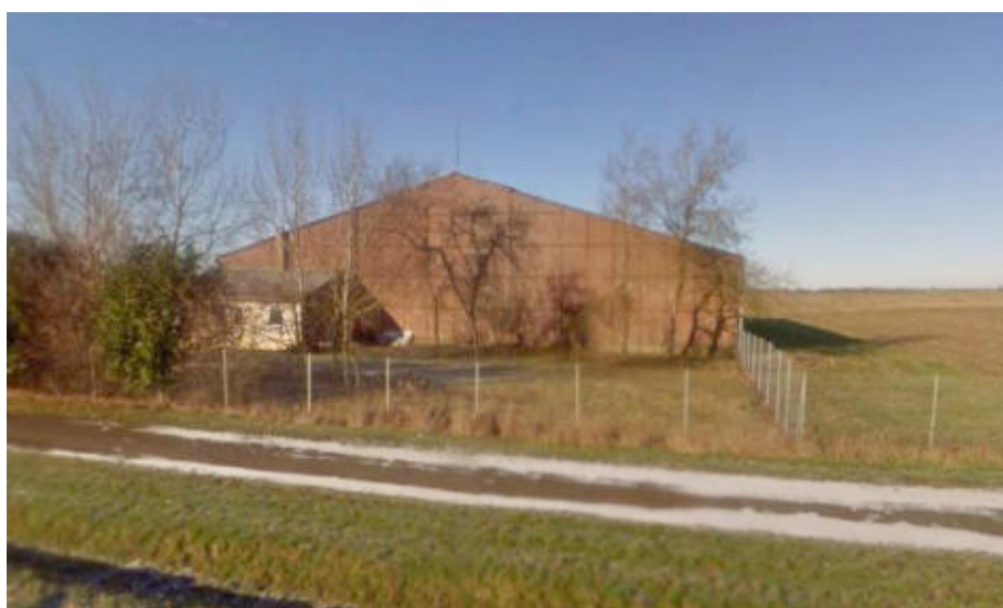
Ill. 197 Centre d'aviation légère (Étampes-Mondésir). Vue du pignon du « hangar Paindavoine », depuis la route nationale 20. Vue Google :
