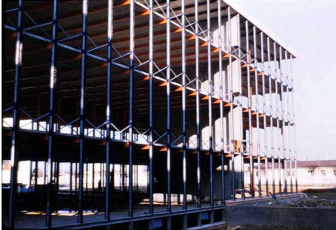
Ill. 436 « Bureaux d'Air France » à Orly. Mur de refend visible durant la construction. ANMT, fonds Jean-Louis Sarf, 1998_021_1195 [Diapositive couleur].
