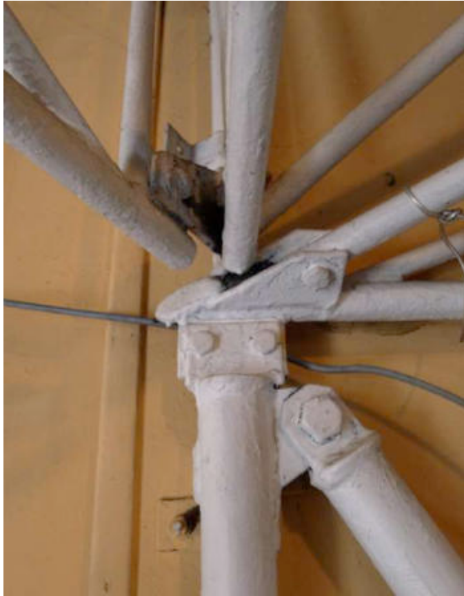
Ill. 641 « Chapelle de Montconseil ». Nœud de jonction entre les supports et la charpente. Cliché de l'auteur, août 2013.
