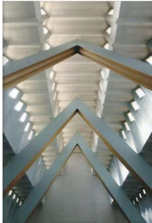
Ill. 40 Pol Abraham, chapelle du sanatorium Martel de Janville. Vue intérieure de la chapelle. Cliché Bernard Théry (?). L'architecte emploie pour ce projet un système de fermes triangulaires, distinct de l'enveloppe, comme l'envisage Albert pour Mantes-la-Ville. Cf. MIGAYROU Frédéric (dir.), Pol Abraham, Architecte , Paris, Éditions du Centre Pompidou, 2008, 213 p.
