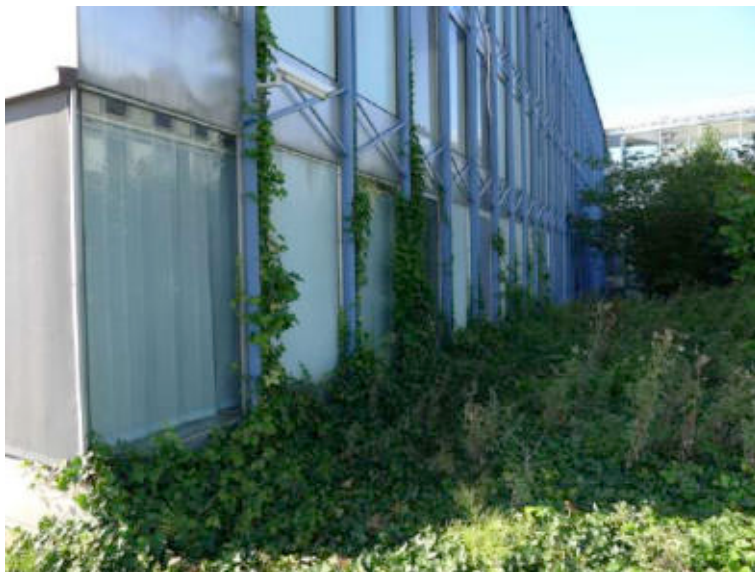
Ill. 616 Sur les anciens bureaux d'Air France à Orly, les échelles métalliques deviennent des tuteurs pour la végétation. Cliché de l'auteur, septembre 2013.
