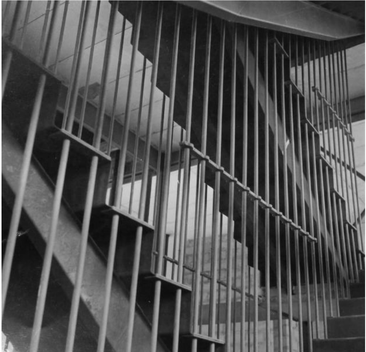
III. 385 Escalier en tôle métallique du « Gratte-ciel n°1 ». Sans date [1960]. ALB_35.
