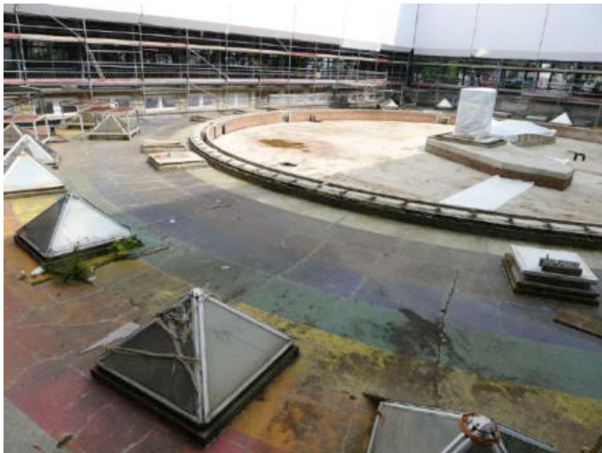
III. 751 Mosaïque polychrome pour le bassin de la cour n°32/43 en cours de démolition. On remarque le plan circulaire de la calculatrice, l'ancien bassin est percé de lanterneaux destinés à éclairer les niveaux inférieurs. Cliché de l'auteur, juillet 2011.
