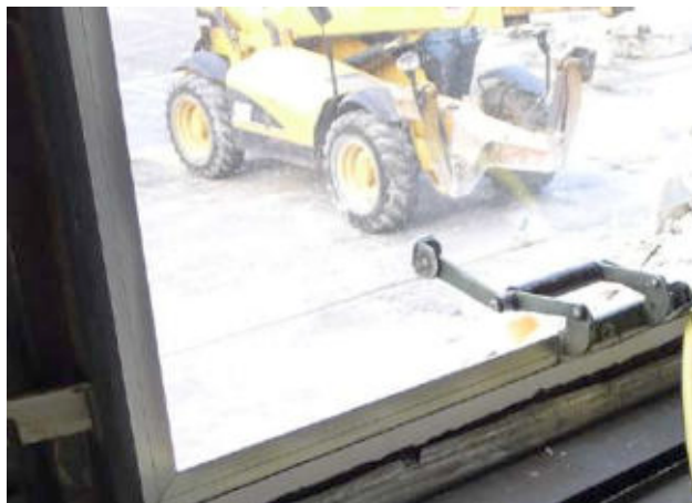
III. 620 Poignée observé lors de la démolition du bâtiment d'Orly. Cliché de l'auteur, novembre 2013.
