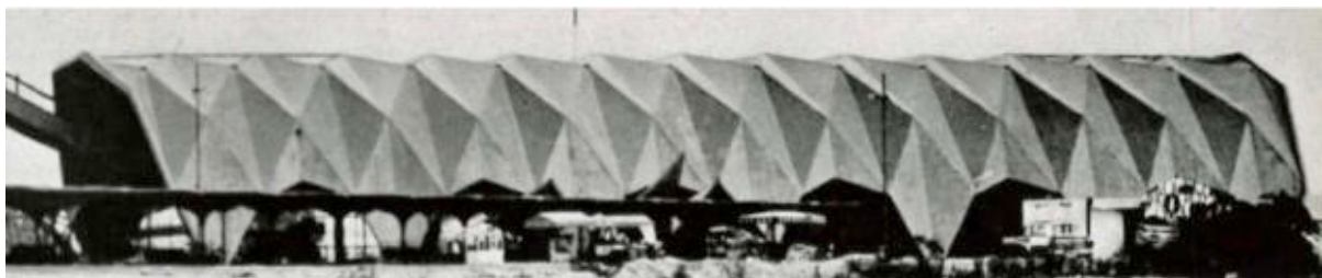
III. 697 Illustrations de la nef composée d'un « voile en accordéon » publiés in « Funiculaire, Caracas, Alejandro Pietri architecte », L'Architecture d'Aujourd'hui , n°77, avril 1958, p. 30.
