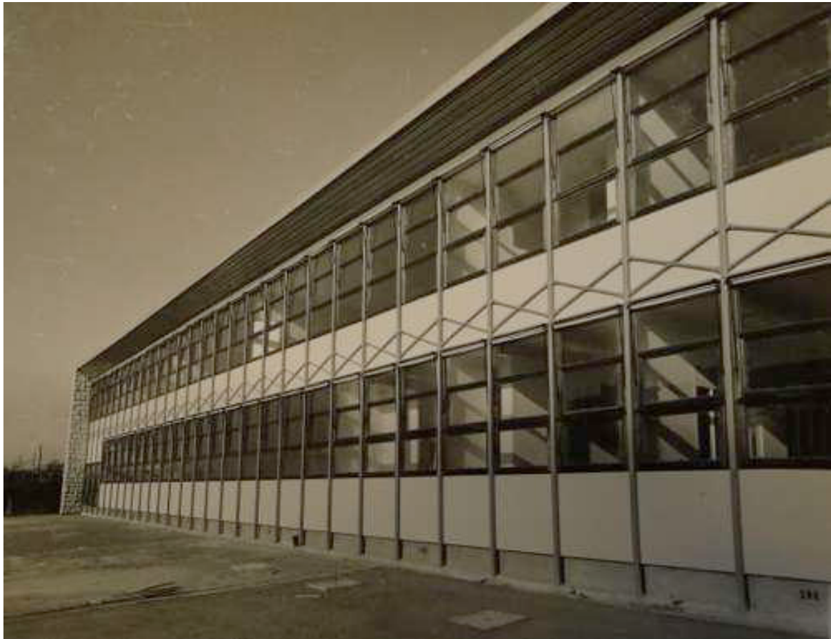
III. 497 « École maternelle - Rueil Malmaison. Édouard Albert architecte » [légende au verso]. Sans date [vers 1961]. ALB_45.
