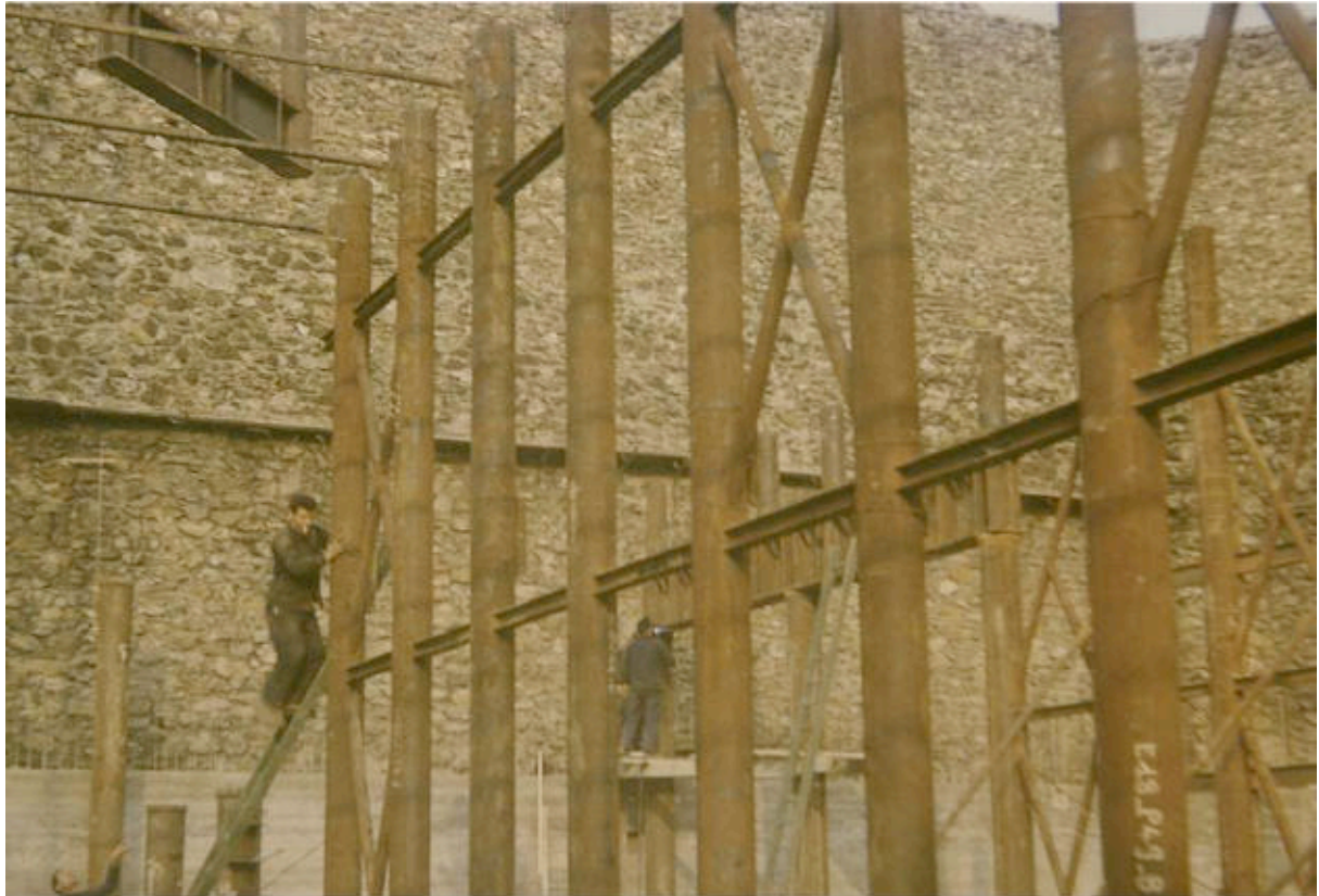
III. 286 Chantier du « Gratte-ciel n°1 ». File de poteaux tubulaires contreventés, au centre de la structure. Cliché d'Édouard Guhl, sans date [1958], conservé à la Bibliothèque Kandinsky en marge du fonds Édouard Albert, non coté.
