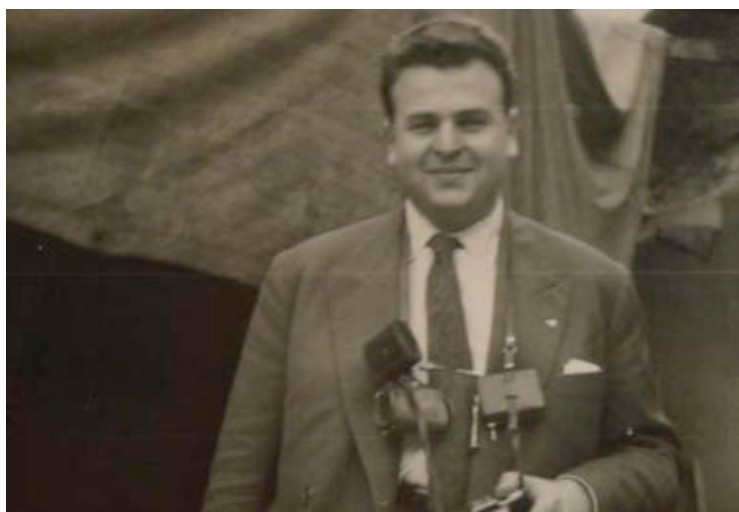
Ill. 242 Jean-Louis Sarf sur le chantier du 85, rue Jouffroy dans le XVII e arrondissement de Paris. L'ingénieur-conseil d'Édouard Albert est alors âgé de 27 ans. Sans date [vers 1955]. ALB_30.5.
