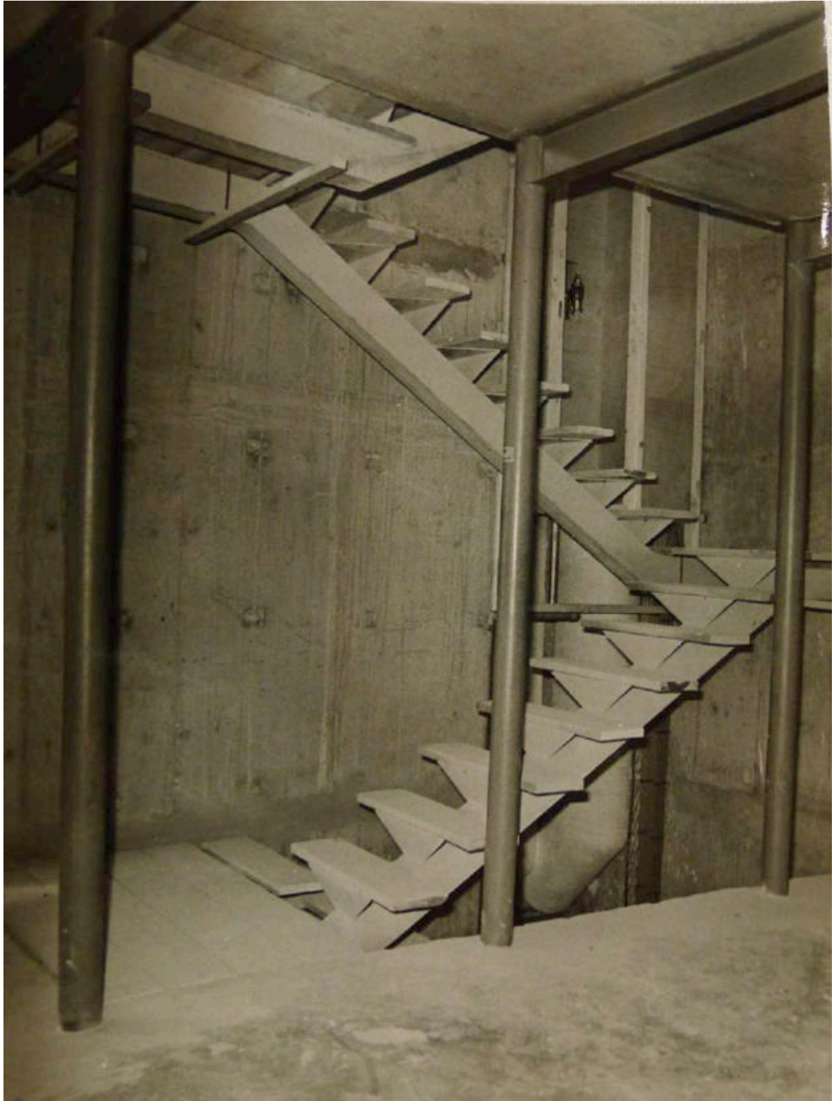
III. 461 Structure tubulaire métallique et escalier préfabriqué des bureaux d'Air France à Orly. Sans date [vers 1960]. ALB_40.2.
