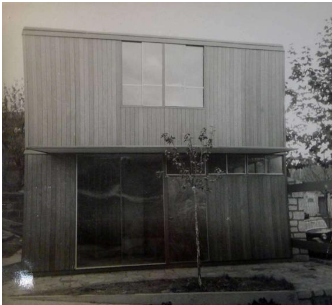
III. 80 « Bureaux Fakler » (Montreuil). Entrée donnant sur l'escalier hélicoïdale. Finesse du plancher [avec auvent dans le prolongement] et fenêtre horizontale signalent la légèreté de cette construction préfabriquée. Sans date [1948]. ALB_18.
