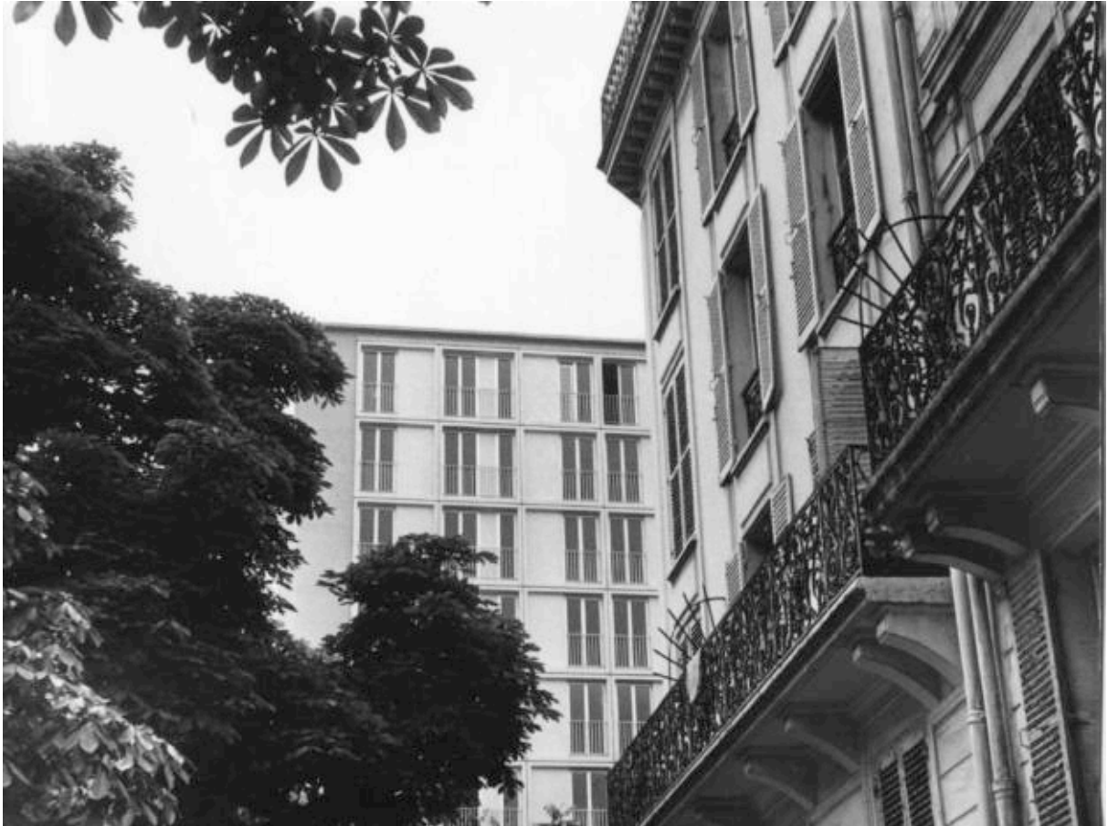
III. 921 « Immeuble d'habitation 27-29 avenue Parmentier » [Légende au verso]. Sans date [vers 1969]. Archives François Maroti, non coté.
