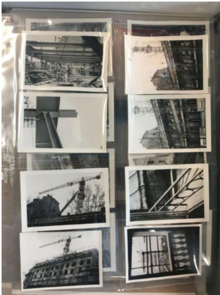
III. 519 Photographies du chantier de surélévation 49, avenue Hoche, Édouard Albert architecte. Sans date [vers 1963]. ALB_42.
