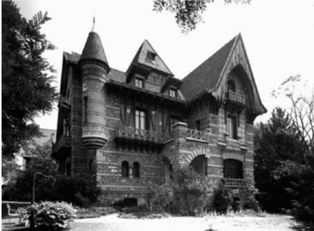
Ill. 169 Maison dite « Hautes rives », à l'angle rue des Côtes, rue Johnson, Maisons-Laffitte (Yvelines). Construite au début du XX e siècle, cette réalisation pittoresque présente une couverture complexe avec plusieurs pans comprenant des ruptures de pentes et des baies. Source : Base Mérimée http://www.culture.gouv.fr/documentation/memoire/HTML/IVR11/IA00064685/index.htm
