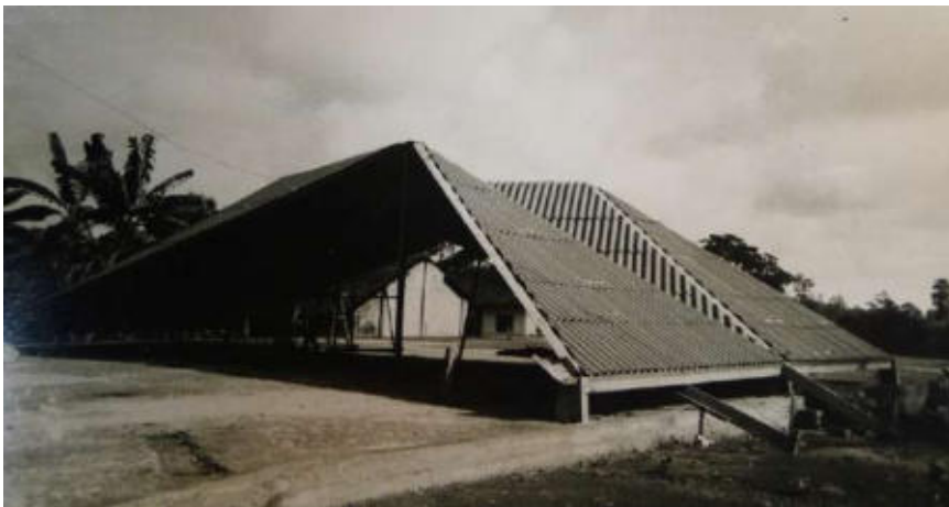
III. 688 « Église d'An-Loc ». Essai de couverture en tôle ondulée. ALB_38.
