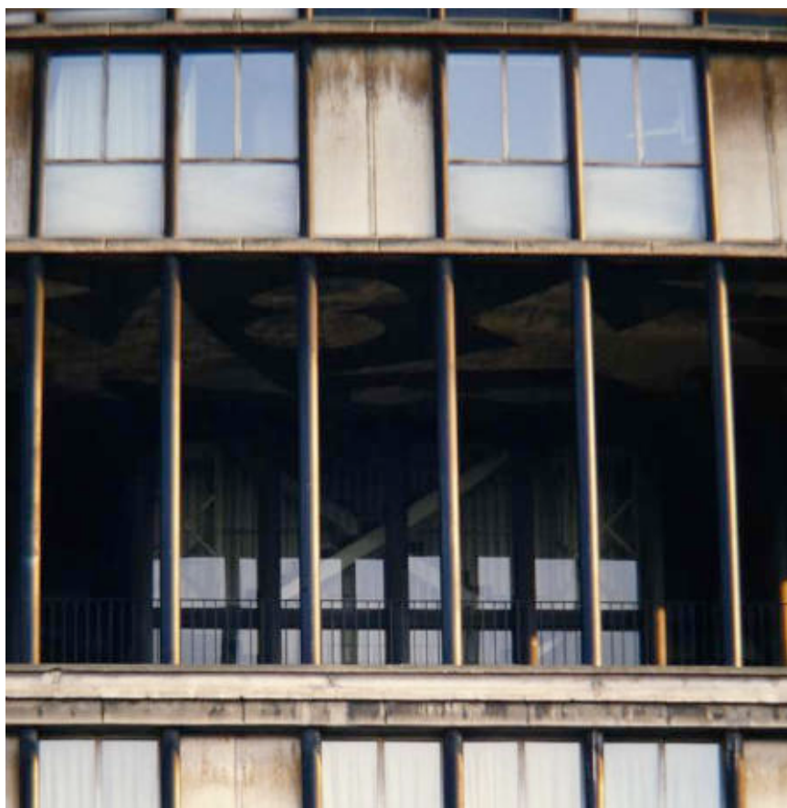
Ill. 592 Détail de la « Tour Albert » au début des années 1990. Les tôles ondulées des panneaux présentent d'importantes traces d'oxydation. Le béton gris des nez de dalle est recouvert de stries noires. On distingue aussi, derrière l'escalier, la cloison opaque en carreaux de plâtre. Très encrassée, la composition de Lagrange est devenue presque illisible. L'œil s'attache plus aux outrages du temps qu'à la qualité architecturale. [Cliché d'Anne Albert-Coutine ?], sans date [vers 1990]. ALB_35.
