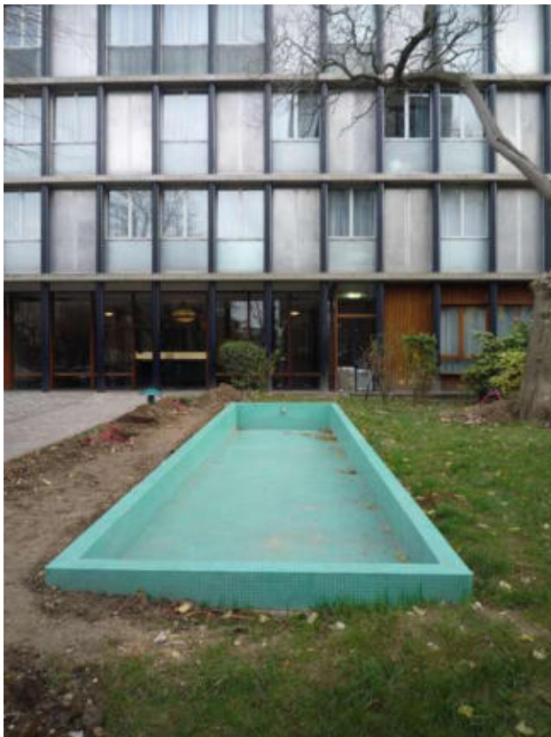
Ill. 587 Restauration du bassin et des lumières du jardin lors de la campagne de travaux de 2017-2018. Cliché d'Arnaldo Coutine, décembre 2018.
