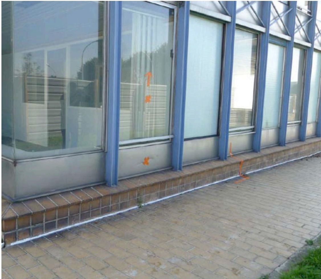
Ill. 624 Abords du bâtiment en brique soulignant la volonté d'Albert de contextualiser son édifice avec la chaufferie en brique, située de l'autre côté de la route. Les marques orange correspondent à un projet de conservation d'une travée. Cliché de l'auteur, septembre 2013.
