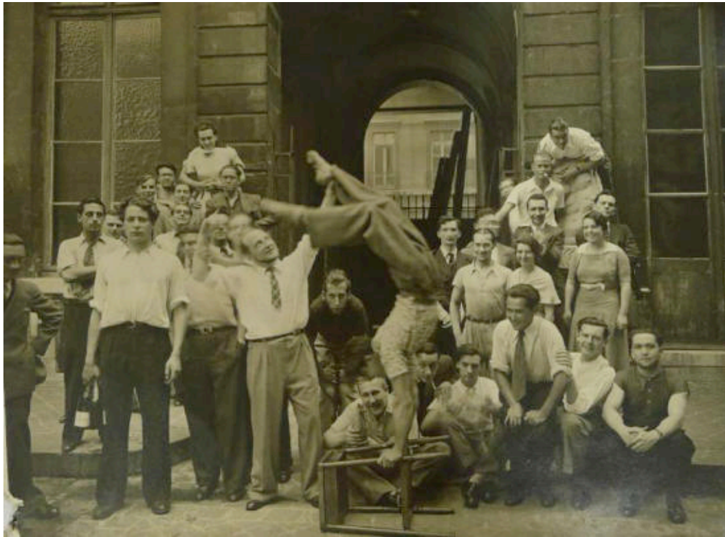
III. 10 Photographie intitulée « Construction 1935 » au verso. Édouard Albert est à droite, juste au-dessous de l'homme à la cigarette. ALB_1.
