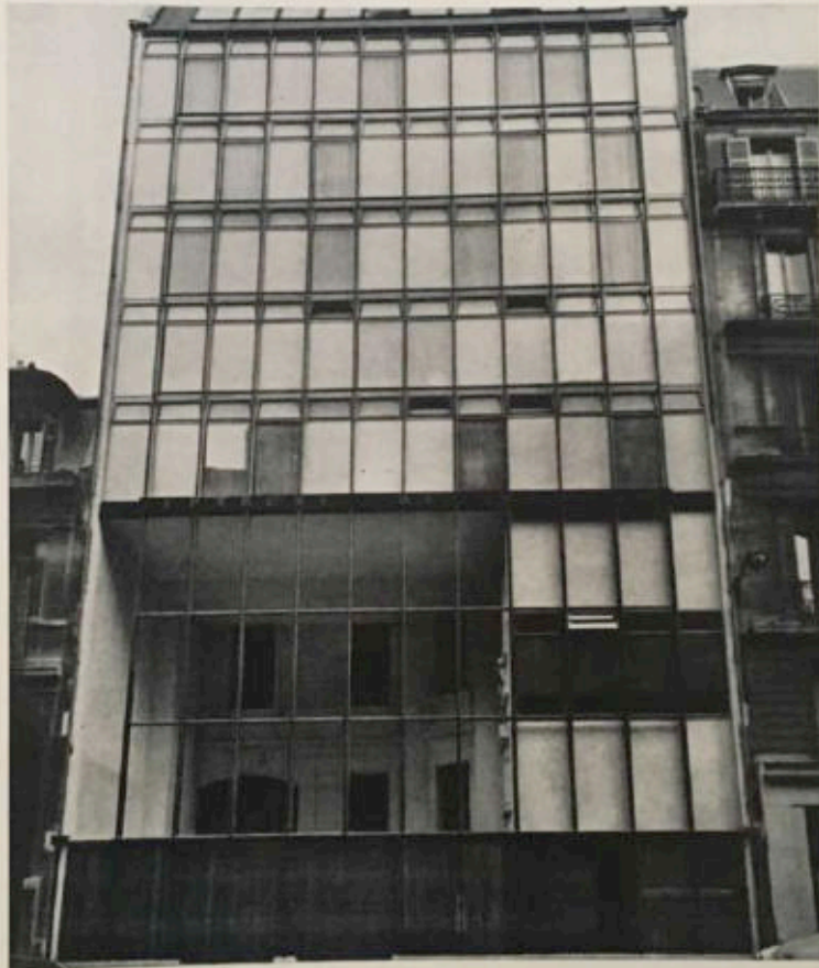
IMMEUBLE EN TUBES, 85, RUE JOUFFROY, A PARIS Architecte : M. Édouard ALBERT. • Ingénieur conseil : M. Jean L. SARF
