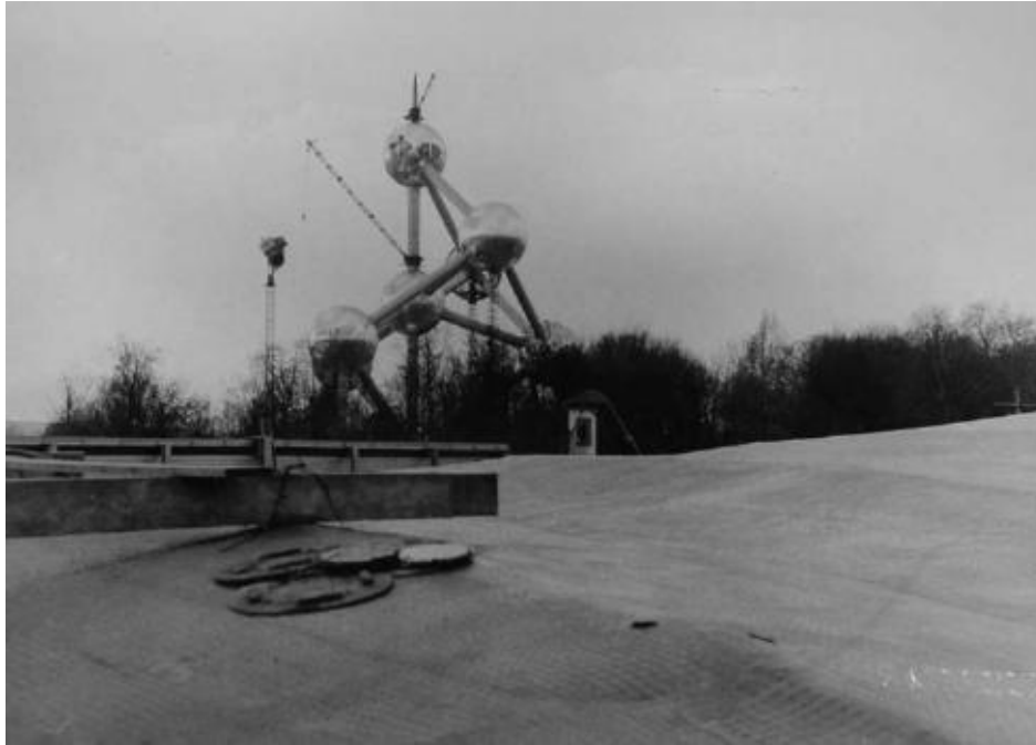
Ill. 631 « Toiture du Pavillon de la Ville de Paris – Bruxelles – Expo 1958 », étanchéité en « Cocoon ». Cliché probablement pris par Édouard Albert lors de sa visite fin 1957 à Bruxelles. Au second plan, l'Atomium en cours de construction. ALB_41.1.
