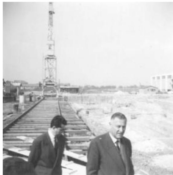
III. 408 « AFBA ». Mise en place du chemin de grue [Au premier plan, Max Hymans (?) visitant le chantier]. Daté au verso 21 avril 1959. ALB_40.2.
