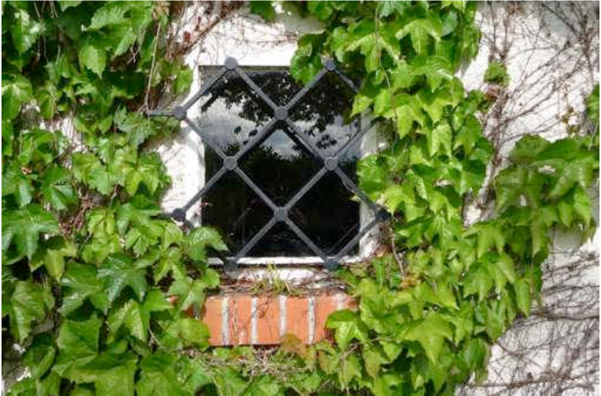
Ill. 56 Maison de week-end de la famille Frey. Polychromie, détail des baies avec appuis en briques rouges et grilles en fer forgé. Photographie de l'auteur, juin 2013.
