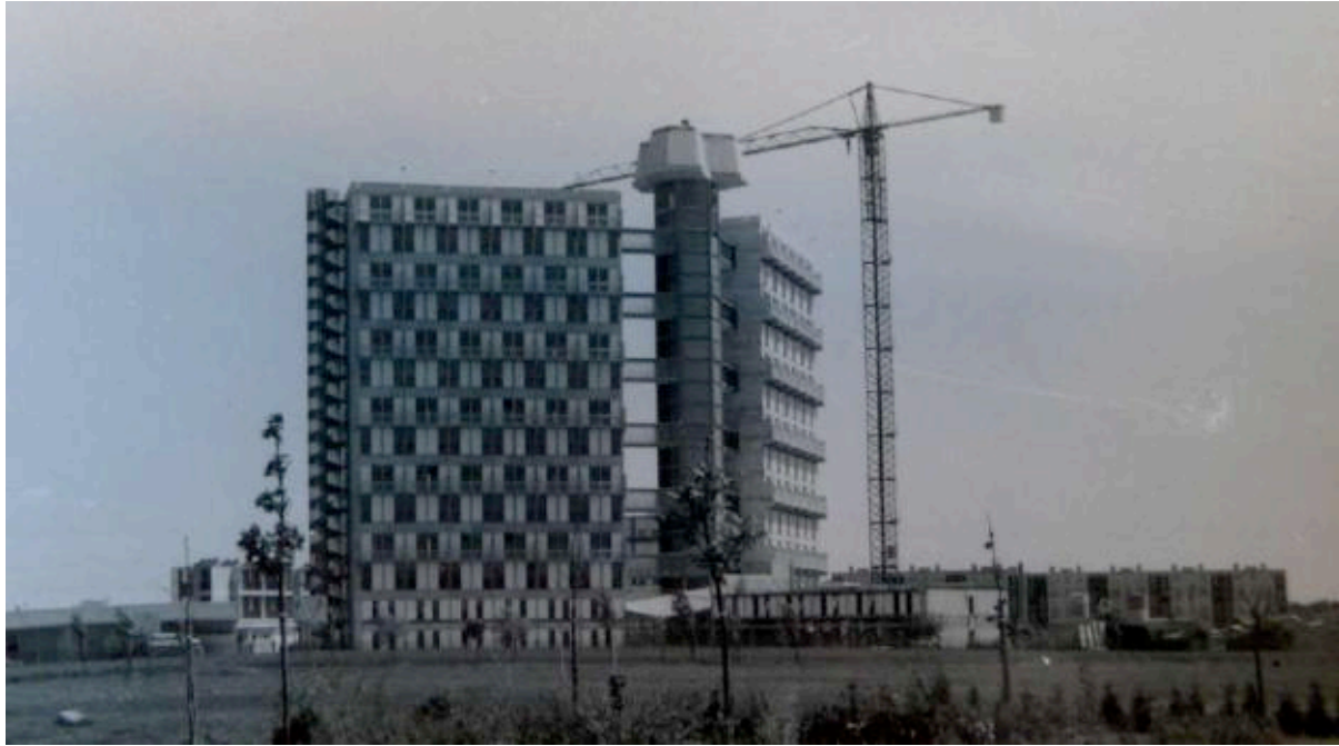
III. 905 « Résidences Plein Ciel ». On distingue nettement la « rue verticale » desservant les barres de logements. Sans date. ALB_50.2.
