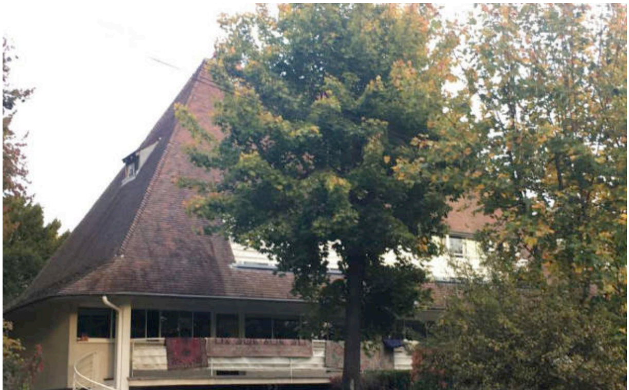
Ill. 170 « Maison Pillois » (Maisons-Laffitte). État de la maison en octobre 2017. Cliché de l'auteur.
