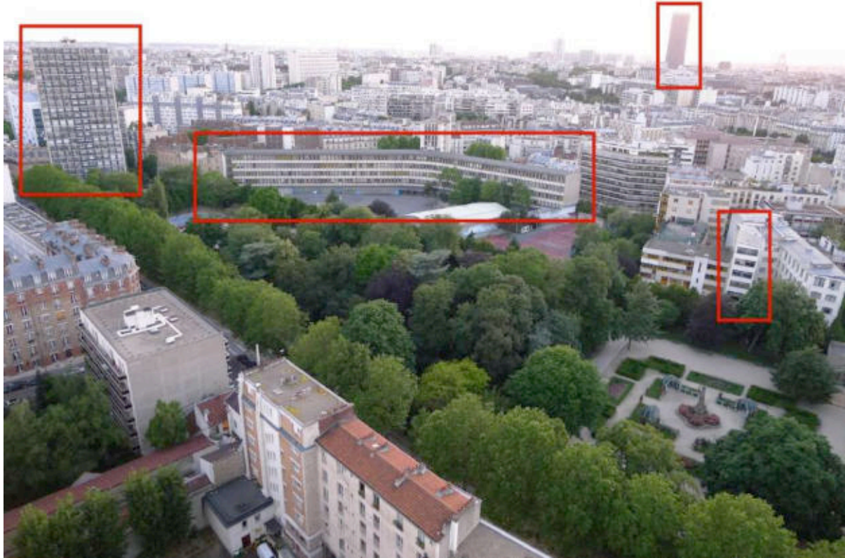
III. 282 Vue du Square René Le Gall depuis le sommet du « Gratte-ciel n°1 ». De gauche à droite : Tour d'Abro Kandjian, collège et lycée Rodin, au loin, la tour Montparnasse et en bordure du square les dortoirs de l'Armée du Salut par Le Corbusier. Cliché de l'auteur, juin 2013.
