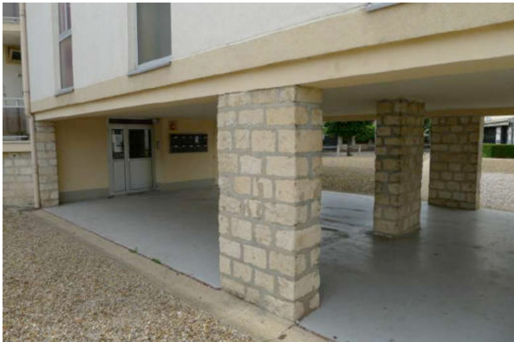
III. 239 Lotissement « Tricorne » (Vernouillet). Soubassement en maçonnerie traditionnelle. Bandeau de béton en jaune clair (précédemment vert) et panneaux peints en blanc cassé. Cliché de l'auteur, juin 2013.
