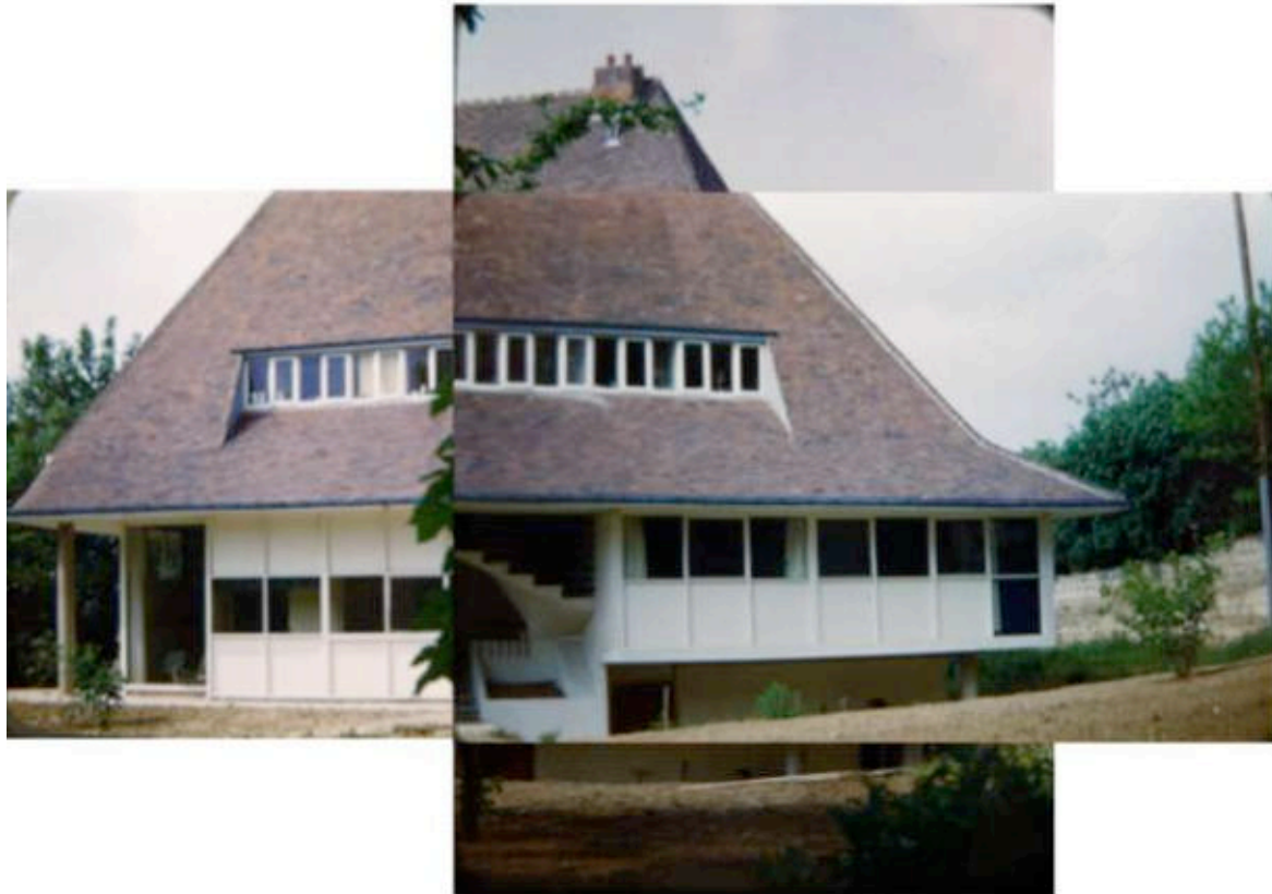
Ill. 167 « Maison Pillois » (Maisons-Laffitte). Façade nord-est donnant sur le jardin. Montage photographique réalisé par l'auteur à partir de diapositives couleur du chantier [L'absence de recul et la déclivité du terrain ne permettent pas de prendre une vue d'ensemble. En l'absence de plans, ce montage permet de mieux appréhender le projet]. ALB_25.
