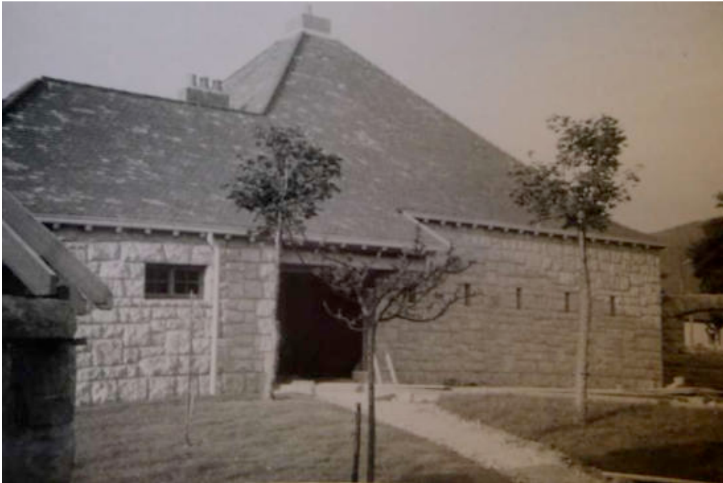
Ill. 144 « Maison Verchère » (Oyonnax). Mur massif en maçonnerie traditionnelle, ouverture sur la piscine. Sans date [1949]. ALB_23.2.
