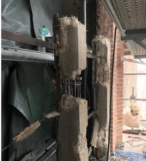
210 Démolition du remplage en ciment armé d'origine, doublé en béton armé banalisé dans les années 1930. Photo : 1090 architectes.
