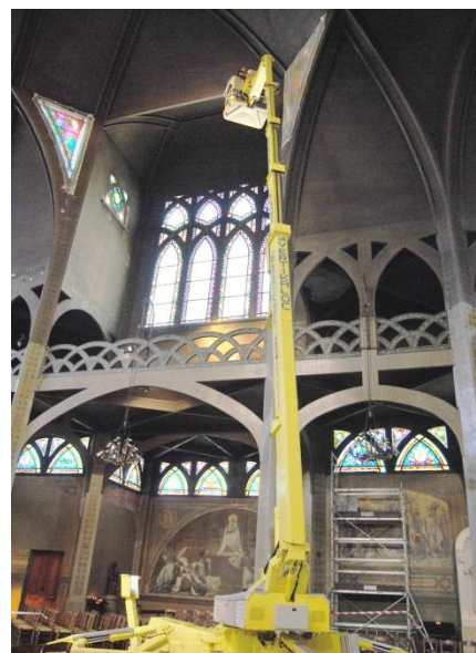
206 Diagnostic visuel à l'aide d'une nacelle. Photo: l'auteur, 2016.
