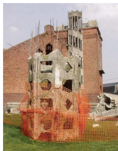
223 Un fragment de la tour centrale du clocher en béton armé lors de la démolition. Photo : Lionel Dubois / DRAC Nord-PC, 2002.
