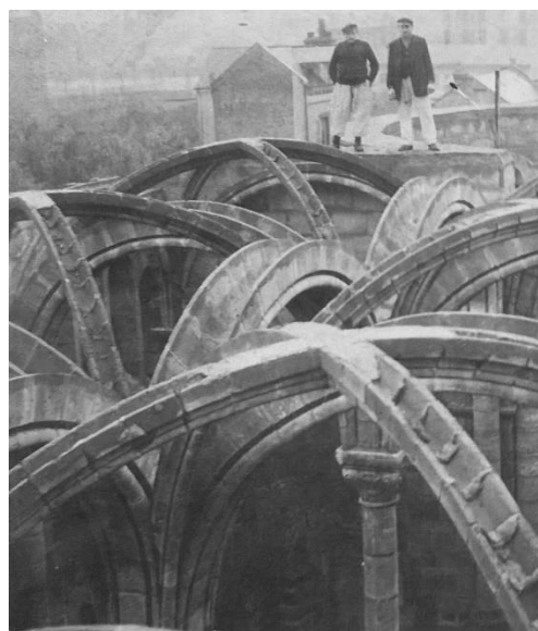
100 Sainte-Jeanne-d'Arc, Saint-Denis. Vue des arcs en pièces préfabriquées avant la construction des voûtes. Le Christ dans la banlieue , N° 4, 1932.
