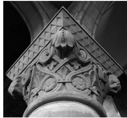
105 Chapelle dominicaine, Strasbourg. Chapiteau en béton moulé. Photo : l'auteur, 2018.
