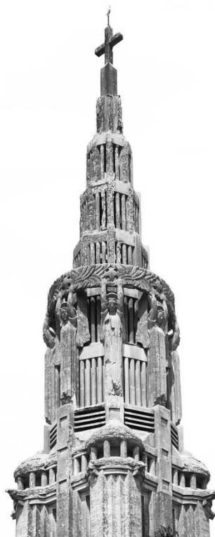
57 Saint-Martin, Martigny-Courpierre. Clocher à anges sculptés en béton. Photo : l'auteur, 2023.
