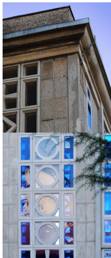
216 Reconstitution du béton à l'angle nord-est. Claustras restitués en façade nord. Photo : l'auteur, 2013.
