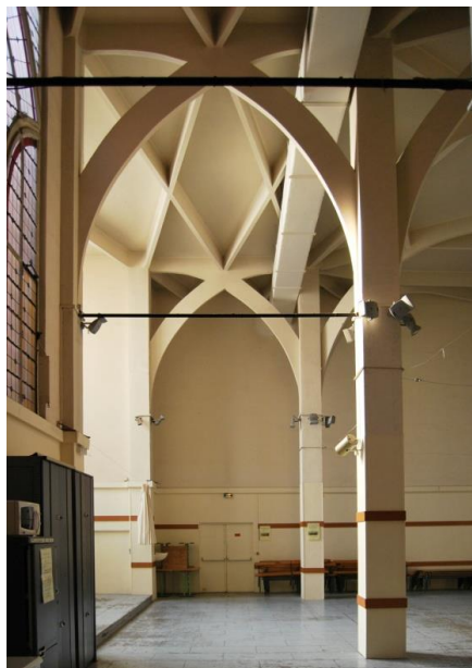
205 Les réseaux modernes dans le monument historique. Église basse : gaine d'air, éclairage. Photo: l'auteur, 2012.
