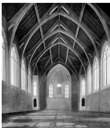
79 Sainte-Jeanne d'Arc, Lunéville. Vue de la charpente en béton armé avant la construction de la voûte en berceau. brisé. Le Béton armé , août 1913.
