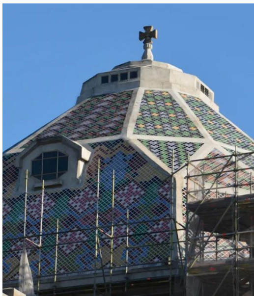
221 SaintChrysole, Comines. Travaux de restauration en cours sur le dôme principal. Photo : M. Sence, 2014.
