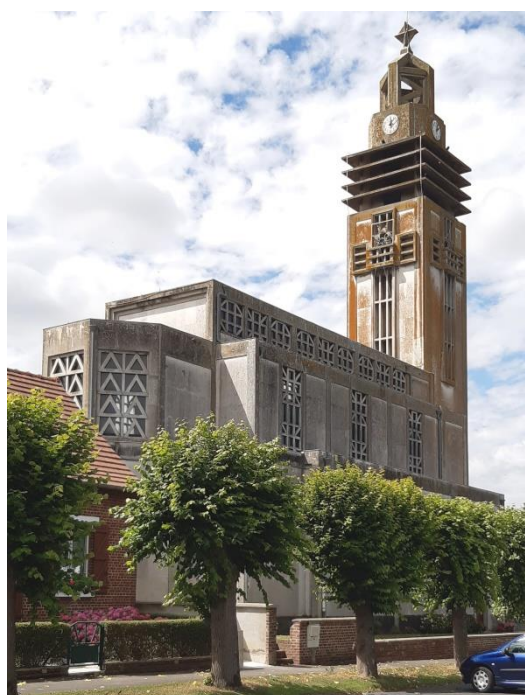
132 Saint-Géry, Brie. Vue générale (nord-est). Photo : l'auteur, 2023.
