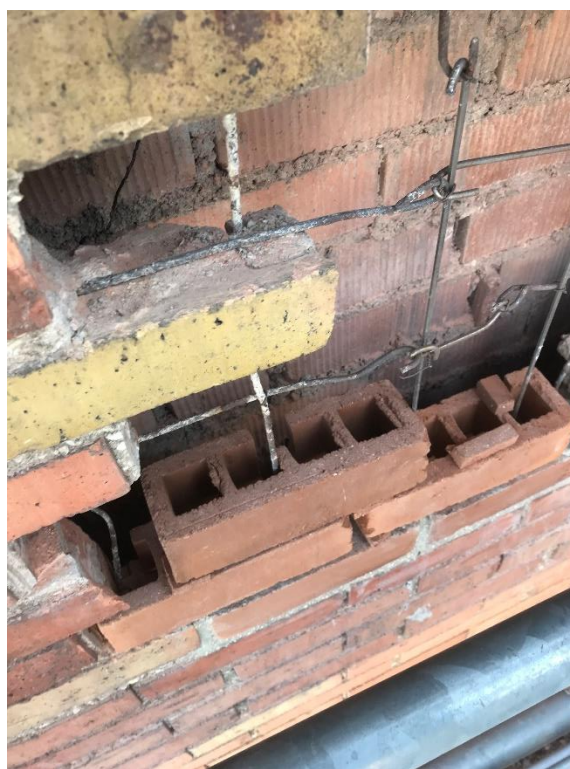
209 Restauration des murs en brique armée. Après la purge, les nouvelles briques creuses doivent être découpées afin de s'insérer dans le réseau d'armatures. Photo : 1090 architectes.
