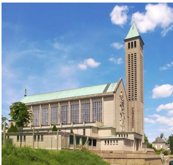
137 Notre-Dame-de-la-Trinité, Blois. Vue générale (sud-ouest). Photo : l'auteur, 2015.
