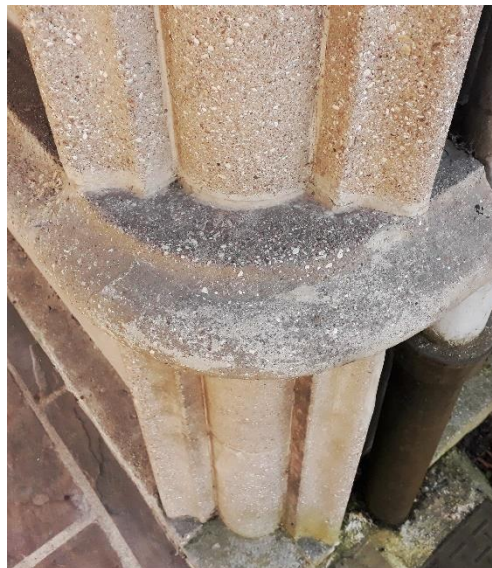
90 Notre-Dame, Rungis. Détail d'angle réalisé selon le brevet 401.478. Photo: l'auteur, 2017.
