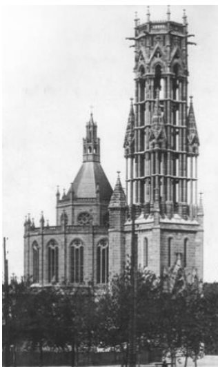
1 Sainte-Cécile du Havre. Le clocher en blocs préfabriqués de béton avant 1944. Carte postale, s.d.
