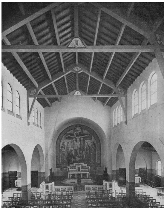
16 Saint-François-d'Assise, rue Mouzaïa, Paris. Charpente en béton armé. La Construction moderne , N° 32, 1932.
