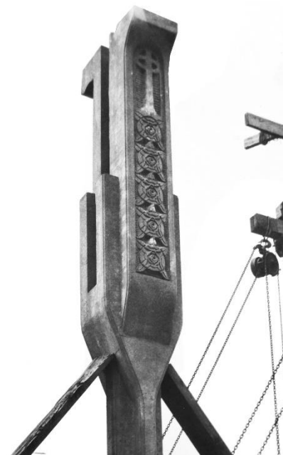
112 Saint-Christophe-de-Javel. Chapiteau d'un pilier pendant les travaux. CAAC. BESCH-G-20. 093 IFA.
