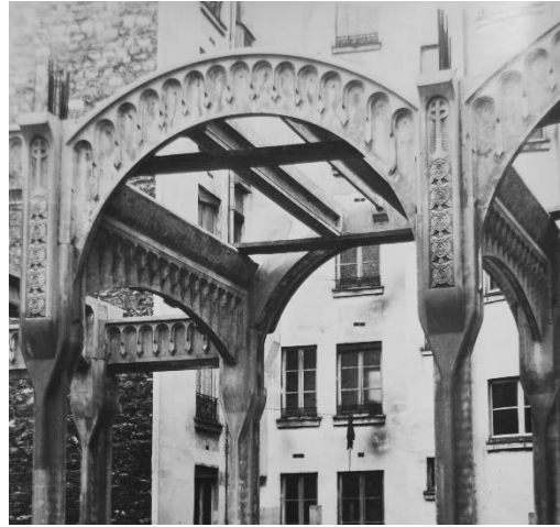
114 Saint-Christophe-de-Javel. Arcs et entretoises pendant les travaux. CAAC. BESCH-G-20. 93 IFA 54/7.
