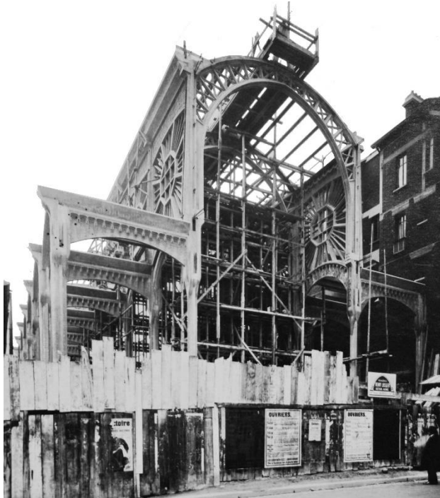
111 Saint-Christophe-de-Javel. Vue de l'ossature porteuse en ciment armé préfabriqué. CAAC. BESCH-G-20. 093 IFA 54/7.
