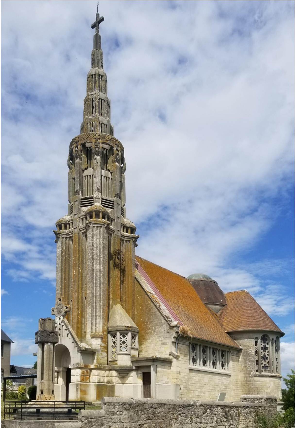
V. Saint-Martin, Martigny-Courpierre. Photo : l'auteur.
