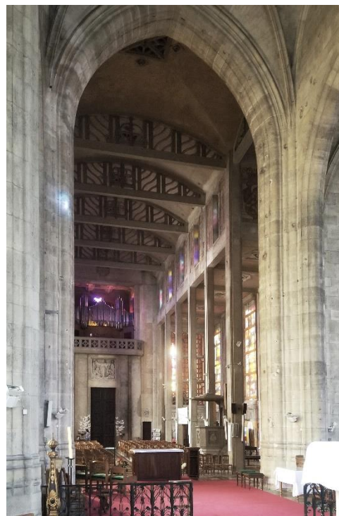
187 Saint-Pierre, Roye. Vue de la nef en béton armé depuis le chœur ancien. Photo: l'auteur, 2023.
