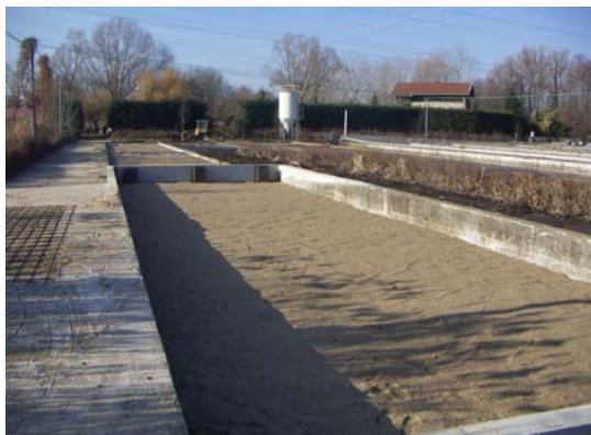
Raceway divisé en trois compartiments pour la construction de trois marais ; plant de Typha sp
