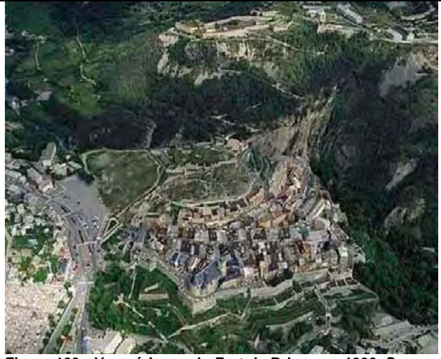
Figure 103 - Vue aérienne du Fort de Briançon, 1992. Source : Revue In Situ , Revue des Patrimoines [En ligne]. URL : http://insitu.revues.org/8555 (consulté le 18/09/2014)
