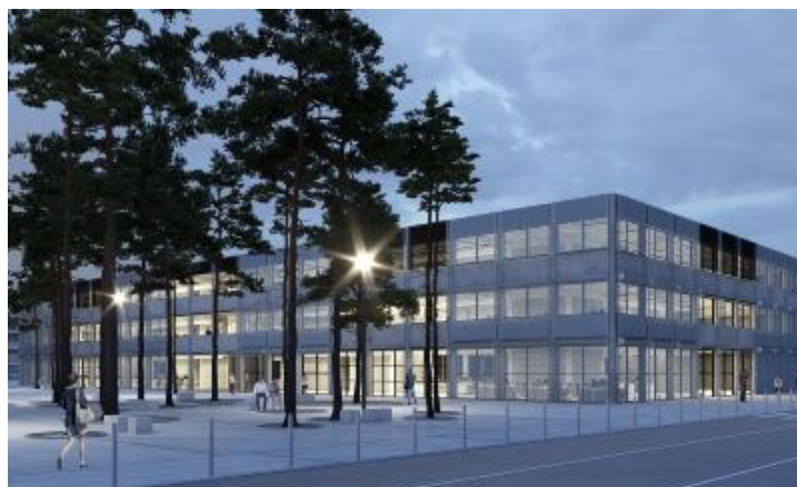
Figure 5. 38 Simulation de la Halle de l'innovation, « La halle de l'innovation sort de terre à Cambacères », Montpellier3m , 26 décembre 2019 (en ligne, consulté le 10 juillet 2023), https://www.montpellier3m.fr/actualite/la-halle-de-linnovation-sort-de-terre-cambaceres
