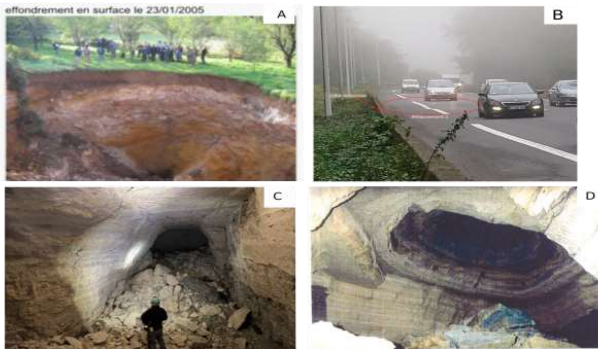
Figure 2 Photographie de remontée de fontis dans le gypse. (A) Effondrement de fontis à Roquevaire (13) (Cerema, 2018). (B) Affaissement de la chaussée de l'A15 (CEREMA, 2021). (C) et (D) Remontée de fontis en région parisienne (Lecomte, 2022) et (Direction régionale de l'industrie, de la recherche et de l'environnement, 1995)
