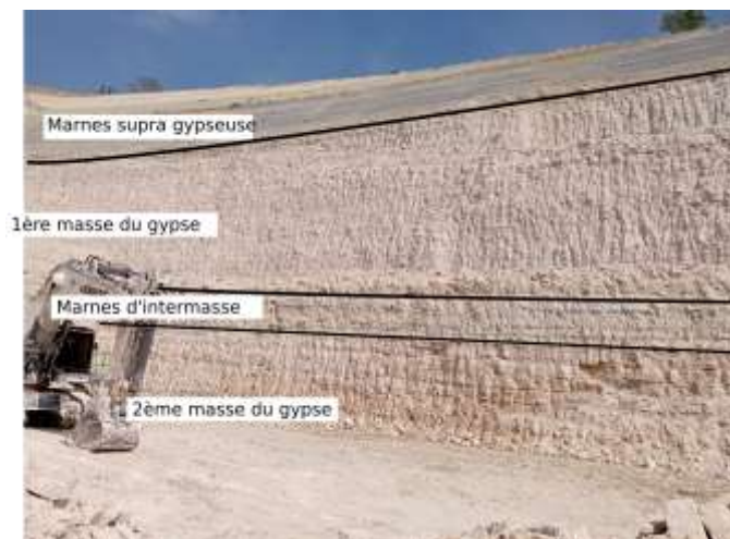
Figure 86 Front de taille dont sont issus les blocs du Priabonien
