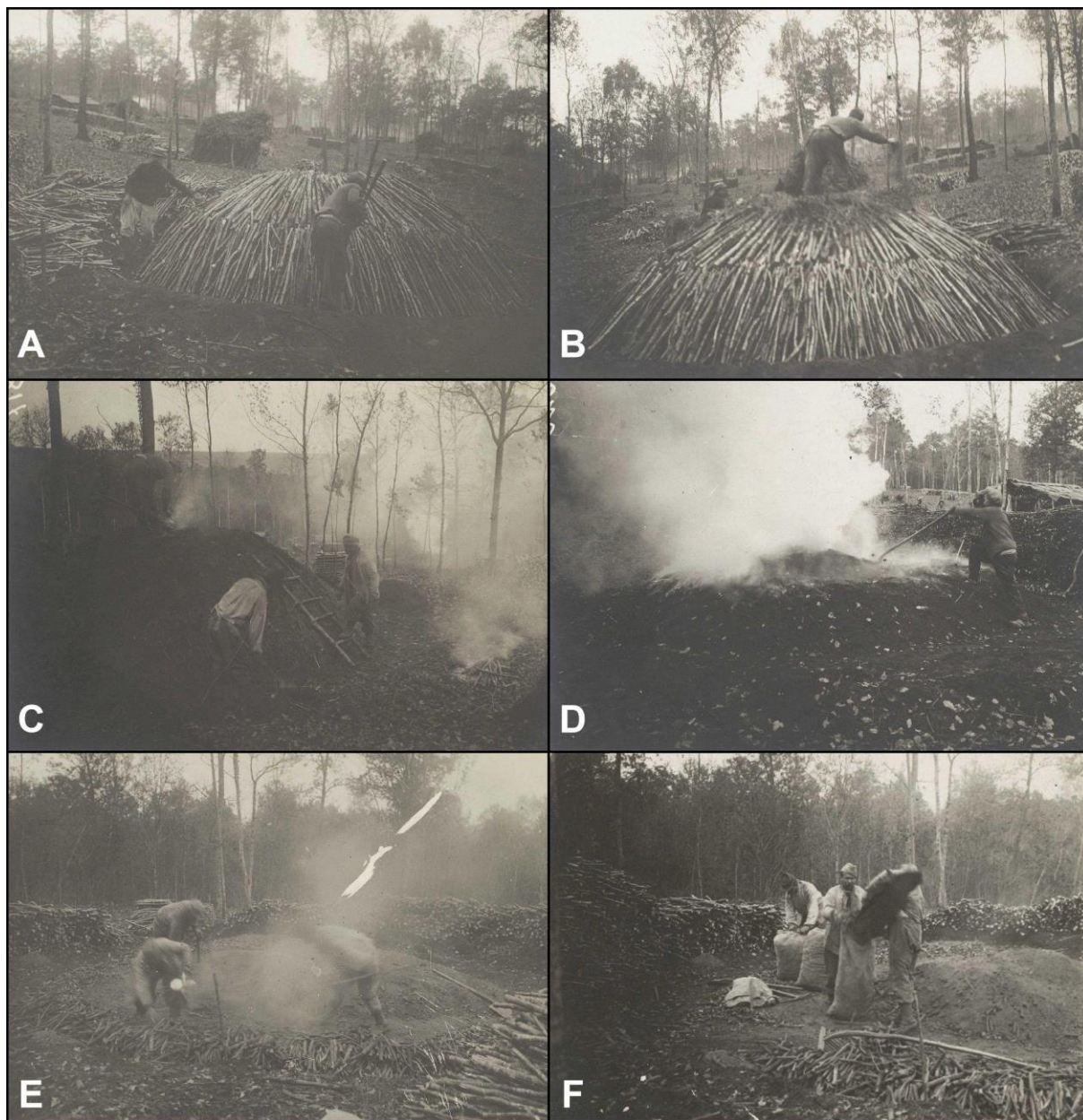
Fig. 3.76 : Reportage photographique sur la fabrication de charbon de bois en 1917 à Pourcy (données : La Contemporaine [VAL 078/ 102, 103, 104, 106, 108, 109]). A. Construction d'une meule ; B. La meule est couverte d'herbes ; C. Allumage de la meule ; D. Meule en ignition ; E. Le charbon est retiré de la meule éteinte ; F. Le charbon de bois est mis en sac.
