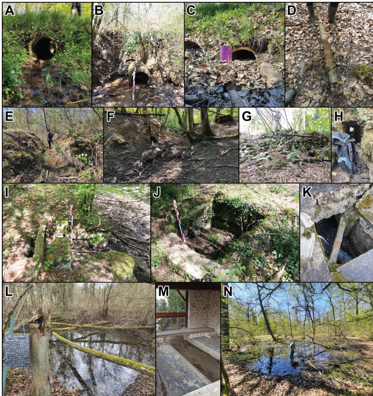
Fig. 3.57 : Exemples d'ouvrages hydrauliques.
