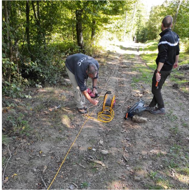
Fig. 2.14 : Installation du matériel de tomographie électrique. Raccordement des électrodes au fil de la bobine déjà en place.
