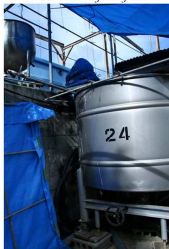
Cuve n°2 : eau et 9 kg de calcium - mélanger 30 min
