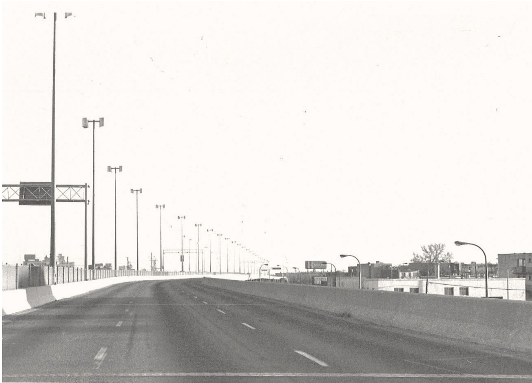
1. Vue d'un segment aérien du boulevard Métropolitain, tronçon urbain de l'autoroute transcanadienne n°40, surplombant les habitations du quartier Saint-Michel, à Montréal. Photographie André Lortie, 1979.
